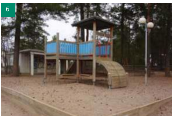
Hiekkapihan ja asfalttipihan rajapintaa on tuettu paikoin vaakalautaseinämällä. Kuvassa näkyy Lappset-kiipeilyteline ja pihavalaisin. Taustalla välinevarasto.
