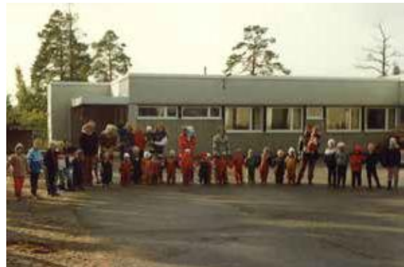
Ulkokuva vuodelta 1979. Taustalla näkyy seimiosaston sisäänkäyntikatos ennen myöhemmin tehtyjä muutostöitä. LPYA.
