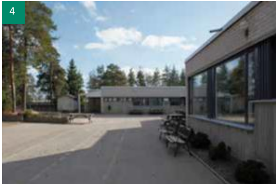
Päiväkodin asfalttipihanäkymä kohti eteläsiipeä. Rakennuksen sokkelin edustalla on kapea soravyöhyke, jolle on muutama vuosi sitten istutettu uudet pallokatajat.
