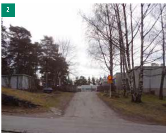
Päiväkodin etupihalle nouseaan Köökarinpolulta loivaa asfalttoitua rinnettä pitkin. Pihaa reunustaa maalaamaton betonimuuri, jossa on rautaportit. Rakennuksen pohjoispääty jää osittain aidatun alueen ulkopuolelle. Oikealla kasvaa rauduskoivuja. Vasemmalla ovat varastorakennuksen jätehuonepääty sekä pyöräparkki.
