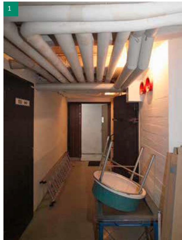
Rakennuksen pohjoissiiven pohjoisosassa on kellari, jossa on väestösuoja, sähköpääkeskus, LVI-laitteita sekä varastoja.
