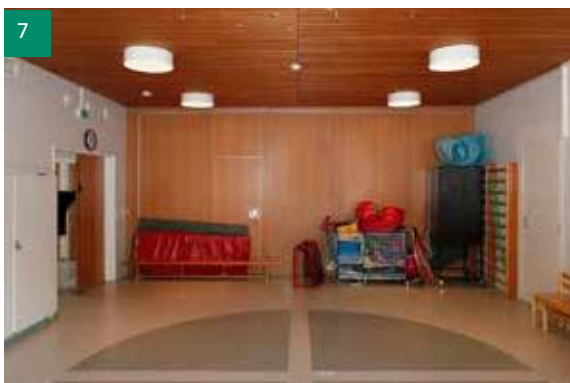
Laulu- ja leikkisaln vinyylimatto on kuvioitu. Taustalla näkyvä tammiviilupintainen ovellinen siirtoseinä rakennettiin 1993 alkuperäisen haitarioven paikalle.
