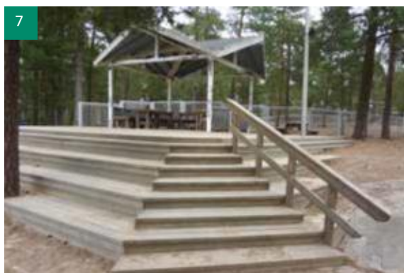
1990-luvun peruskorjauksessa hiekkapihalle lisättiin myös teräsrunkoinen ulkopaviljonki, johon liittyy puinen terassi ja portaat. Paviljongissa on pöytä ja kiintopenkit ja se on hyvä sadepäivän leikkipaikka.
