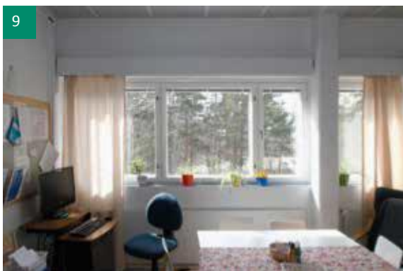
Opettajainhuoneen ikkunat avautuvat länteen. Seinällä on nauhaikkunoita ja kattoa kannattavat teräsbetonipilarit.
