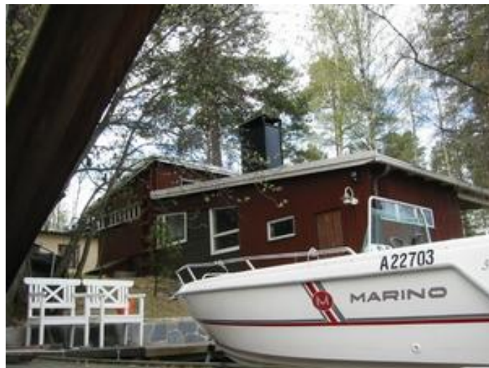
Kuva: Tontin rannassa sijaitseva saunarakennus, arkkitehti Einari Teräsvirta 1954 (lähde: Kaupunginmuseum, Munkkiniemen rakennusinventointi, Tmi Hilla Tarjanne).
