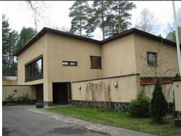
Kuva: Tontilla sijaitseva asuinrakennus, arkkitehti Einari Teräsvirta 1957 (lähde: Kaupunginmuseum, Munkkiniemen rakennusinventointi, Tmi Hilla Tarjanne).
