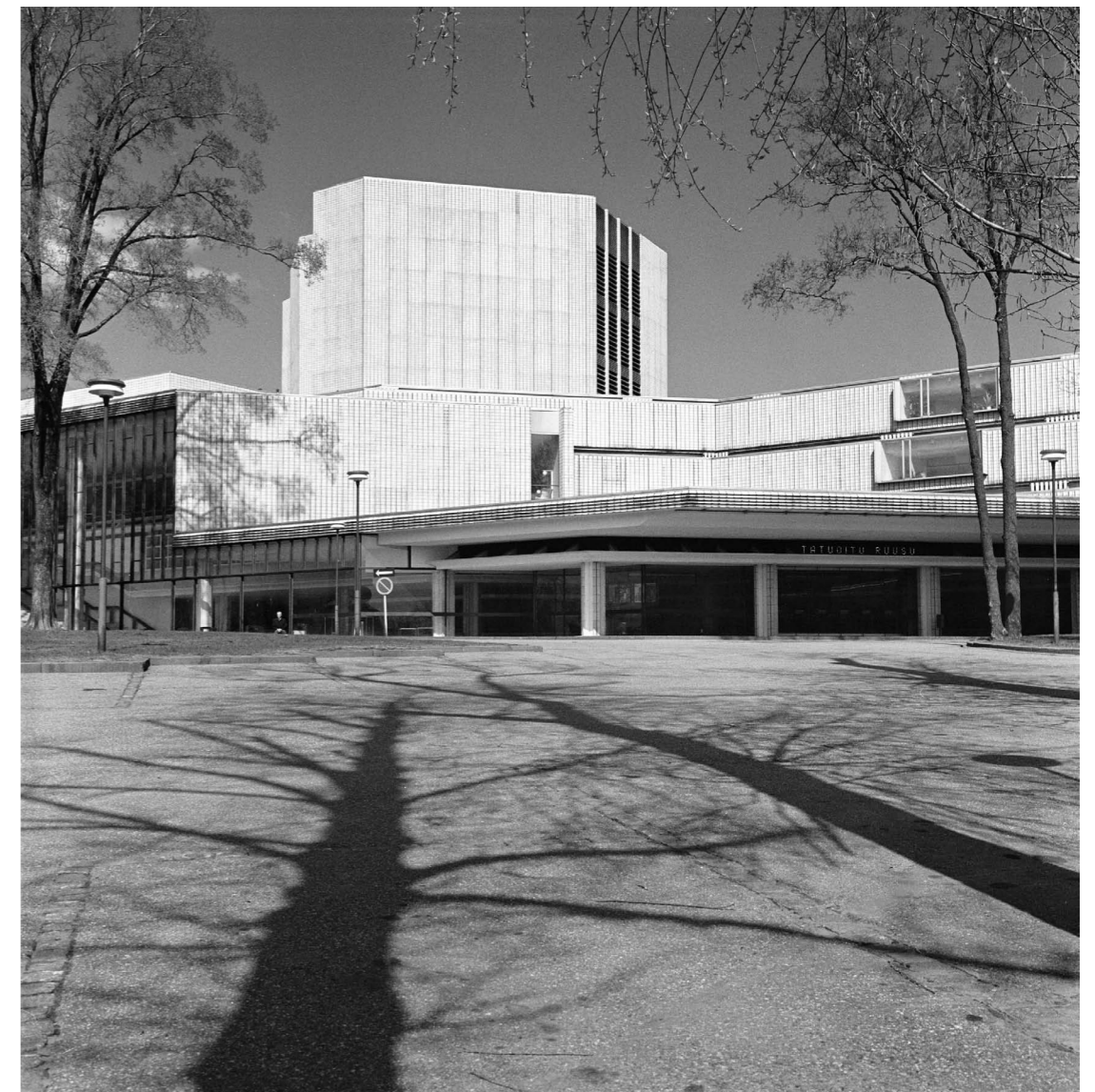
Alkuperäinen viistopysäköintialue. Kuvassa näkyvät graniittireunakivet ja pysäköintiruutujen nupukiviraidat. Keskellä pysäköintialuetta säilytetyt puut näkyvät varjoina. Valok. Volker von Bonin 1988.
