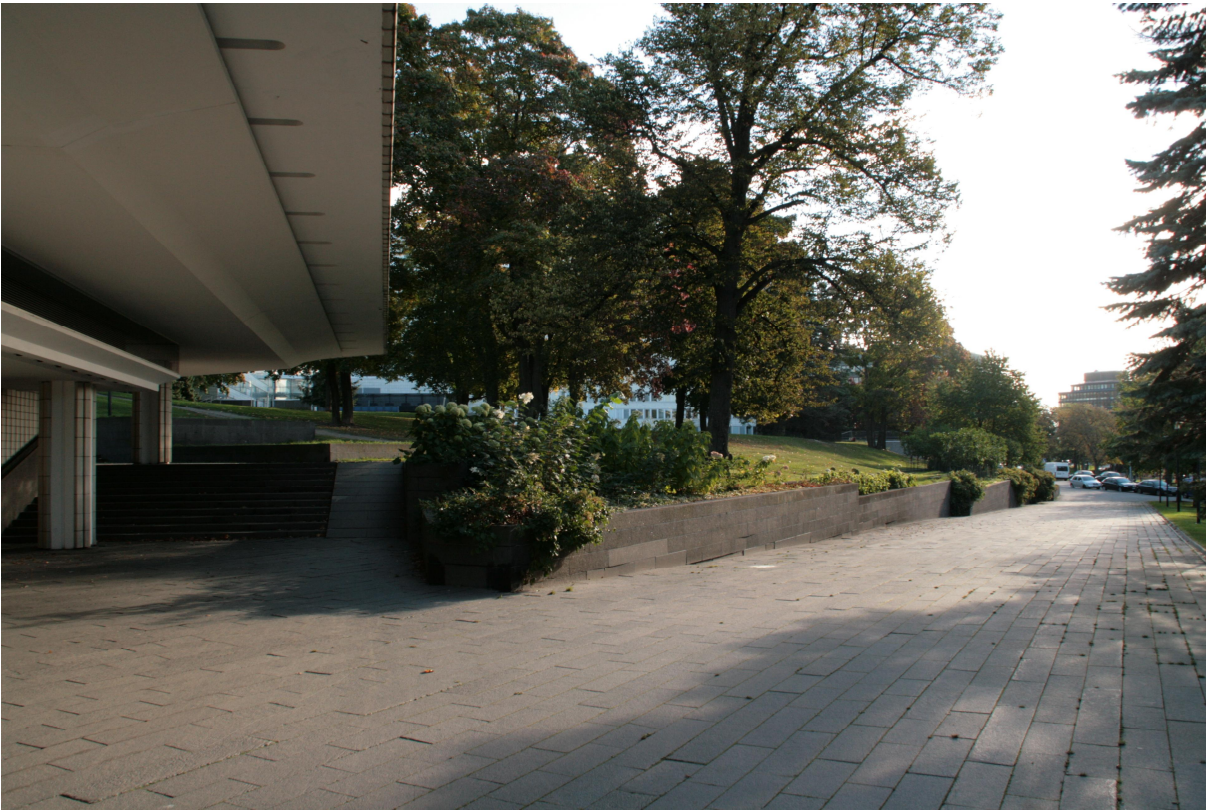
Itäpäädyn ulkoporras ja tukimuuri
