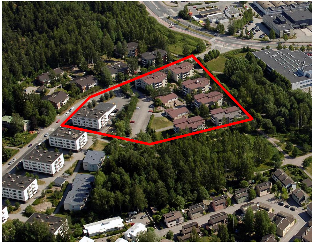
Viistoilmakuva lounaan suunnasta. Kuvan oikeassa yläreunassa Konalantie.
