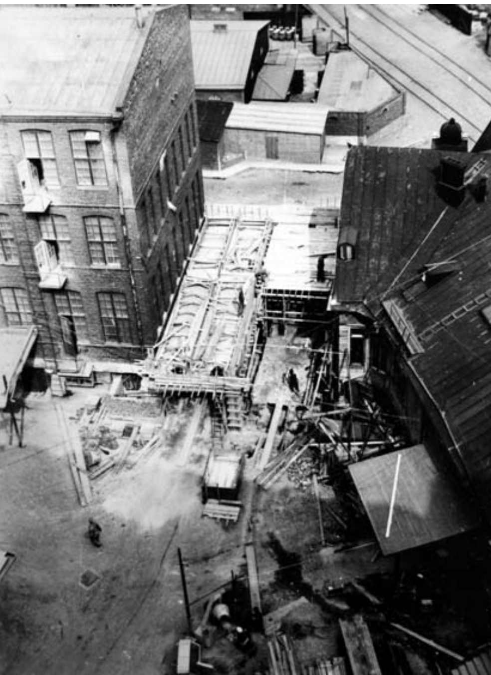
Kauramyllyä rakennetaan elokuussa 1942. Parhaillaan tehdään ensimmäisen kerroksen välipohjan valumuotteja. Kuva on otettu siilorakennuksen katolta. HM
