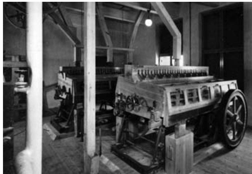
Kauramylyn laitteita 1940-luvulla. Vasemmalla kauran- ja ohrankuorimalaitteita ja oikealla pöytäajittelijoita. Pöytäajittelijoilla eroteltiin kuorimakoneilta tulevasta kaurasta kuoritut ja akanaiset kuorimattomat jyvät toisistaan. Jälkimmäiset siirrettiin uudelleen kuorittaviksi. HM
