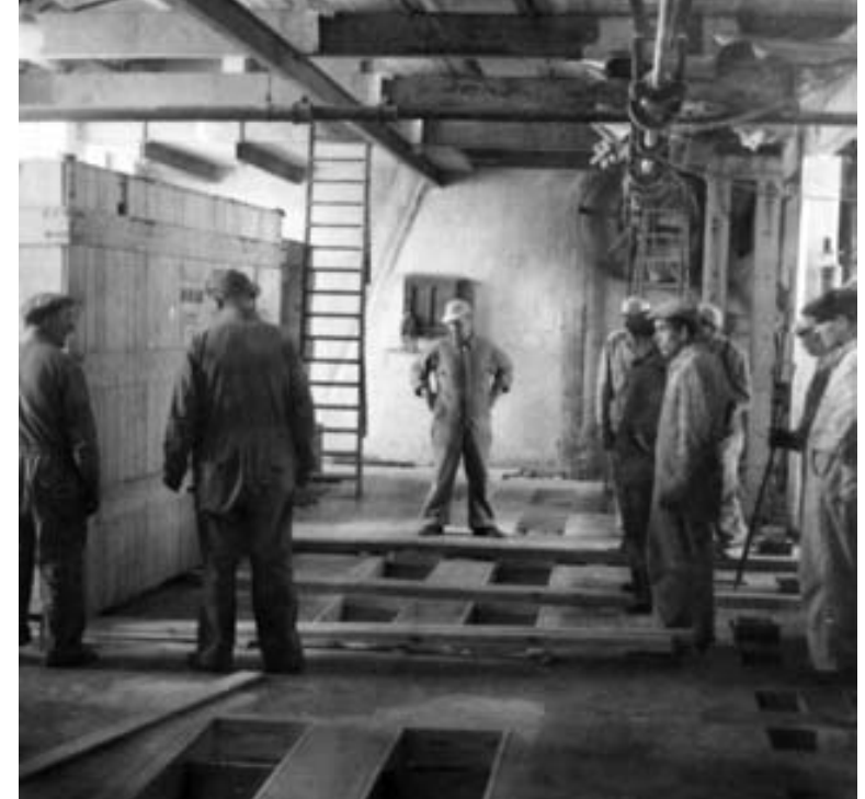
Oik: Myllyn muutostyöt kesäkuussa 1962. Kuva B-osan ylimmästä kerroksesta, josta vanhat tasisihdit on purettu ja uudet odottavat asennusta pakkauslaitteikoissaan. HM
