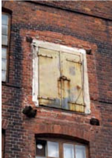
Alla: Puretun yhteyssillan paikka B-osan julkisivussa ja (alinna) kellariin johtava teräsovi. Molemmat on asennettu vuonna 1935.
