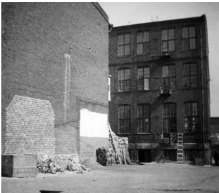
Vas: Läntisen ja keskimmäisen siiven välinen piha vuonna 1935. Taustalla sijaitsevaan välisosaan rakennettiin uusi porrashuone ja henkilökunnan wc-tilat. Pihatason alla oli uusi pannuhuone piippuineen. Vasemmalla puolella olevan läntisen siiven eli myllyn siilojen seinässä näkyy vaaleampia alueina umpeenmuurattuja ikkuna-aukkoja sekä korotusosa. HM
