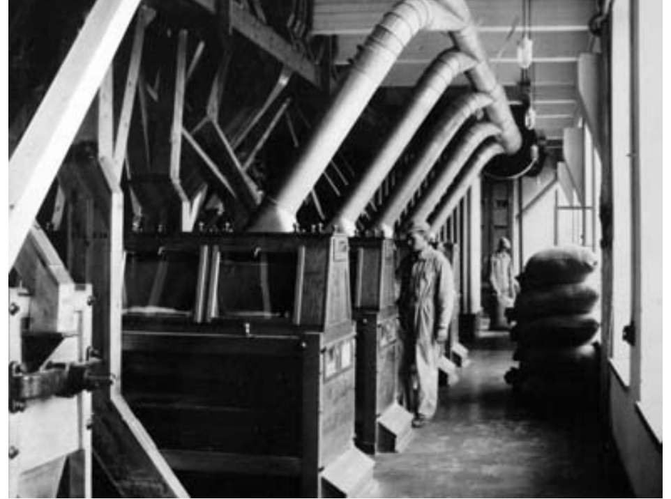
Oik: Raepuhdistuslaitteita B-osan kolmannessa kerroksessa 1930-luvulla. HM
