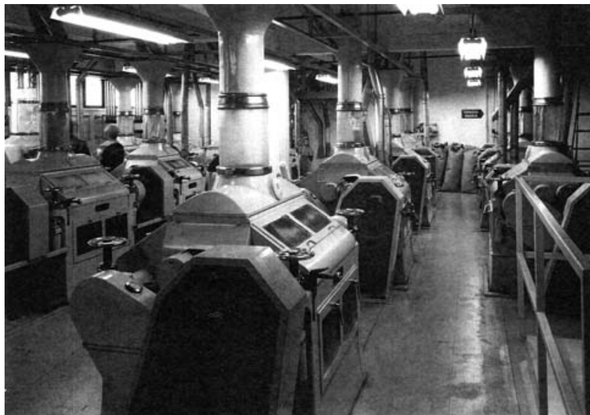
Alla: Valssituoleja entiseen säkkivarastoon rakennetussa uudessa myllyssä vuonna 1983. HKM / Korkman
