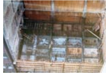
Yllä: Uusia siiloja valetaan vuonna 1969 E-osan pihanpuolelle. HM
