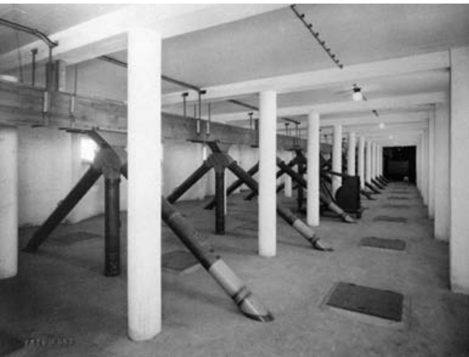
Siilojen yläosan täyttöputkistot vuonna 1942. HM / Foto Roos
