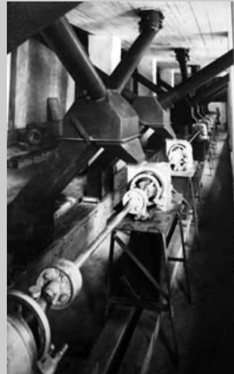
Yllä: Siilojen yläosa täyttöputkineen vuonna 1935. HM
