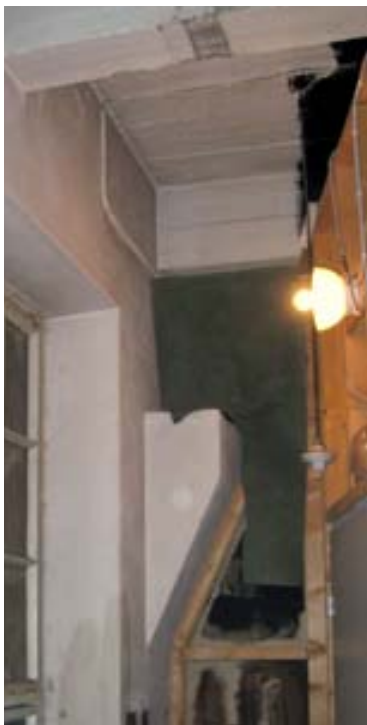
Näyttämörakenteen takaa löytyy vanhat ikkunat sekä nosturikiskolle tarkoitettu tiilikonsoli. Taustalla näkyvä, katosta riippuva valaisimen posliinikanta on asennettu vuonna 1935.
