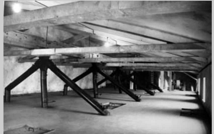
Yllä: Siilojen yläosa täyttöputkineen vuonna 1935. HM
