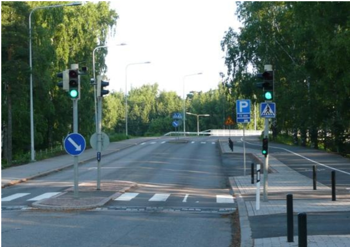
Kuva 39. Koulun saattopysäköintipaikka Professorintieellä (P 15 min). Kohteessa on myös kadunylityksen turvaamista varten tehty korotettu suojatie ja liikennevalot.
