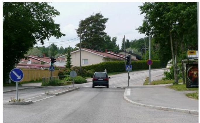
Kuva 35. Pysäkkityyppi, jolla pysähtyvä linja-auto pysäyttää oman ajosuuntansa liikenteen (2 toteutustapaa) (lähde: Vägverket 2004).
