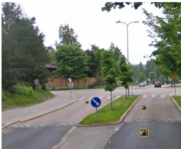
Kuva 11. Kokoojakadun kiertoliittymä Olarinkadun ja Komeetankadun risteyksessä. Liittymäalue on korotettu ja kivetty. (Kuva: Google Earth.)
