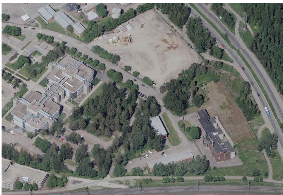
Kuva 2: Alueen viistoilmakuva etelän suunnasta (koottu Pointscene-ilmakuvapalvelun vuoden 2021 ilmakuvista alueelta, Helsingin kaupunki). Kuvassa näkyvät Sähköpolun alue ja sen pohjoispuolinen tyhjä tontti, nykyinen Pitäjänmäen sähköasema sekä Valion pääkonttorirakennus.
