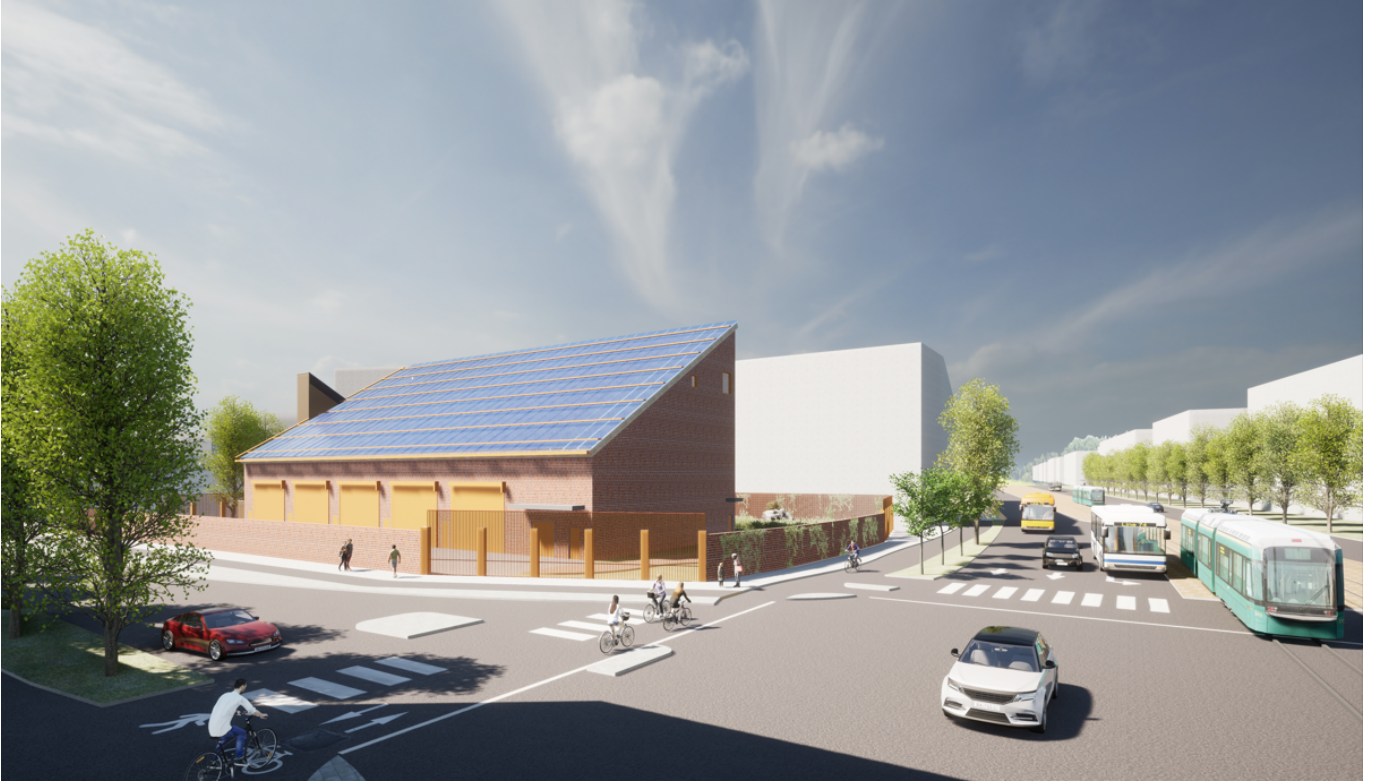
Näkymä sähköasema Vihdintieltä
