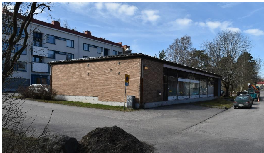
Damaskuksentien varressa sijaitseva purettava liikerakennus.
