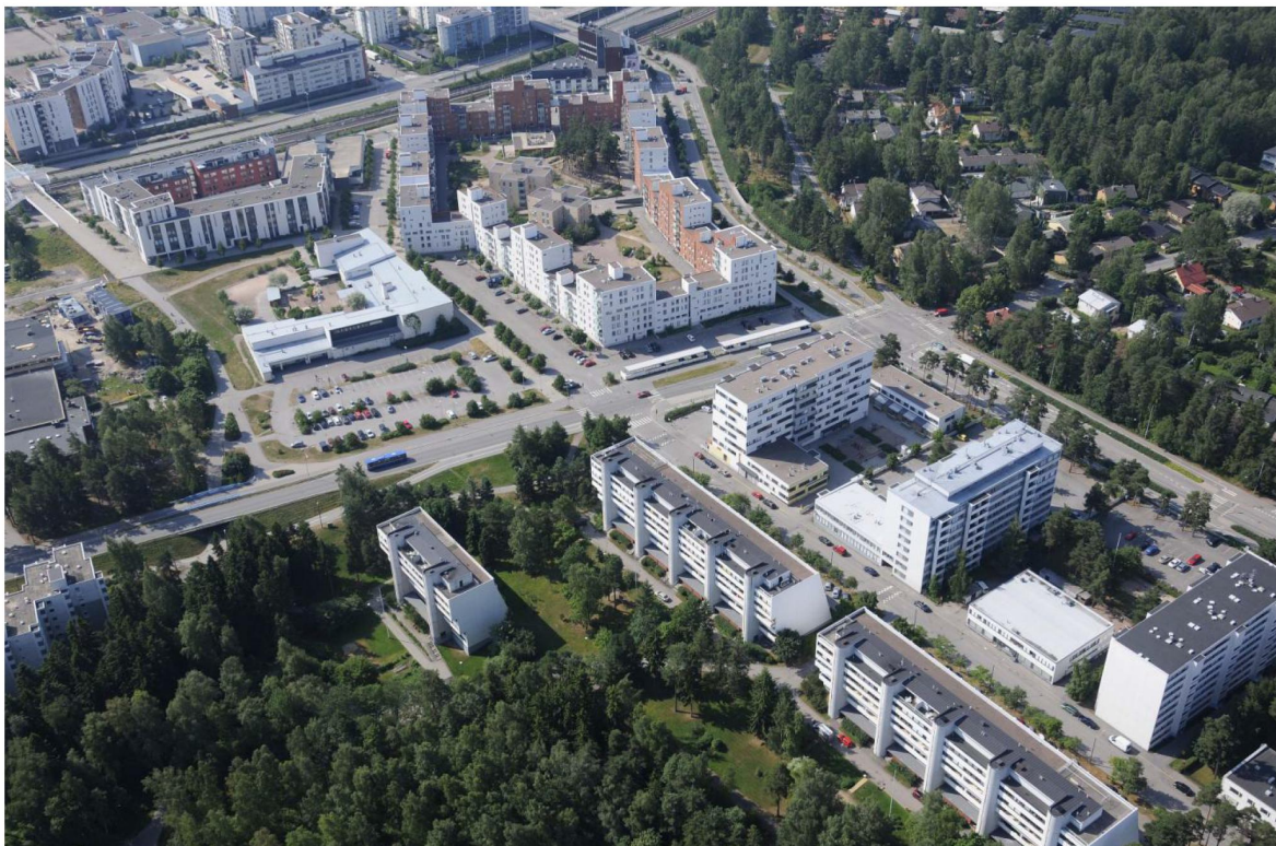
Ilmakuva 257 m korkeudesta koillisesta 22.7.2010 klo 8.05. Vuosaarentie 3 kuvassa keskellä, Edenin Pysäköinti Oy:n pysäköintitalo yläreunassa vasemmalla ja sen takana metrorata sekä Vuotie. Alareunassa Punakivenpuisto.
