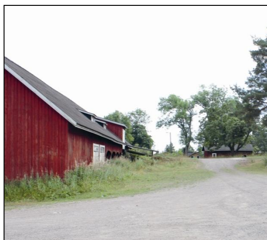
Vaunuvaja takaa. Näkymä Oy 2011.
