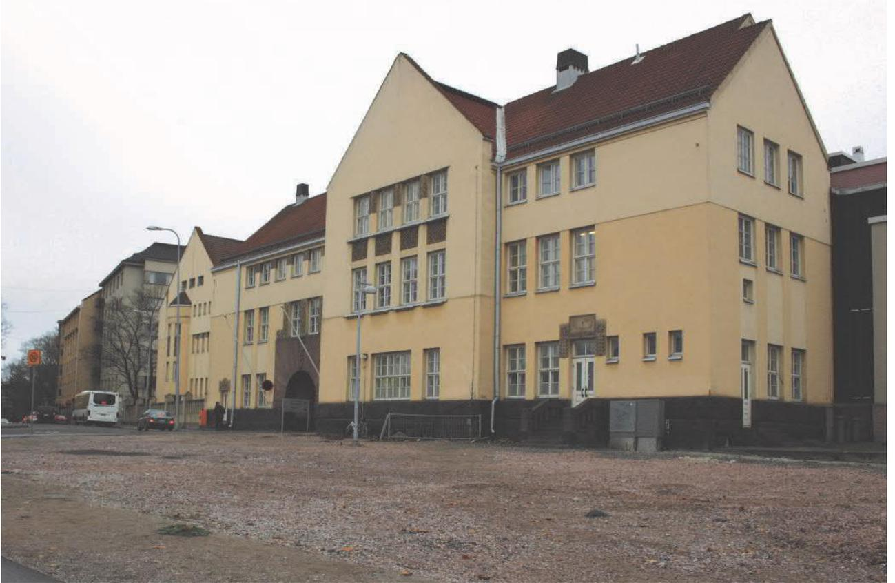
Hallintorakennus kuvattuna Lapinlahdenkadulta 17.11.2011. Raitisilmaventtiilit on muurattu umpeen. Vesikatolla on pyritty mukailemaan alkuperäisten piippujen ilmettä. Kuva MS
