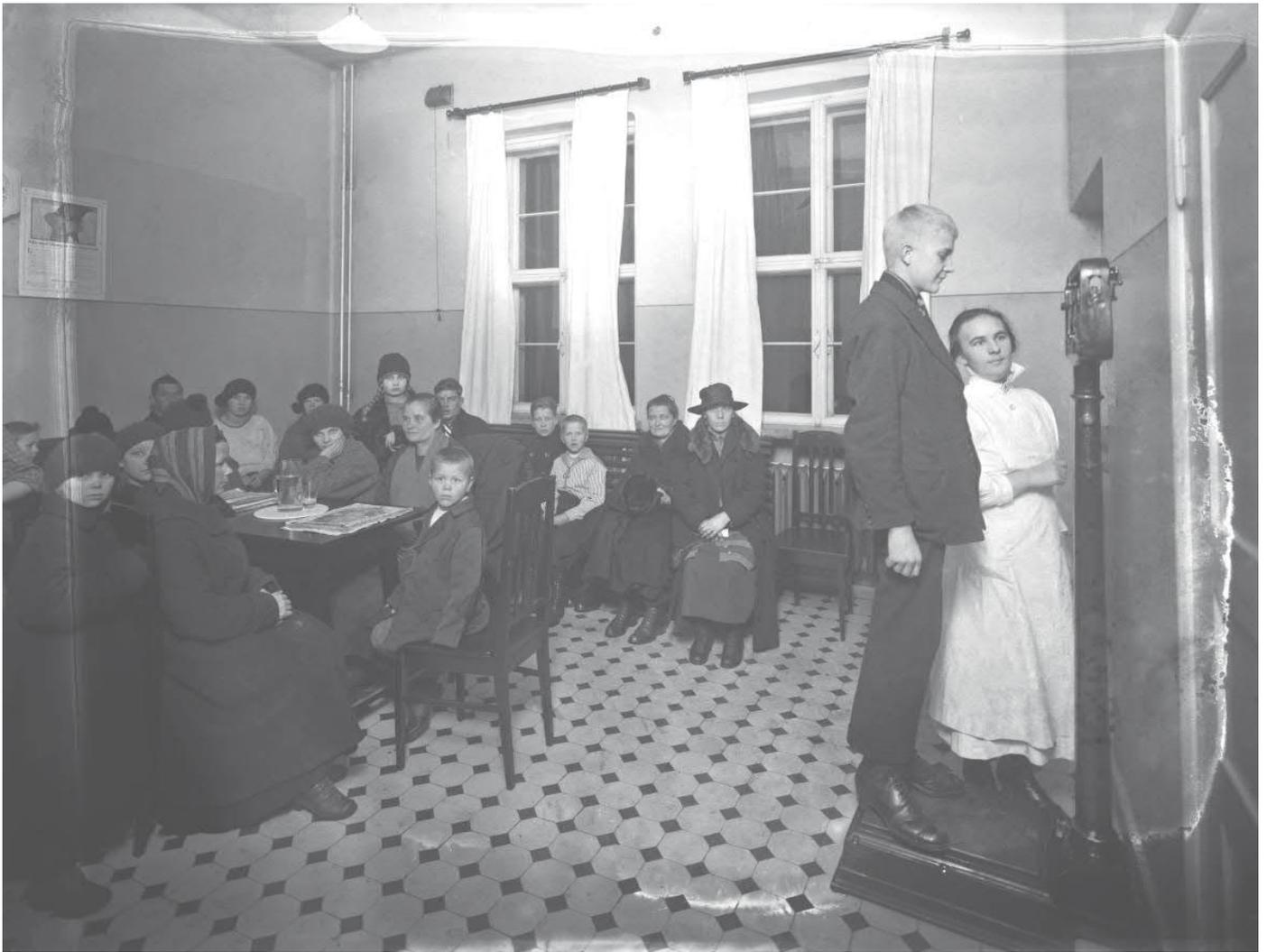
Hallintorakennuksen 1. kerroksessa sijaitseva poliklinikan odotushuone. Huoneen muodosta ja ovien sijainnista päätellen tässä kohdassa on alun perin sijainnut keuhkotautipoliklinikka. Lattiapäällysteenä on Metlacher-laatta. Seinien alaosat on maalattu öljymaalilla ja tummalla reunalla. Ikkunan alla radiaattori, ikkunan vieressä raitisilmaventtiili. Eric Sundström 1923. HKM
