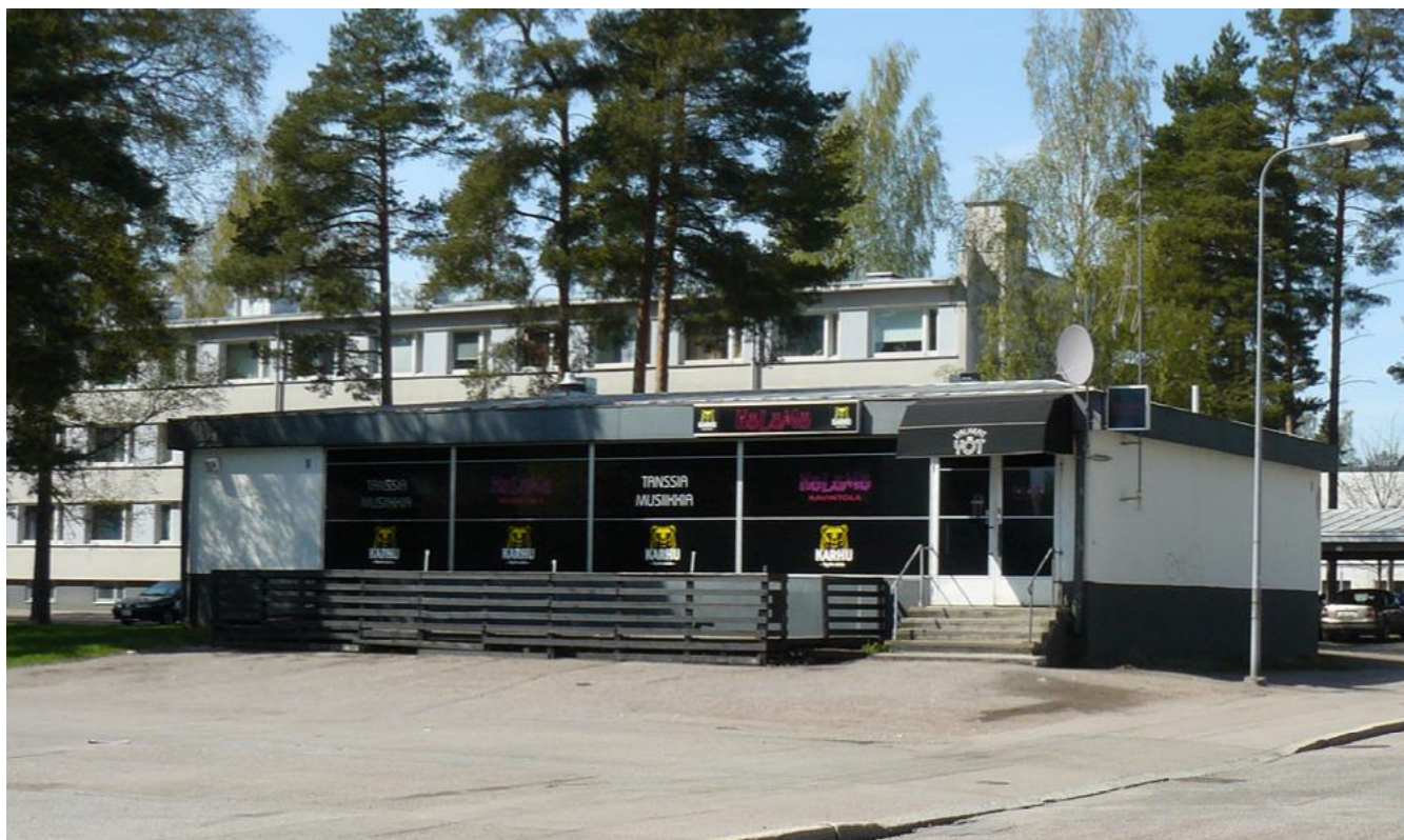
Purettavakasi suunniteltu liikerakennus, joka on tyhjiillään
