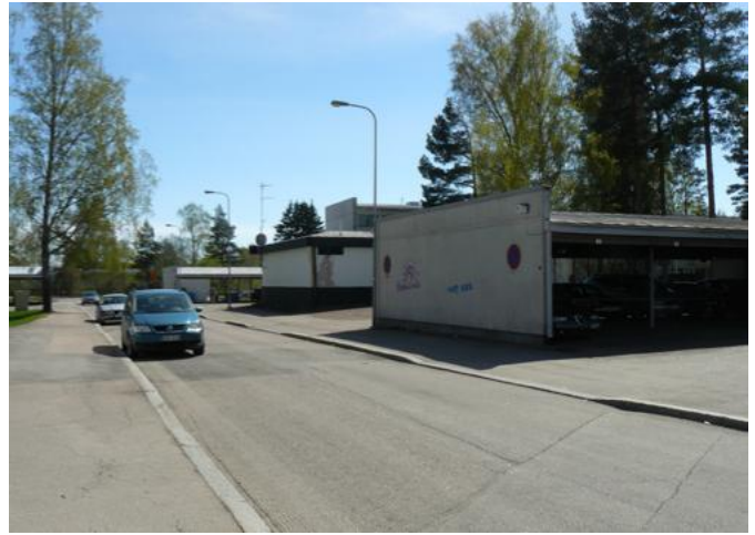
Olemassa olevat autokatokset, välissä purettava liikerakennus
