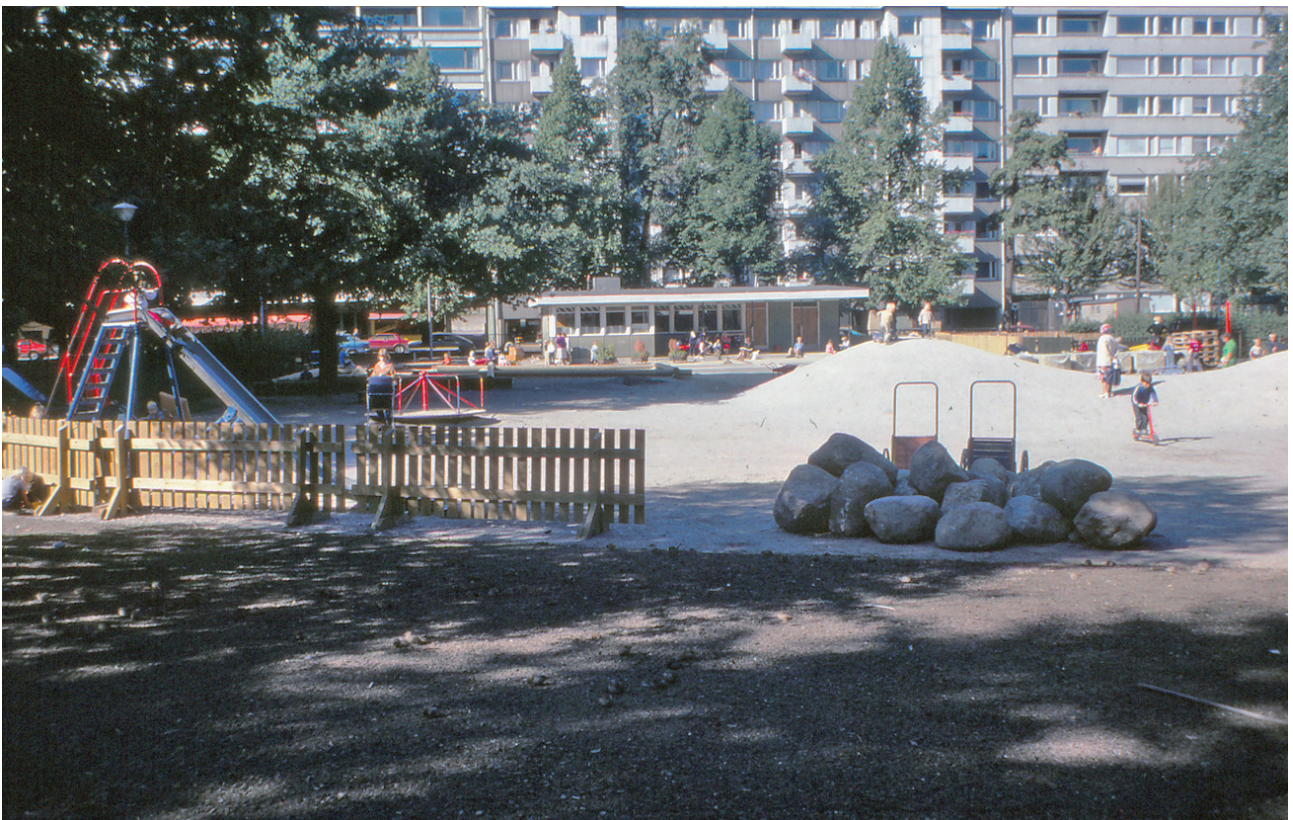
Kuva 46 | Liljeforsin suunnitteleman kunnostuksen rakennustyöt käynnissä kesällä 1980. KPOA.
