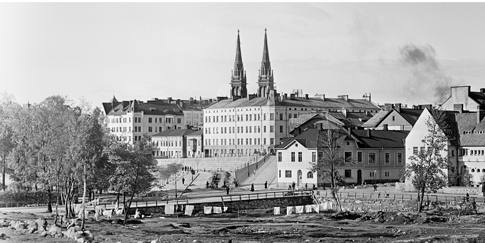
Kuva 10 | Näkymä Eiranpuiston kohdalta Laivurinkadulle vuonna 1908. Raitiotiekiskoja ollaan rakentamassa Laivurinkadulle
