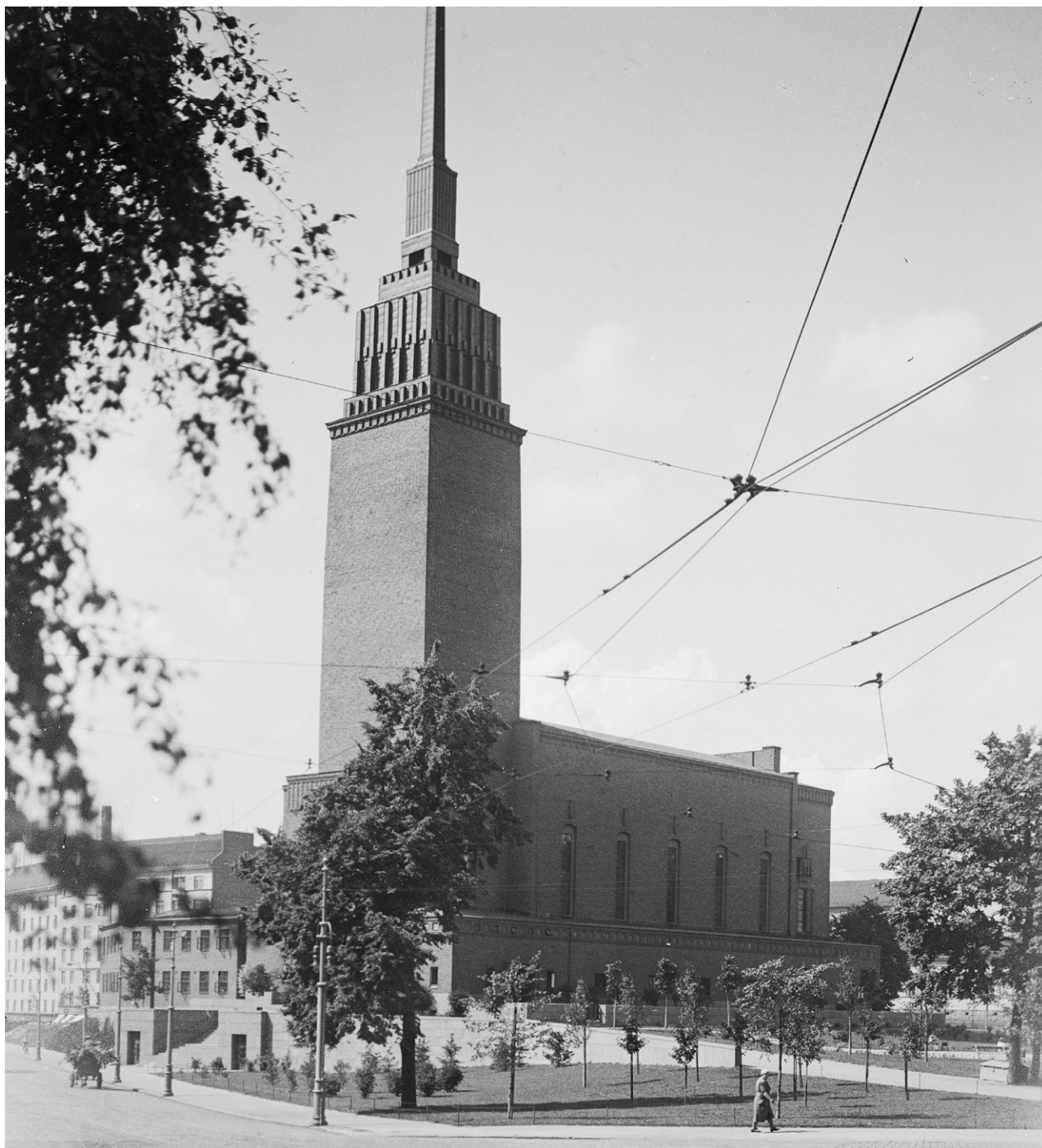
Kuva 32 | Näkymä Tehtaankadun ja Laivurinkadun kulmalta Agricolan kirkolle. Kuva on todennäköisesti 1940-luvun alusta, sillä
