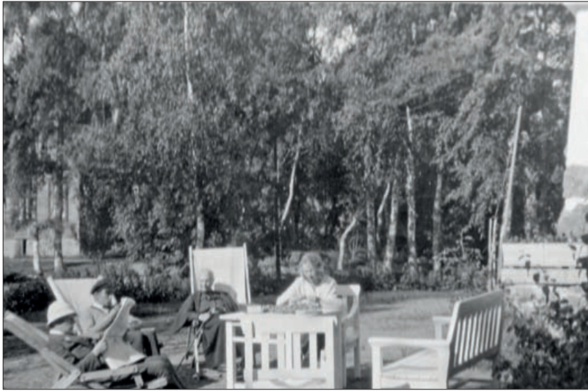
Kuva 24 | Näkymä huvilan lounaiskulmalta länsitasanteelle. Vasemmalla häämöttää huvilavahdin asunto. Yksityiskokoelma
