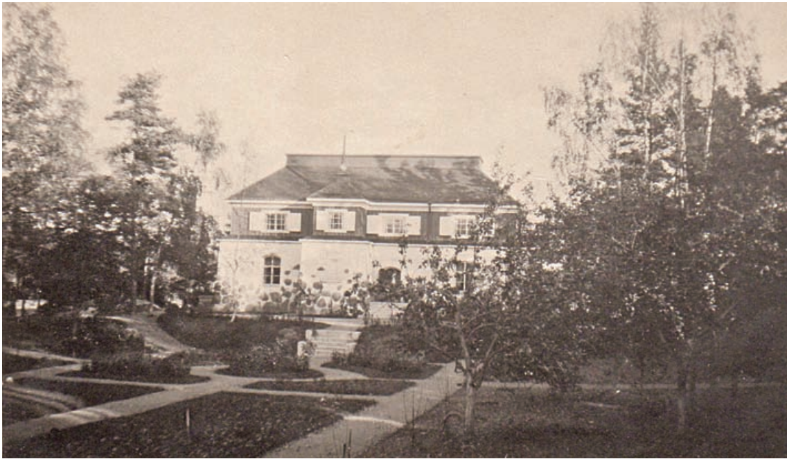
Kuva 81 | Näkymä muotopuutarhan eteläreunalta kohti huvilaa. Yksityiskokoelma
