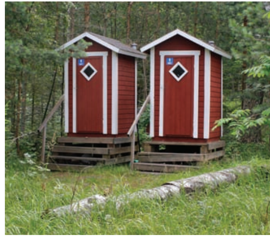
Kuva 70 | Länsirannan tuntumassa olevat käymälät. Kuva ER 2011.
