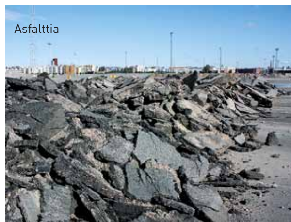
Kuva 3. Esimerkki lajittelevasta kaivusta.
