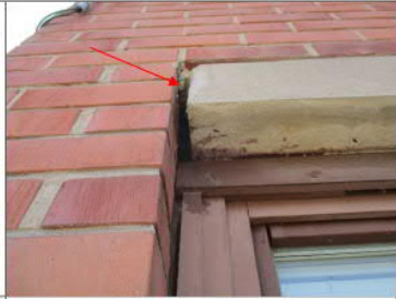
Kuva 5.4 Ikkunan ylityspalkin ja tiilimuurauksen liittymä ei ole tiivis
