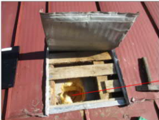
Kuva 6.9 Höyrynsulun alapuolisessa harvalaudoituksessa mikrobikasvustoa, RA.06-YP liikuntasalin kohdalla
