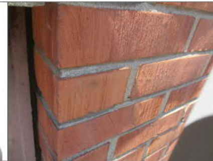
Kuva 5.8 Ikkunan ja tiilimuurauksen liittymä ei ole tiivis
