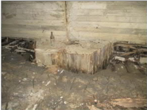
Kuva 8.5 Vanhoja muottilautoja
