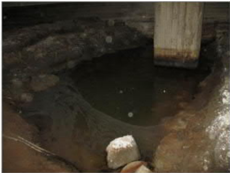
Kuva 8.3 Ryömintätalassa paikoin runsaasti vettä
