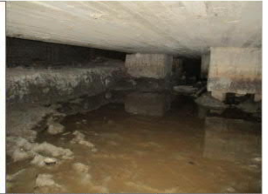
Kuva 8.2 Ryömintätalassa paikoin runsaasti vettä
