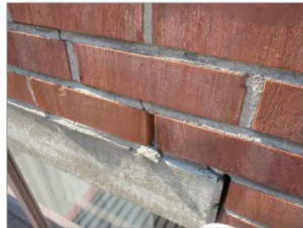
Kuva 5.9 Tiilimuurauksessa halkeilua ja lohkeilua
