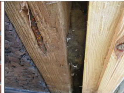
Kuva 5.10 Ikkunatilkkeessä havaittiin ilmavuotojen aiheuttamaa tummentumaa
