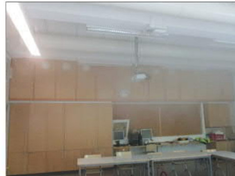
Kuva 9.11 Luokassa 151 tehdyssä savukokeessa tuloilman havaittiin sekoittuvan hyvin huonetilaan.
