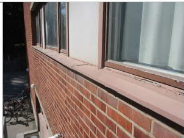
Kuva 5.6 Ikkunapellityksen kallistus puutteellinen
