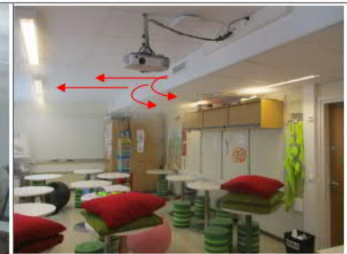
Kuva 9.12 Ilman liike työhuoneessa 221 jossa osa tuloilmasta siirtyi heti poistoventtiileille (kts. havainne nuolet).
