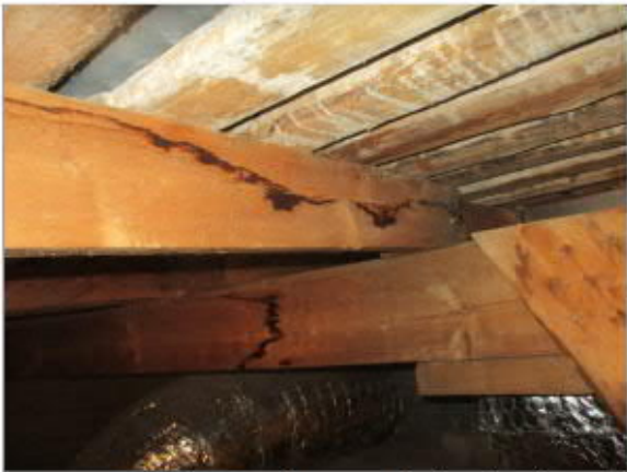
Kuva 6.7 Ullakon vesikatteen aluslaudoituksessa kosteusjälkiä
