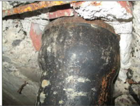
Kuva 8.6 Putkiläpivienti tiivistämättä
