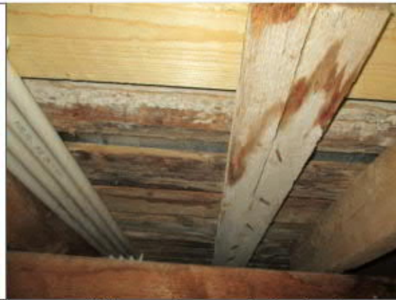
Kuva 6.8 Ullakon vesikatteen aluslaudoituksessa kosteusjälkiä
