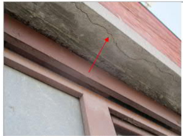
Kuva 5.5 Ikkunan ylityspalkissa halkeama
