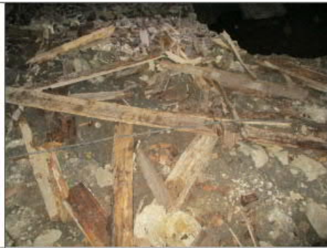
Kuva 8.4 Vanhoja muottilautoja
