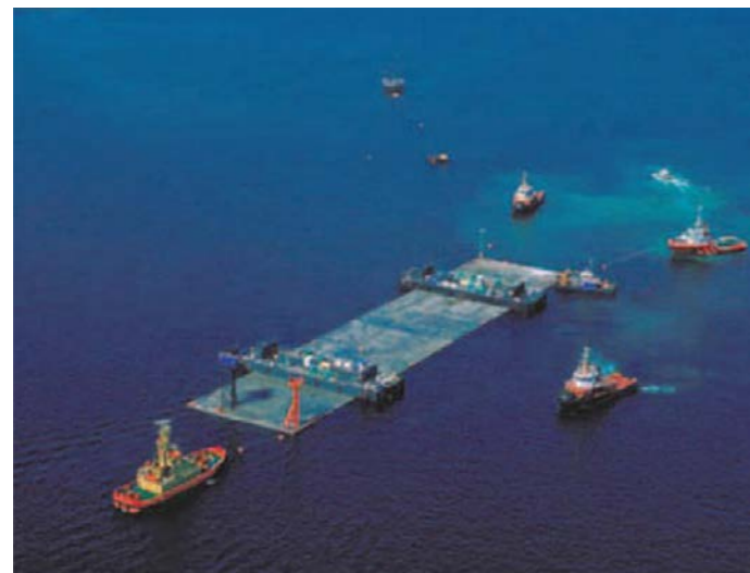
Kuva 8.9. Betonitunnelielementin uitto rakennuspaikalle. (Lähde: VTT 2005).
