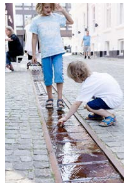
Näkyvä hulevesien johtaminen.
