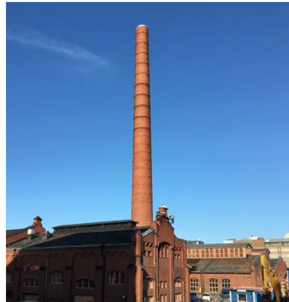
Konepajan alueen punatiiliset rakennukset savupiippuineen ovat keskeinen osa alueen historiaa ja kaupunkikuvaa.
