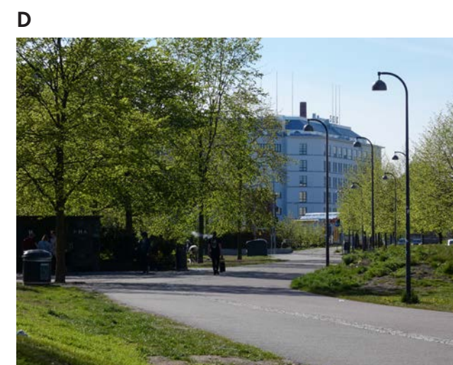
D SOK:n tuotantolaitos hahmottuu puiden lomasta pääjalankulku- ja pyöräreitin päätteessä
