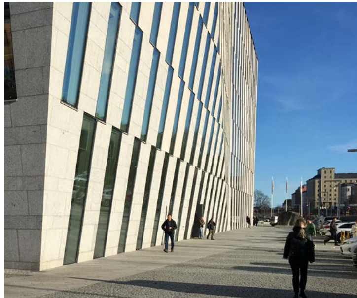
OP:n pääkonttorin veistoksellinen julkisivu luo tunnistettavan maamerkin Teollisuuskadun varteen.
