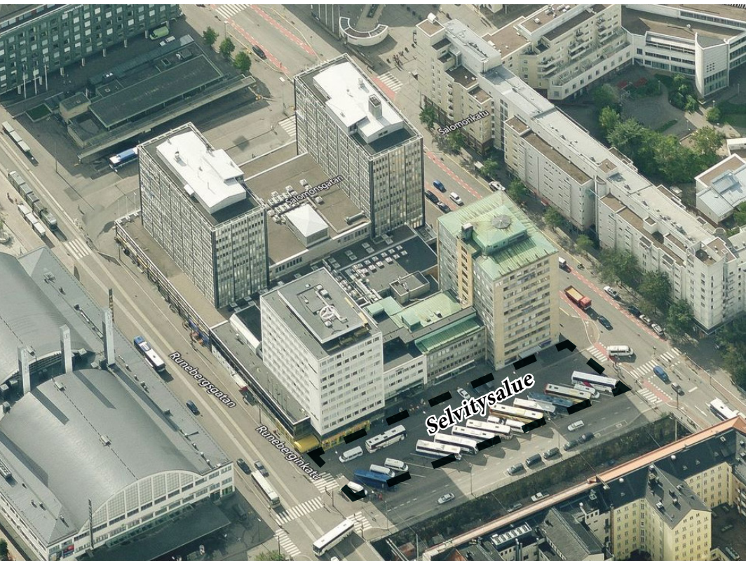
Ilmakuva korttelista 217, joka liittyy selvitysalueeseen. Valokuvassa näkyy korttelin rakennusmassojen (Autotalon, Kampin tornin ja Pohjantalon) eri korkeustasot ja kattomaailma. Selvitysalue on katutasossa korttelin pohjoispuolella. Alemmalla tasolla sijaitsee kevyenliikenteen taso Baana.
