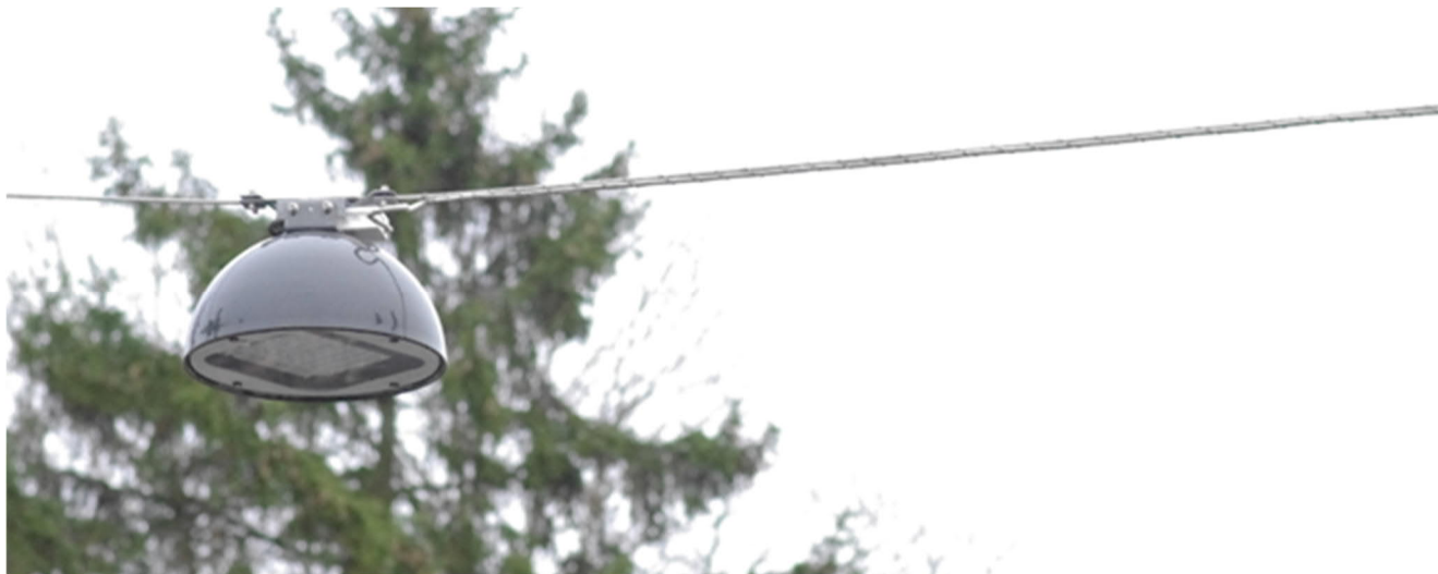
Kuva 8. Esimerkkikuva valaisinjohton surrauksesta ripustusvaijeriin.
