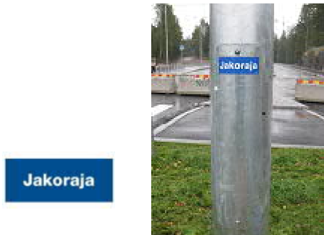
Kuva 10. Esimerkki jakorajatarran kiinnityksestä valaisinpylvääseen. Tarran leveys on 100 mm ja korkeus 40 mm.
