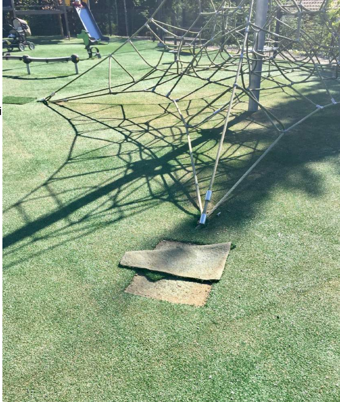
Hiekkatekonurmi korjataan liimaamalla vaurio kohtaan uusi maton pala. Kuva: Juha Kivimäki, Ramboll
