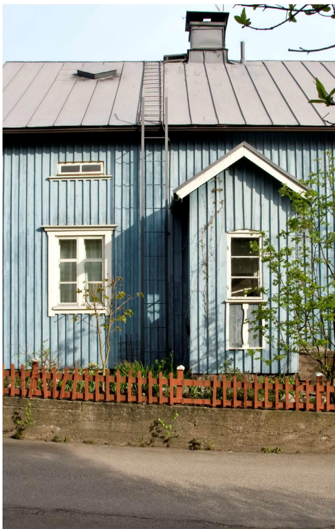
Varatien tikkaat tulee huoltaa ja korjata säännöllisesti.
