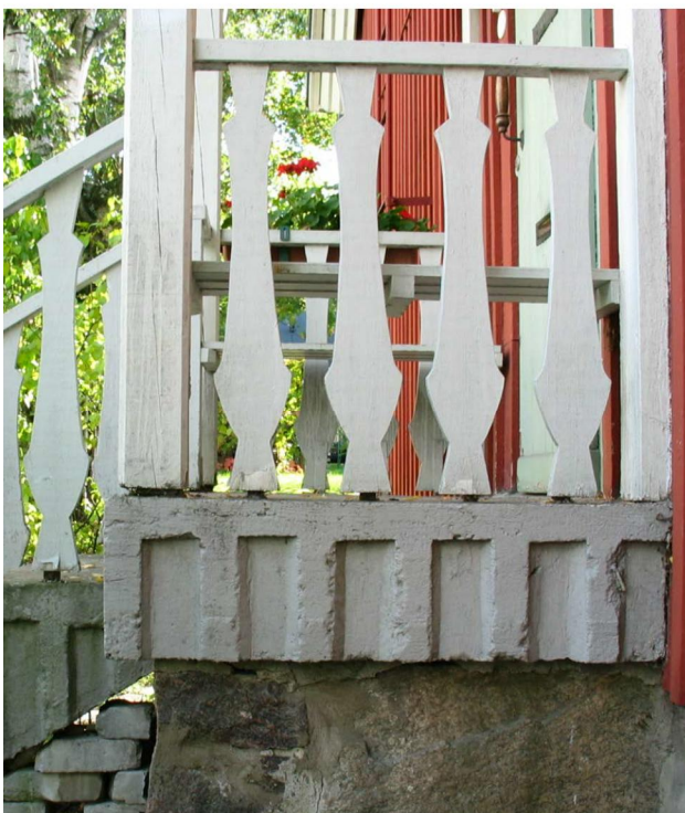
Ulkoportaan muotoiltu betoniosa sekä kaiteen muotoillut balutterit.
