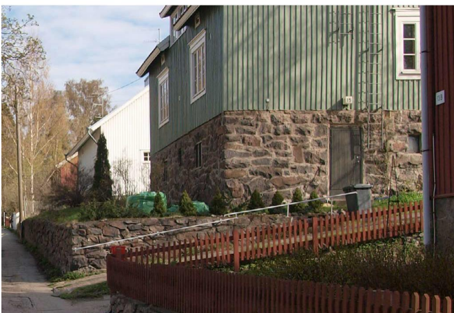
Korkea luonnonkivisokkeli on poikkeuksellisen näyttävä julkisivun osa. Sama materiaali jatkuu puutarhan tukimuurissa. Ilmattarentie 15.
