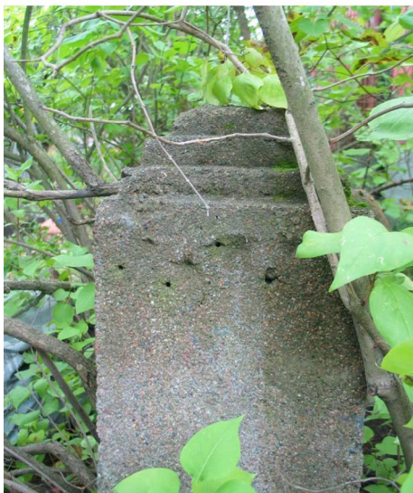
Betonisen porttipilarin pää on muotoiltu porraspyramidiksi.
