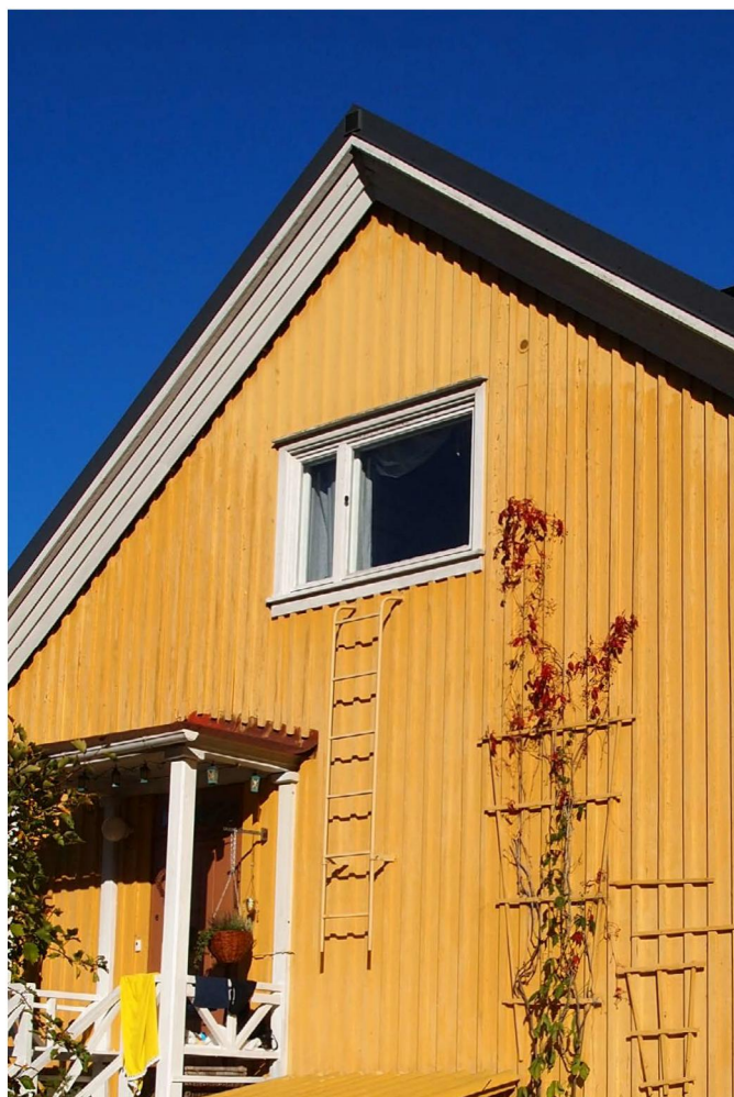
Varatien tikkaat tulee huoltaa ja korjata säännöllisesti.
