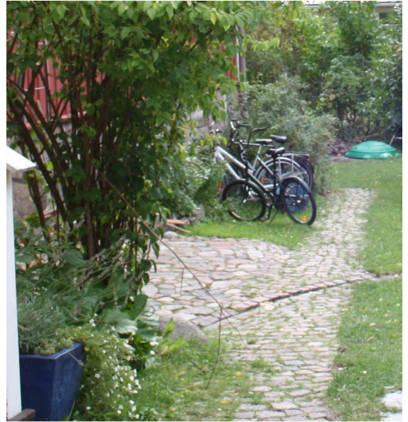
Kivetty vesikouru on luonteva ratkaisu sadeveden johtamiseen.
