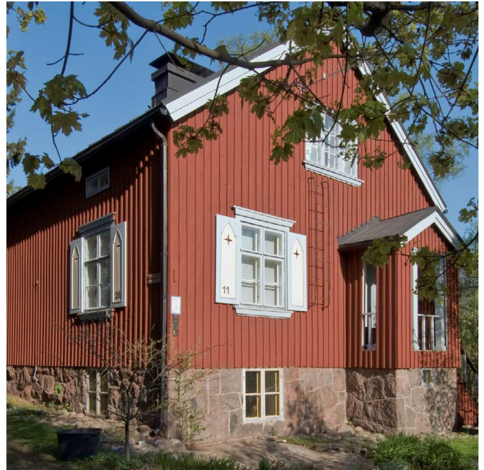
Länsi-Käpylän kivisokkelit on usein tehty paikalla kiilaamalla louhituista kivistä. Kuvassa huolella työstetty, suurista harkkomaisista kivistä ladottu sokkeli. Marjantatie 28.
