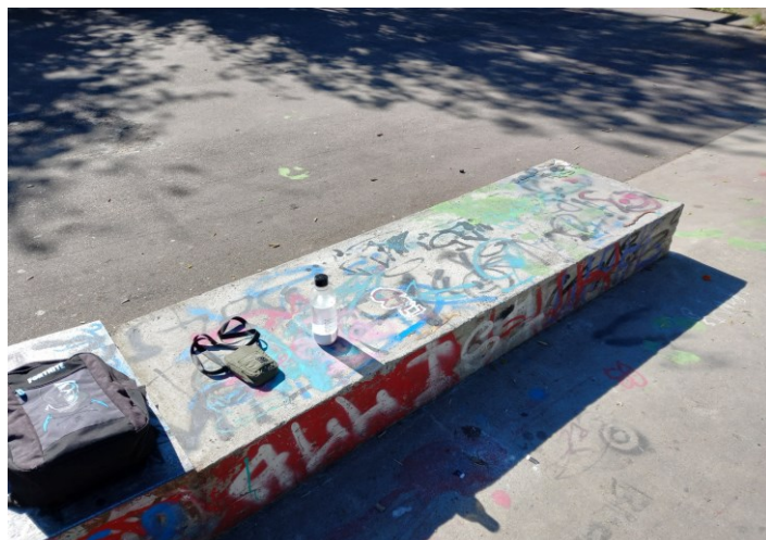
Kuva 11. Skeittivälineestä on irronnut kokonainen kivi-levy.
