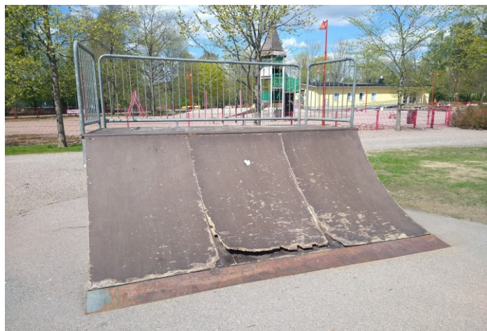
Kuva 12. Rakennusmateriaalina vaneri kestää huonosti suomen sääolosuhteita.
