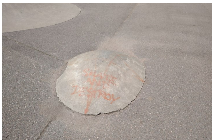
Kuva 13. Esimerkki betonin ja asfaltin pykältämisestä. Osa skeittipaikkojen pykällyksistä vaativat korjausta turvallisuuden näkökulmasta.
