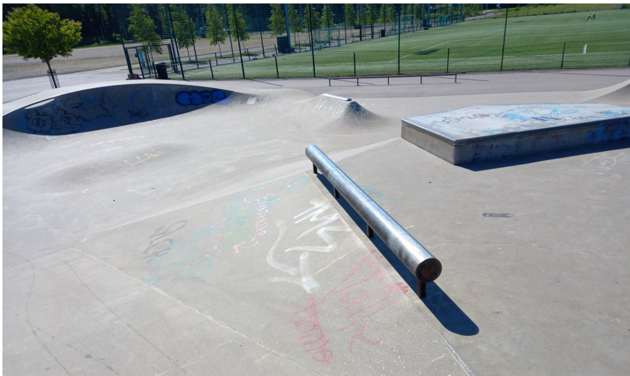
Kuva 6. Skeittipaikkojen betonielementteihin yhdistetään usein skeitattavuusominaisuuksien vuoksimetallia ja luonnonkiveä.
