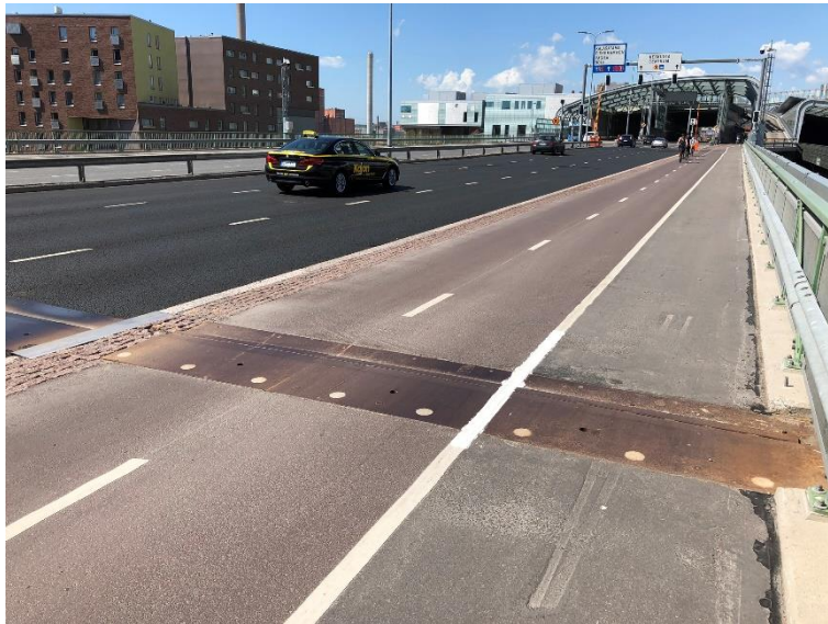
Kuva 17 Erittäin heikko liikuntasauma Itäväylällä
