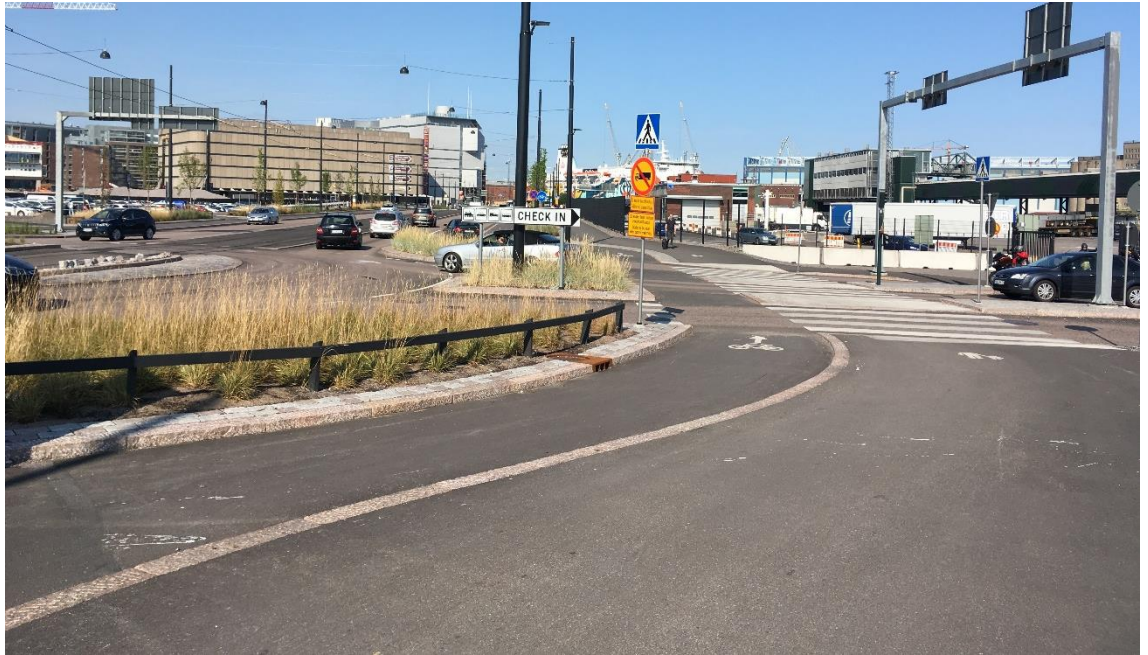
Kuva 33 Länsisatamankadulla on erittäin onnistunut rakenteellinen järjestely liikenneympyrässä. Pyörätien pituuskaltevuus on 2,9 % ja sivusuunnan ajoradan 1,5 %. Näiden muodostama n. 177 asteen kulma ajoradan ja pyörätien saumakohdassa tuottaa laatutason. Pyörätien sivukaltevuus on 3,4 %
