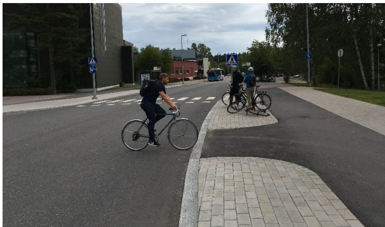
Kuva 41 Tasoon upotettu reunakivi hyvin asennettuna ei juuri tunnu pyöräilijälle. Reunakivi pidentää matkaa, jolla kaltevuuden suunnanmuutos tapahtuu. Reposalmentie.
