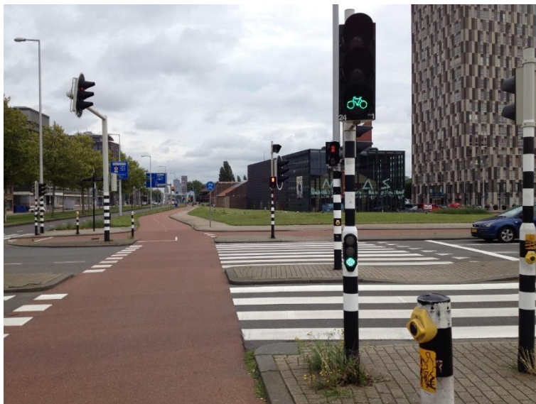
Kuva 32 Laadukas toteutus risteysalueella. Rotterdam, Hollanti.
