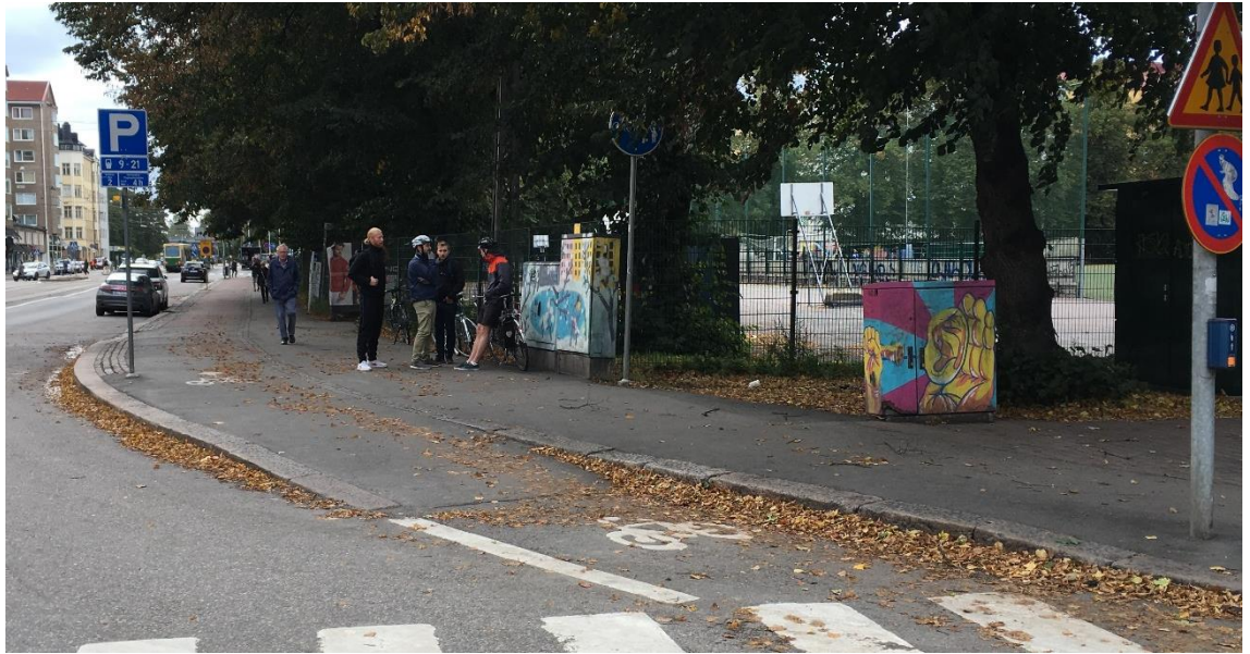
Kuva 28 Siirtymä Helsinginkadulla. Reunakivet on asennettu pyörätien suuntaisesti limit-täin.
