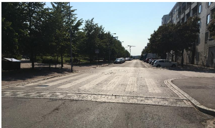
Kuva 46 Poikittaiset reunakivet aiheuttavat tärähdyksiä ylitettäessä
