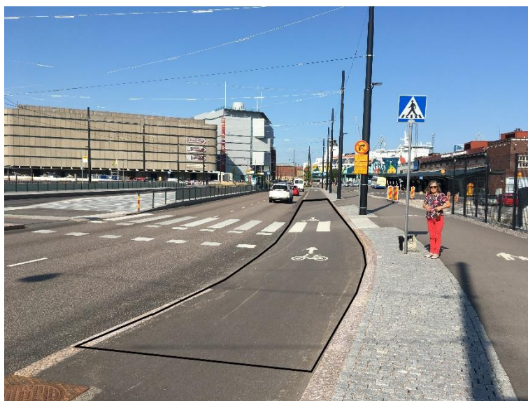
Kuva 21 Länsisatamankadulla sivukaltevuus lisääntyy, kun pyörätie ”lasketaan” pyöräkaistaksi. Pyöräkaistan sivukaltevuus suojatien kohdalla on 6,8 %.
