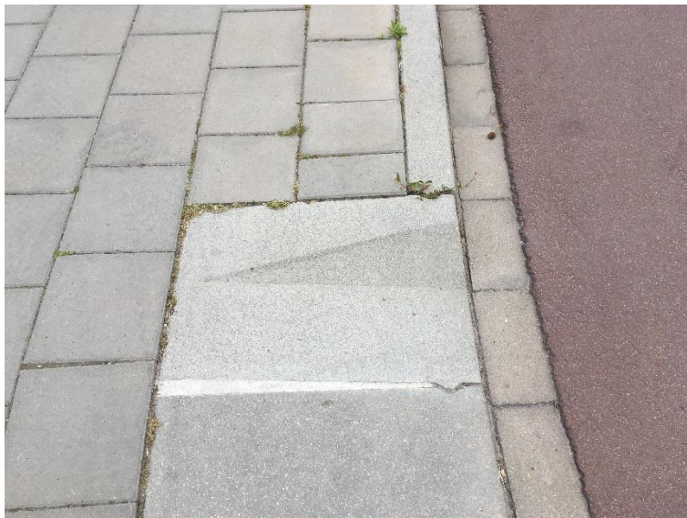
Kuva 45 Valmis elementtiluiska ja jiirissä laattakivi, Houten, Hollanti.
