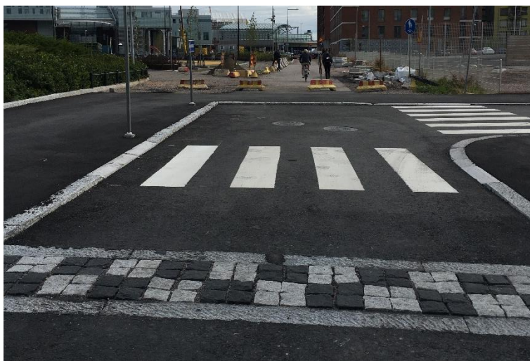
Kuva 47 Ruutukuviossa käytetty luonnonkivirivistö on hyvin epätasainen ja epämiellyttävä ajaa yli.
