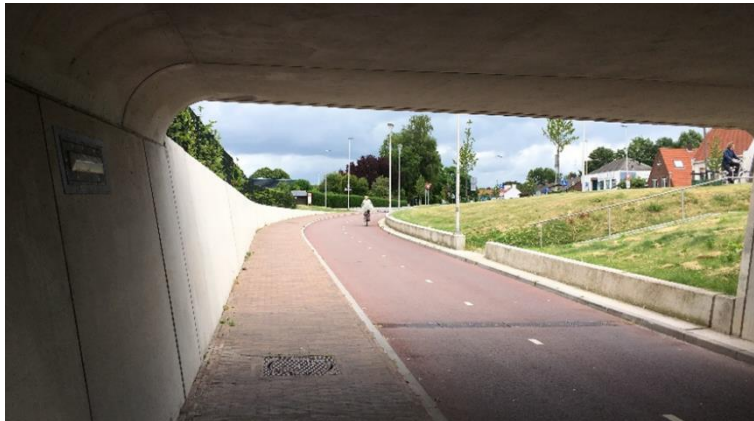
Kuva 16 Ritiläkaivo on hyvin asennettuna ajomiellyttävyyden kannalta usein toimiva vaihtoehto. Nijmegen, Hollanti.
