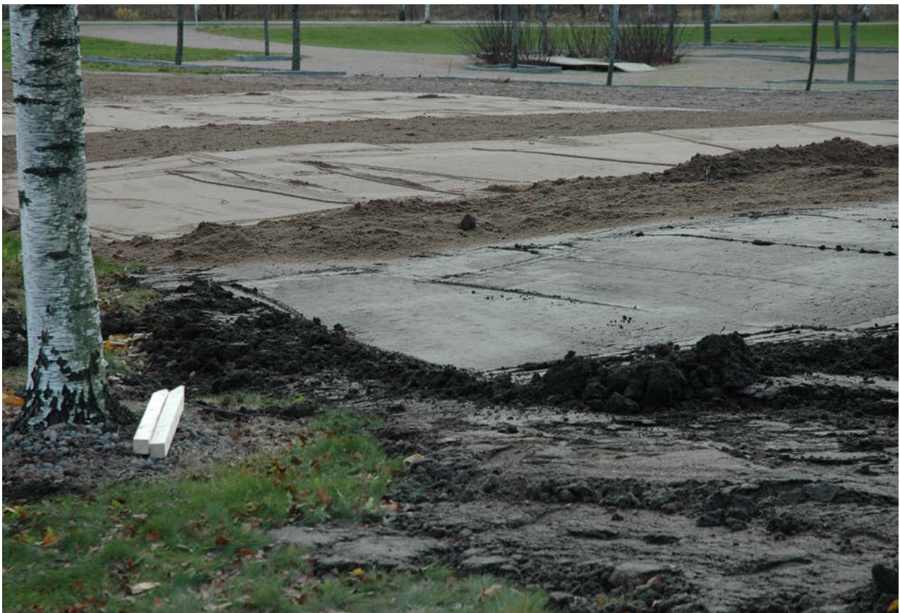
Kuva 7. Nurmikko voidaan muuttaa niityksi kierrätysmaiden avulla. Hiekkakerros pinnassa auttaa köyhdyttämisessä ja kuivatuksessa sekä toimii hyvänä kylvöalustana. Kuva Maaherranpuiston uusniityn rakentamisesta.
