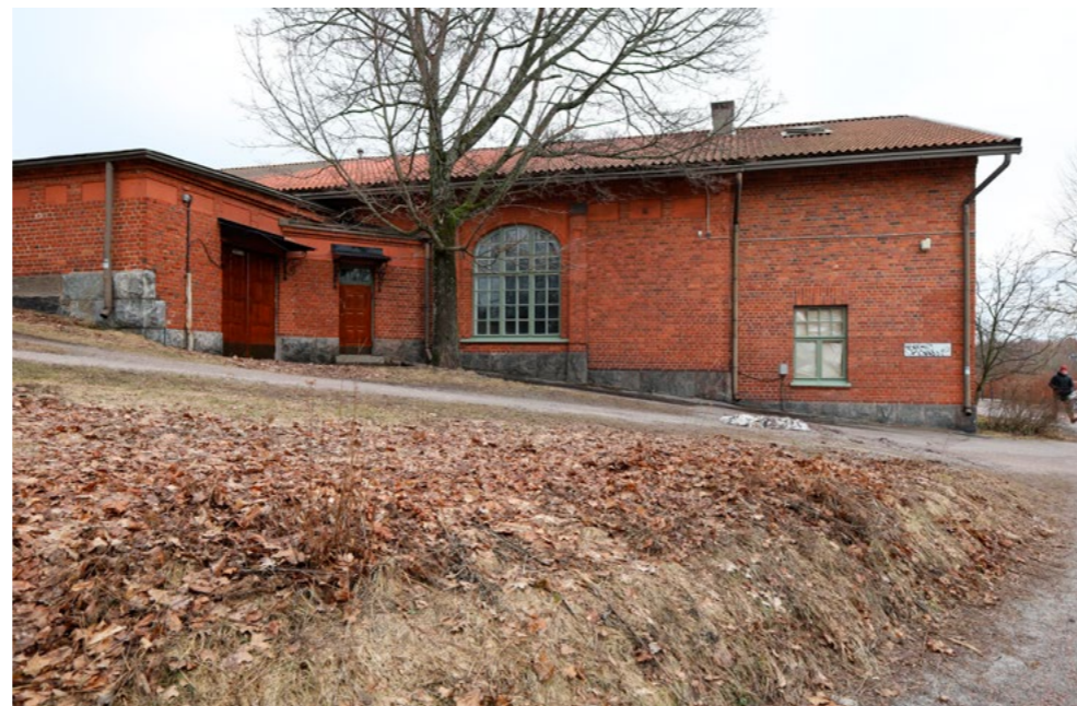
Entinen pikasuodatinrakennus vuodelta 1909 (5), laajennukset ovat 1950-luvulta, arkkiteetti H.J. Åberg.
