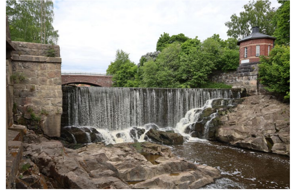
(4) Vesilaitoksen 1870-luvun alussa rakennettuun patokokonaisuuteen kuuluivat jo alun perin rannoille rakennetut tukimuurit. Oikealla näkyy kulmikkaalle harkkojalustalle 1910 rakennettu vedenottamorakennus, jonka kohdalla oli aiemmin puinen siivilärakennus.
