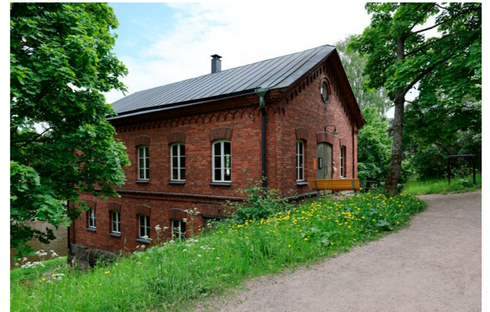
Myllyn punatiilinen uudisrakennus (3) valmistui kosken länsirannalle 1884. Se ehti toimia vain 30 vuotta ennen sulkemistaan 1915. Mylly on kuulunut Helsingin kaupunginmuseon Voimalamuseoon vuodesta 2000.
