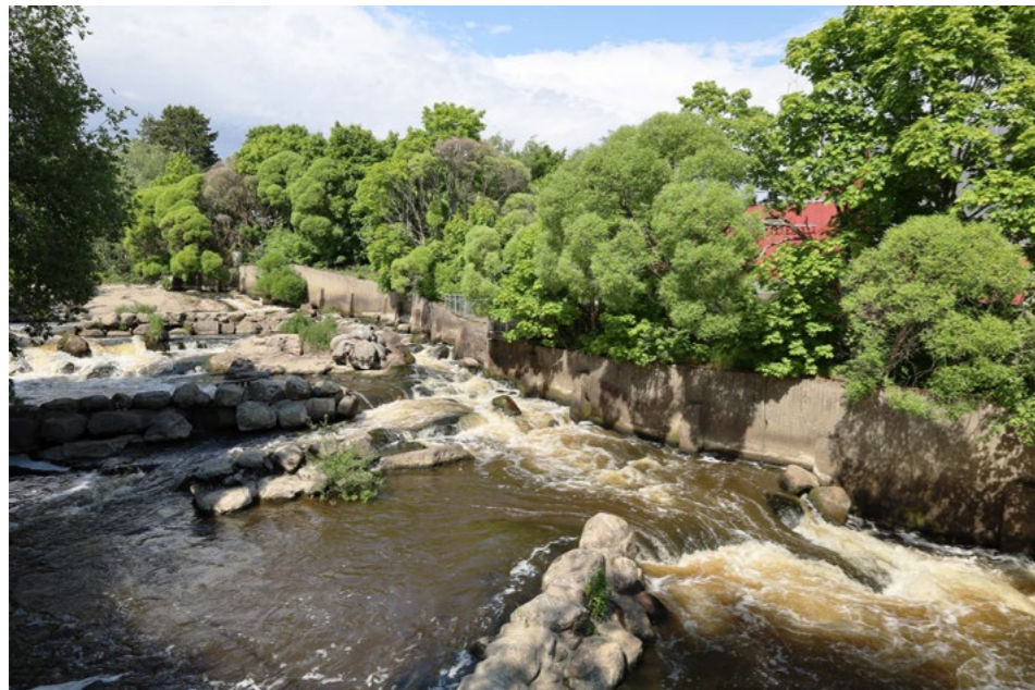
(20) Betonista valettu rantamuri on viimeistelty 1980-luvun lopulla rakennetun betonisen kalaportaan purkamisen jälkeen. Koskiuomaan on 1999 rakennettu uusi kalatie, joka koostuu betonilla vahvistetuista kivimuodostelmista.
