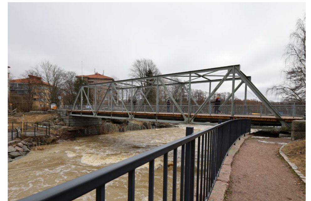
Virkistyspuiston reitistösuunnitelmaan kuului kevyen liikenteen silta-yhteys Vanhankaupunginkosken itäpuolelle Kuninkaankartanonsaaren eteläosasta. Vanha teräsristikkosilta (3) on hankittu Keski-Suomesta.
