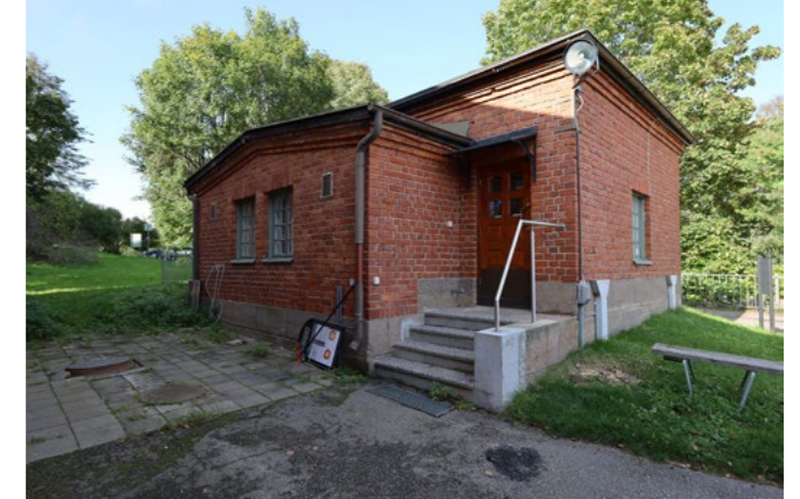
Entinen tasauskaivorakennus (8) vuodelta 1928 on myöhemmin toiminut toimistokäytössä.
