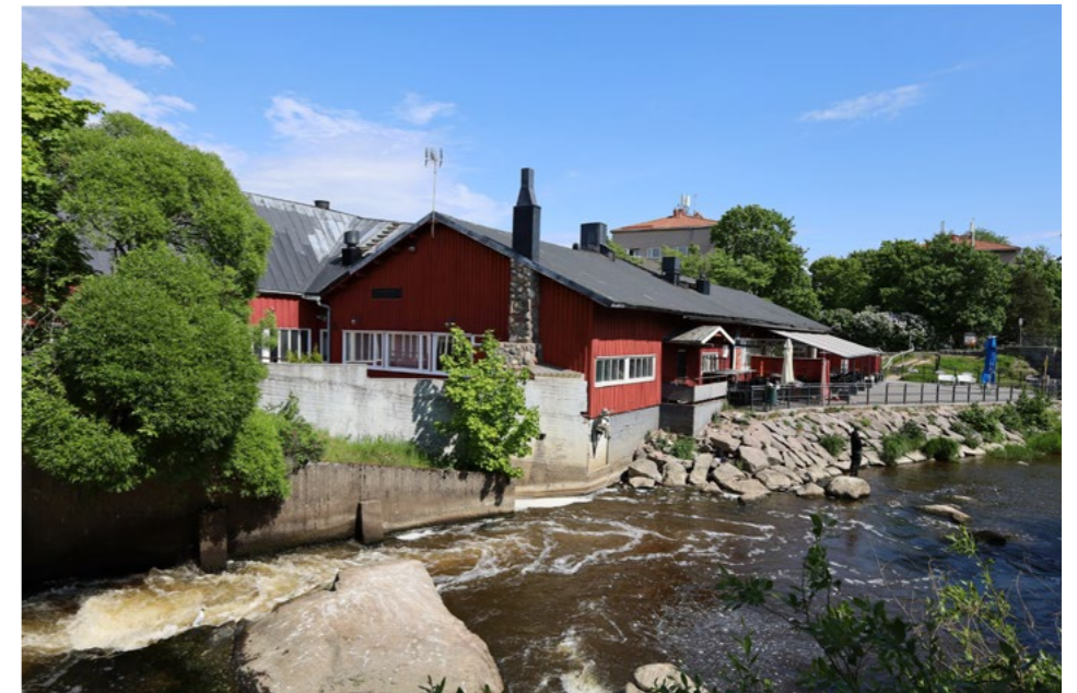
(21) Koskiuoman itärannan uudempia rakenteita edustavat betonimuri ja kivillä päällystetty rantaluiska.
