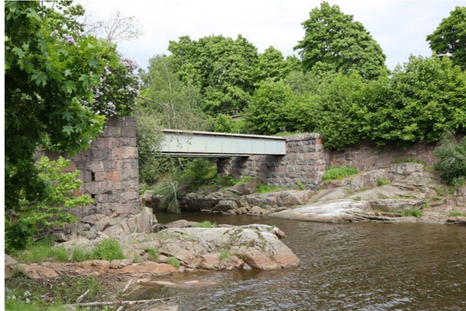
(6) Kosken ylittävä putkisilta tukeutuu rannoille rakennettuihin, epäsäännöllisistä harkoista muurattuihin kulmikkaisiin maatukiin.
