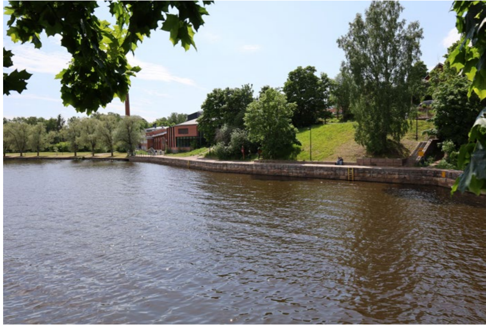
(8) 1990-luvun puistosuunnitelman mukaan rakennetut rantamuurit ovat selvästi tunnistettavissa säännönmukaisine harkkoverhouksineen. Oikealla näkyy Koskipuiston alue.
