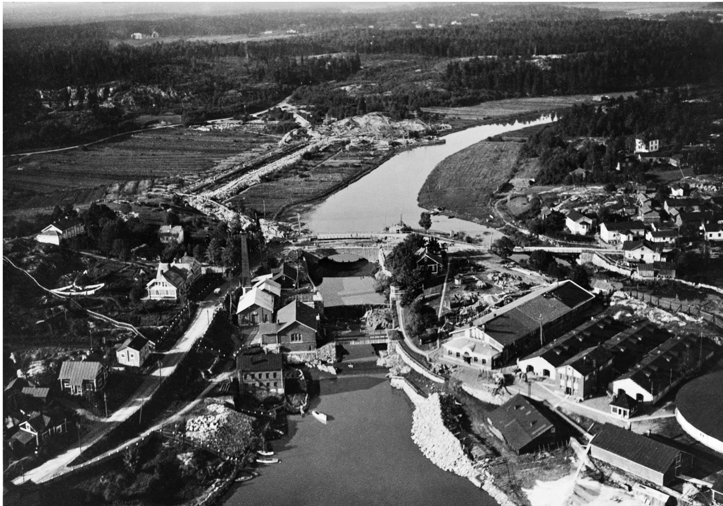
Vanhankaupunginkosken ympäristöä viistokuvassa 1926, Valokuvaaja Somersalo. HKM. Läntisen jokihaaran uusi silta valmistui 1926. Etualalla vasemmalla tiilirakennusten ryhmä; mylly vuodelta 1884, vanhempi turbiini- ja pumppulaitos vuodelta 1876 ja uudempi (1930 purettu) höyrypumppulaitos savupiippuineen vuodelta 1890. Oikealla Kuninkaankartanonsaaren katetut suodatinaltaat. Taustalla näkyy uusien saostusaltaiden työmaa.
