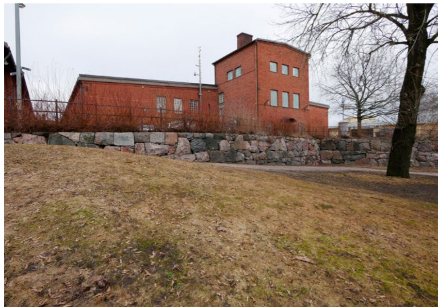
Ent. suodatinrakennus (6), jonka kolme allasta rakennettiin alun perin 1895. Rakennusta on muutettu ja laajennettu mm. 1940-luvulla.
