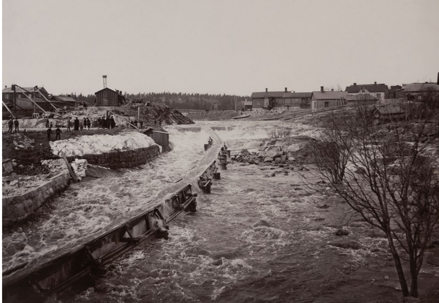
Itäiseen koskihaaraan rakennettiin vuonna 1890 tukkien uittoränni. Näkymä pohjoiseen, vasemmalla Kuninkaan-kartanonsaaren rantamuurit ja kallio. Kuva HKM
