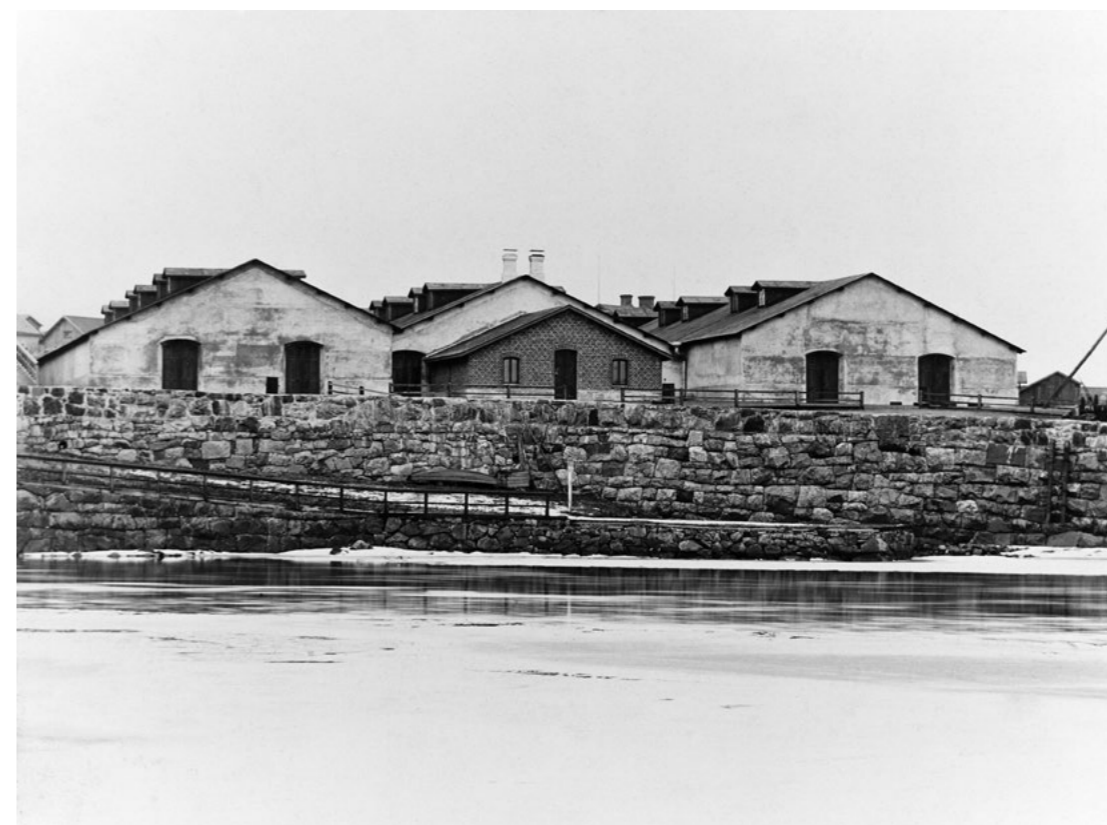
Vanhojen avoaltaiden luoteispuolelle rakennetut uudet rinnakkaiset, katetut suodatinallaat. Kuvausaika 1895, HKM.
