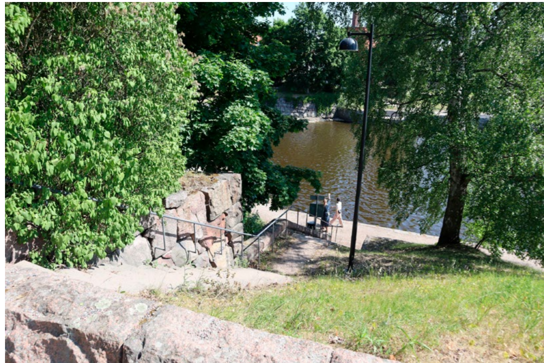
Puistoon rakennettiin 1990-luvun lopulla kiviportaait, jotka paransivat kulkuyhteyttä rantapenkereelle
