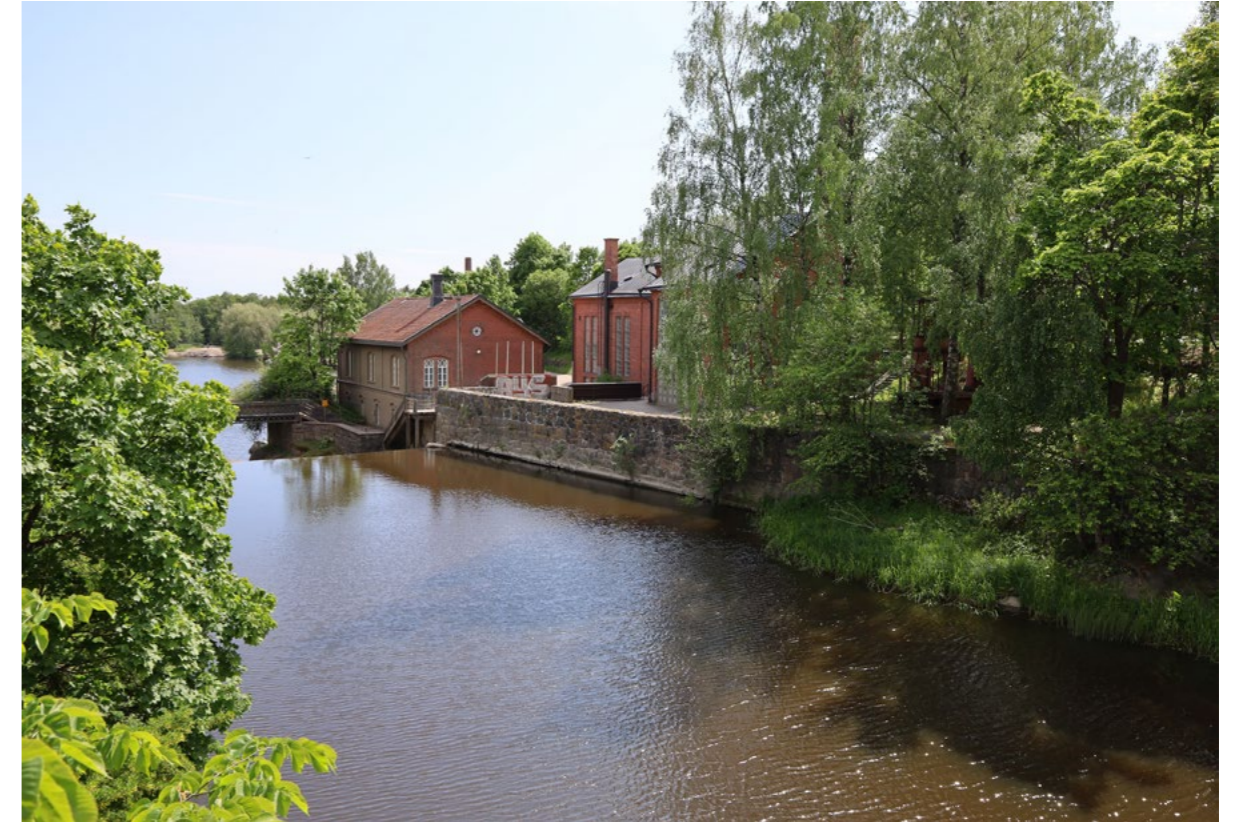
Koskipuiston pohjoisosan vanhoja rantamuureja, taustalla turbiinipumppulaitos ja höyryvoimalaitos.
