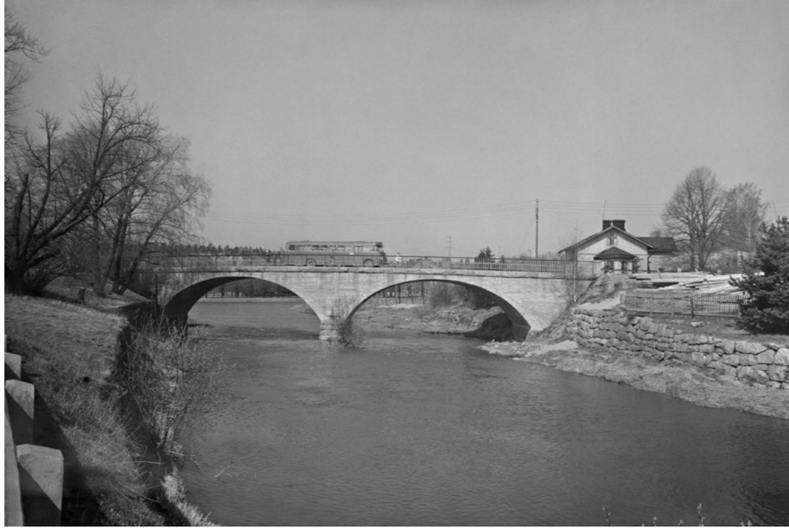
Itäisen koskihaaran uusi betoniholvisilta avattiin liikenteelle elokuussa 1933. Keskellä jokiuomaa holvit tukeutuvat graniittiharkoilla verhoettuun siltapilariin. Kuvassa näkyy itäisen rannan tukimuuri. Valokuva vuodelta 1959, Constantin Grünberg. HKM.
