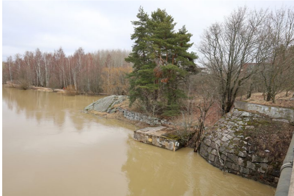
(1) Kuvassa näkyy Vanhankaupungin ja Kuninkaankartanonsaaren välisen, 1920-luvulla rakennetun sillan kivipäällysteinen, pyöristetty maatuki.
