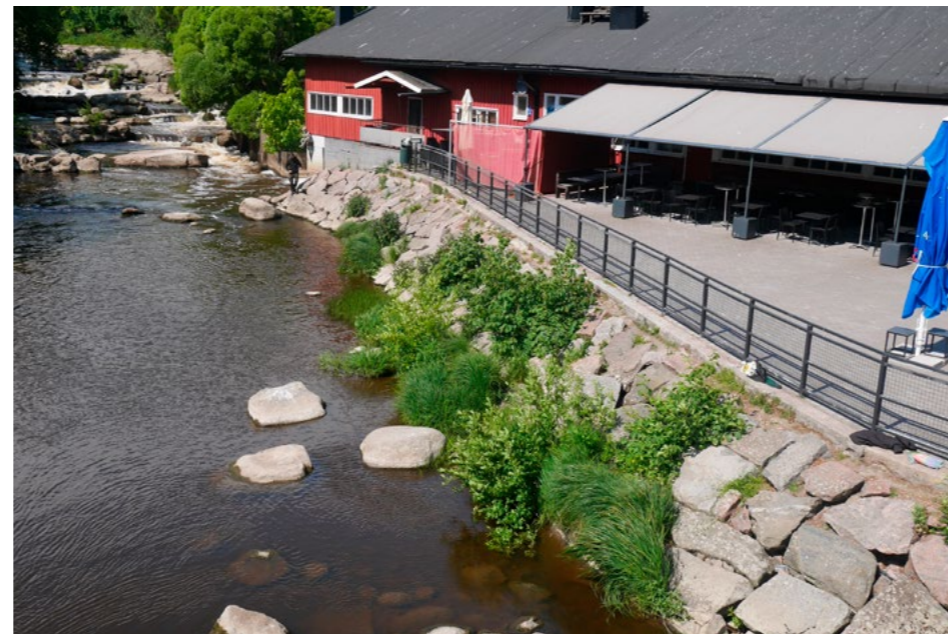
(21) Imatran voiman entisen laboratoriorakennuksen kiviluiskalla rajattu, pengerreretty pihatasonne sijaitsee osittain koskiuoman itärannan täytetyn suvantopoukaman päällä.
