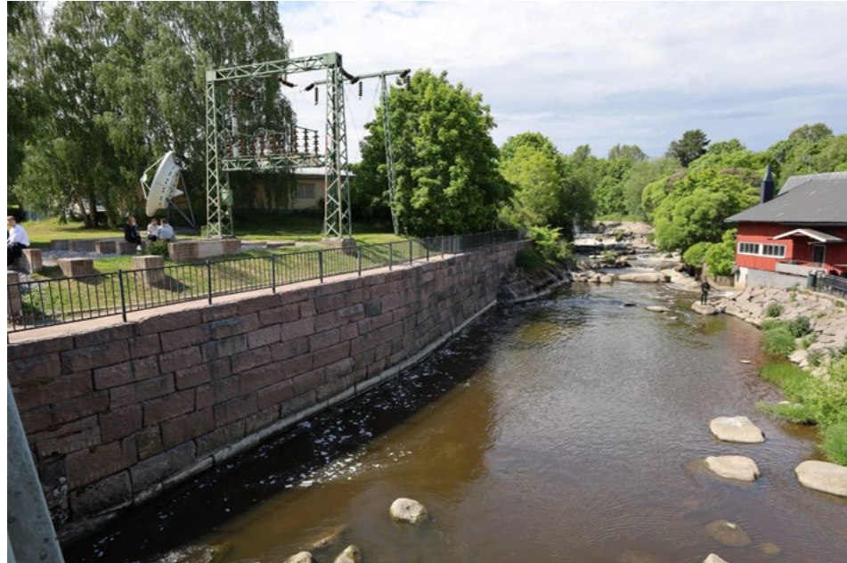
(17) Vuonna 1996 saaren eteläosaan kevyen liikenteen kulkuyhteydeksi siirretyn ristikkosillan pohjoispuolelle on samassa rakennusvaiheessa tehty uusi, säännönmukainen rantamuri, johon liittyy kävelyreitti ja teräskaide.
