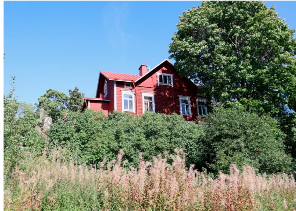
(20) Kellomäen etelärinteellä sijaitsee vuonna 1900 valmistunut Johannesbergin huvila. Taustalla vasemmalla pilkottaa mäen laella seisova muistomerkki. Rakennus on asemakaavassa suojeltu merkinnällä sr-2.
