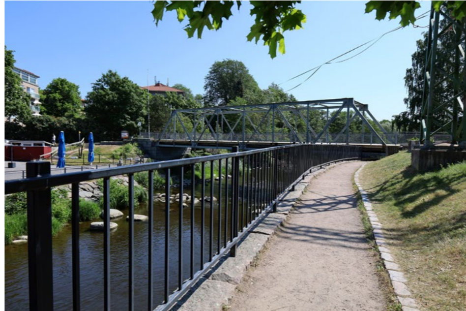
(17) Uuteen rantamuriin liittyy puistosuunnitelmaan kuulunut uusi kävelyreitti ja teräskaide.
