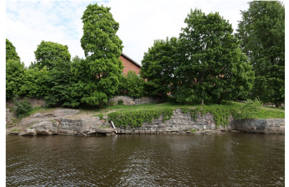
(7) Kuvassa näkyy kallioon tukeutuva kivilaituri ja sen jatkeena oleva kaareva rantamuuri. Taustalla pengerrytyn maaston tukimuuri, joka rakennettiin 1870-luvulla, samaan aikaan kuin ensimmäiset suodatinaltaat.
