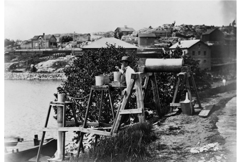
Vesilaitoksen vedensuodatuskokeiluja Kuninkaankartanonsaarella vuonna 1891. Taustalla näkyy Hämeentie ja Kellomäen paljas kallio puurakennuksineen. Kuvausaika 1891. HKM.
