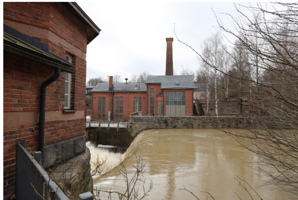
(12) Padon länsipäässä alkaa kosken länsirannan pitkä, suora, epäsäännöllisillä kiviharkoilla päällystetty rantamuri, joka ulottuu saaren pohjoispäässä sijaitsevaan siltaan saakka.
