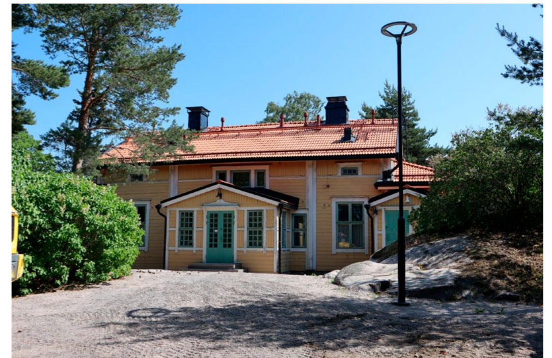
(21) Kellomäen pohjoisrinteellä sijaitseva puurakenteinen asuintalo on tiettävästi Forsbyn kartanon entinen päärakennus tai sen paikalle vuonna 1909-1914 rakennettu uusi asuinrakennus. Vuodesta 1909 rakennus toimi vesilaitoksen kemistin asuntona. Rakennus on Asemakaavassa merkinnällä sr-2 suojeltu rakennus toimii nykyään HSY:n edustustilana.
