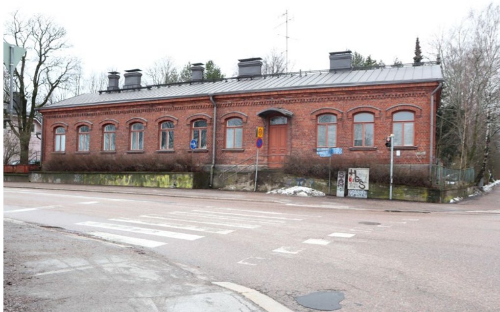
(14) Hämeentien ja Koskelantien kulmassa seisova punatiilinen asuinrakennus valmistui vuonna 1899 vesilaitoksen ylikonemestarin ja koneenhoitajan asuintaloksi. Edelleen asuinkäytössä oleva rakennus on asemakaavassa suojeltu merkinnällä sr-2.
