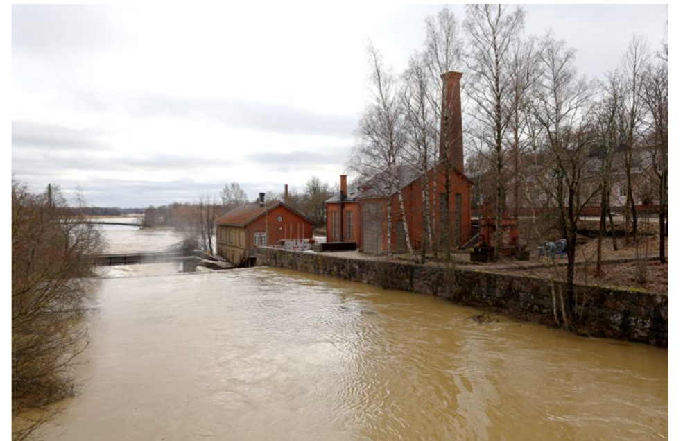
(12) Länsirannan tukimuri nousee suoraan vedestä.
