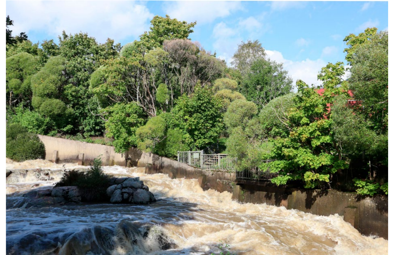
Puiston rantamuri on uusittu betonirakenteisena uuden kalatien rakentamisen yhteydessä 1990-luvulla.
