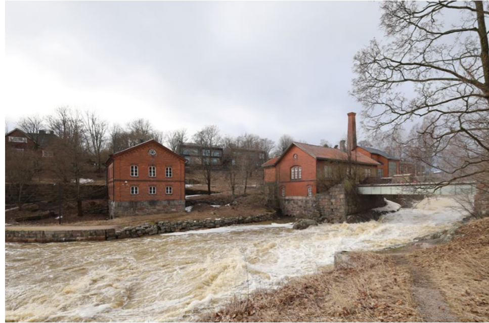
Kosken länsirannalle tunnusomainen näkymä: (3) myllyrakennus vuodelta 1884 ja (1) turbiinipumppulaitos vuodelta 1876.
