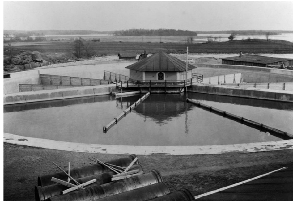
Vesilaitoksen avoimet puhdistusaltaat Vanhassakaupungissa. Kuva HKM.
