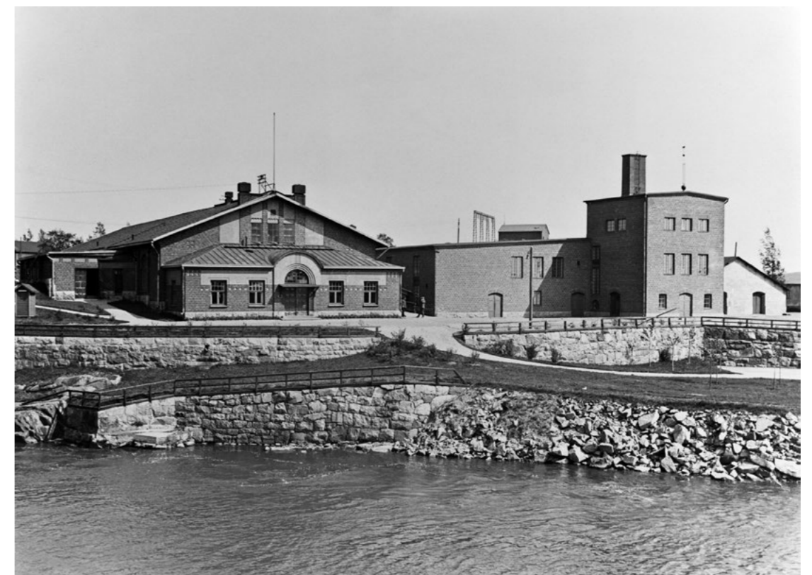
Vasemmalla 1909 valmistunut suodatinlaitos. Vanhemmat suodatinallasrakennukset saivat vaiheittain uuden, yhteisen loivan vesikatkon ja niiden eteen rakennettiin kolmi-kerroksinen torniosa 1928-1929. Kuva 1937, HKM.
