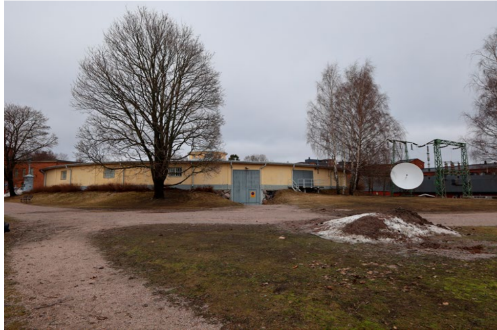
Vesilaitoksen vanhimman, 1876 valmistuneen hiekkasuodatinlaitoksen päälle rakennettiin ulkoseinät ja vesikatto 1900-luvulla. Rakennuksessa (7) on Tekniikan museon päänäyttely.
