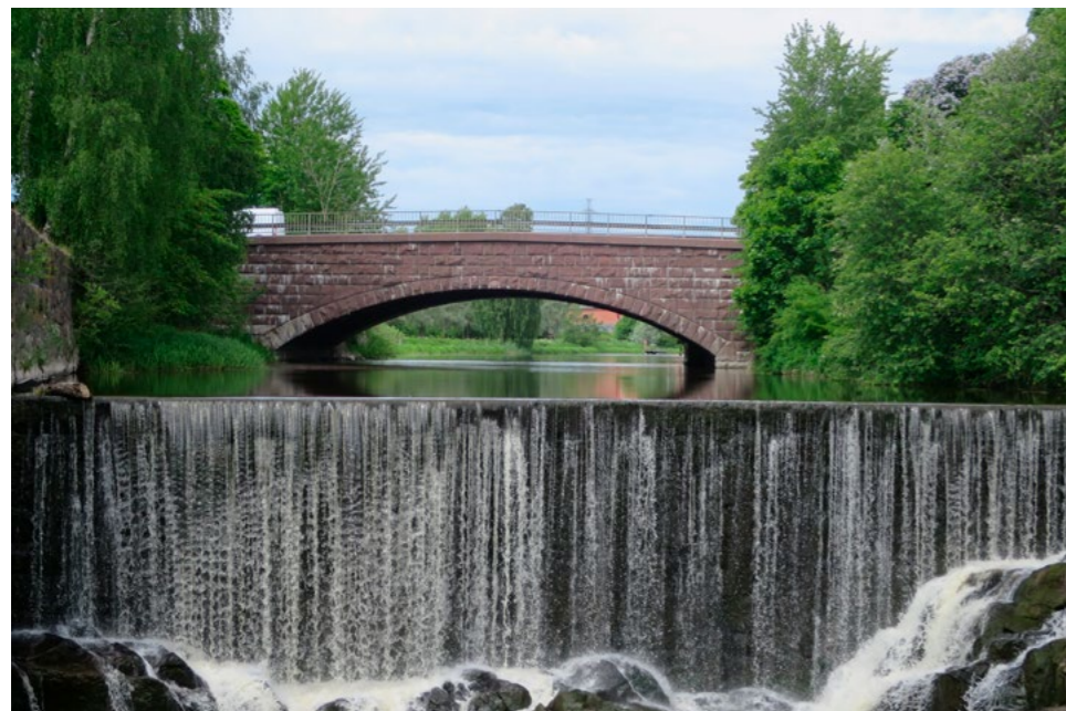
Kosken läntisen haaran graniittiharkoilla verhoitu ja kiviholvin kannattama silta (1) valmistui 1926. Birger Brunilan suunnitteleman sillan rakenteeseen sijoitettiin vesilaitoksen pääputket. Silta on suojeltu asemakaavassa.
