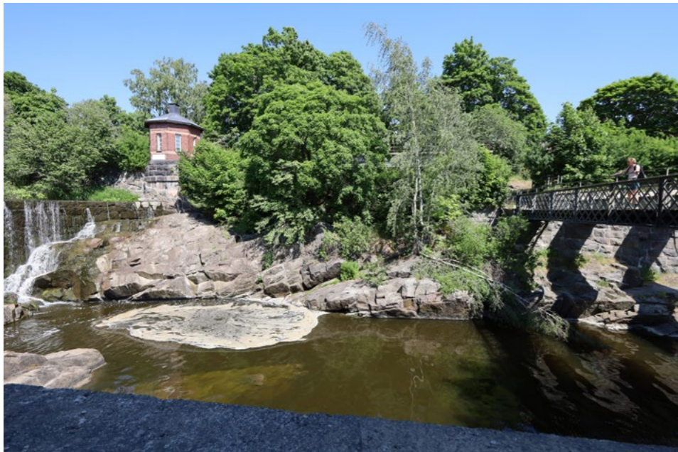
(5) Vedenottamon kivialustan eteläpuolelta on purettu korkealle kivilaiturille rakennettu puurakennus, jossa 1800-luvun lopulla toimi värjäämä ja pesula. Ristikkosillan oikealla puolella näkyy kalliolta kohoava tukimuuri.
