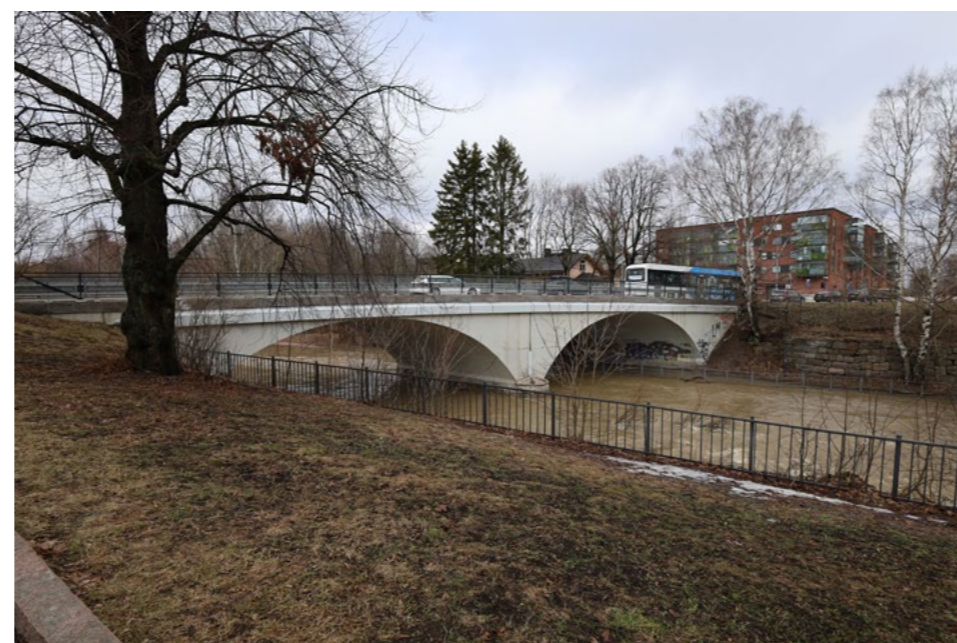
Itäisen koskihaaran betoniholvisilta vuodelta 1933 (2). Betonipinnat on pinnoitettu vaaleanharmaalla suojapinnoitteella. Silta on suojeltu asemakaavassa.
