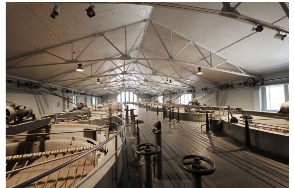
Pyöreät pikasuodatinalltaat on sijoitettu kahteen riviin. Kattorakenne on siro teräsristikko. Rakennus kuuluu Tekniikan museoon.
