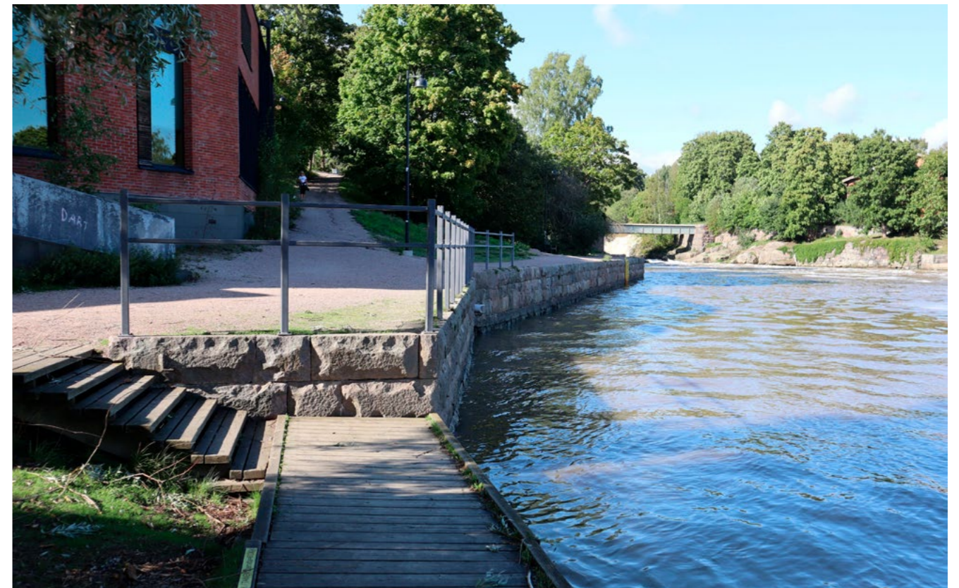
Puukannella katettu matala rantamuuuri mahdollistaa pääsyn lähelle vedenpintaa.
