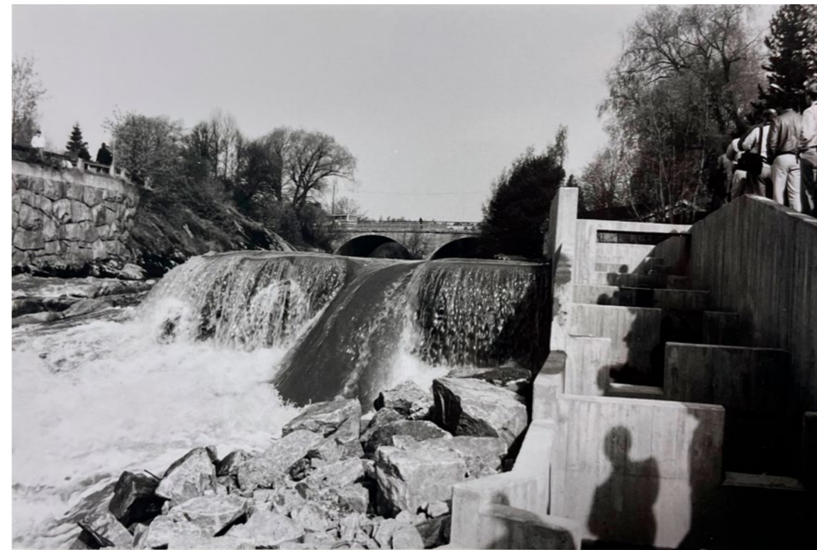
Itäisen koskihaaran betonirakenteiden kalaportaiden, ns. pystyrakokalatien avajaiset 1986. HKM
