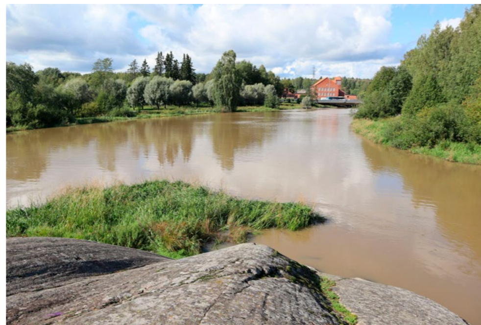
Pohjoisen suvannon yli avautuva näkymä, taustalla Koskelan saostuslaitos.
