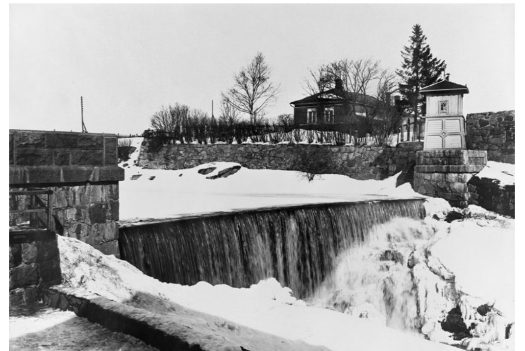
Näkymä padon yli Kuninkaankartanonsaaren rantamuurien suuntaan. Kuvassa näkyy puutarhan pengermuuri, sen päällä pensasaita ja oikealla siivilärakennus vuodelta 1895. Kuva noin 1904-1905, E.A. Bergius. HKM.
