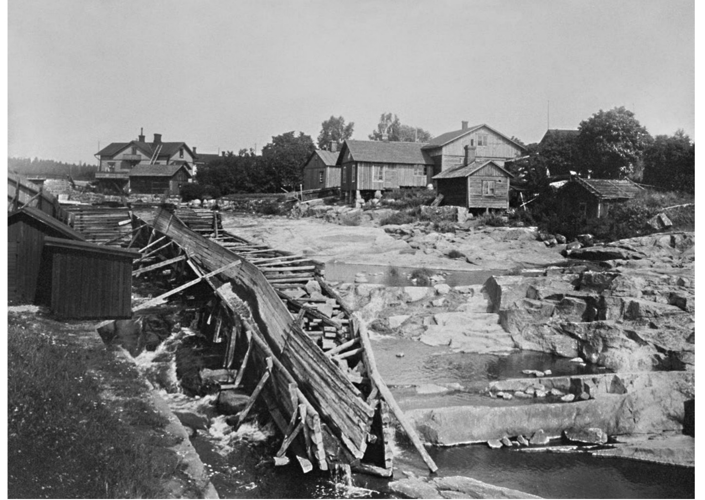
Itäiseen koskihaaraan rakennettu uittoränni. Sen vieressä näkyy jälkiä koskiuoman kalliopinnan muokkauksesta. Valokuva B. Tallgrén 1910-luvulla, HKM.
