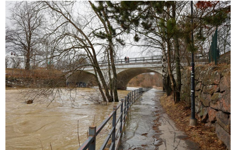
(18) Itäisen koskihaaran itärannalle rakennettu kävelyreitti myötäilee vanhempaa, kivistä rakennettua rantamuuria.
