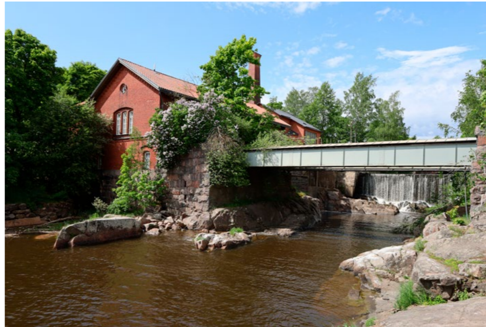
Vesilaitoksen turbiinipumppulaitos pumppuineen (2) vuodelta 1876 on kuulunut Helsingin kaupunginmuseon Voimalamuseoon vuodesta 2000. Voimala on poistettu käytöstä poisto ja turbiinikanava on tulpattu 2019.
