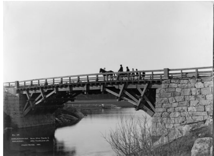
Läntisen koskihaaran vanha puinen silta korvattiin uudella kivrakenteisella sillalla 1926. Kuva 1890, Daniel Nyblin. HKM.
