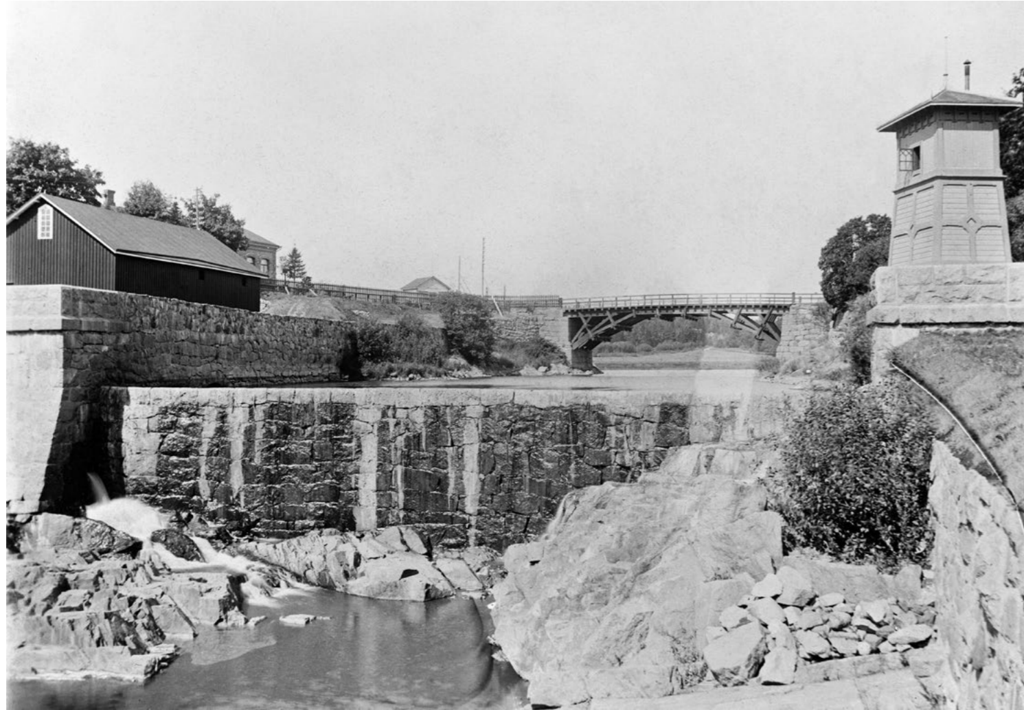
Vanhankaupunginkosken 1870-luvulla rakennettu kivipato ja patoallasta sivuavat rantamuurit sekä padon alapuolella olevat, kapeaa koskiuomaa rajaavat kalliot. Valokuva 1890-luvulta. Taustalla näkyy läntisen koskihaaran maantiesilta, oikealla puinen siivilärakennus. HKM
