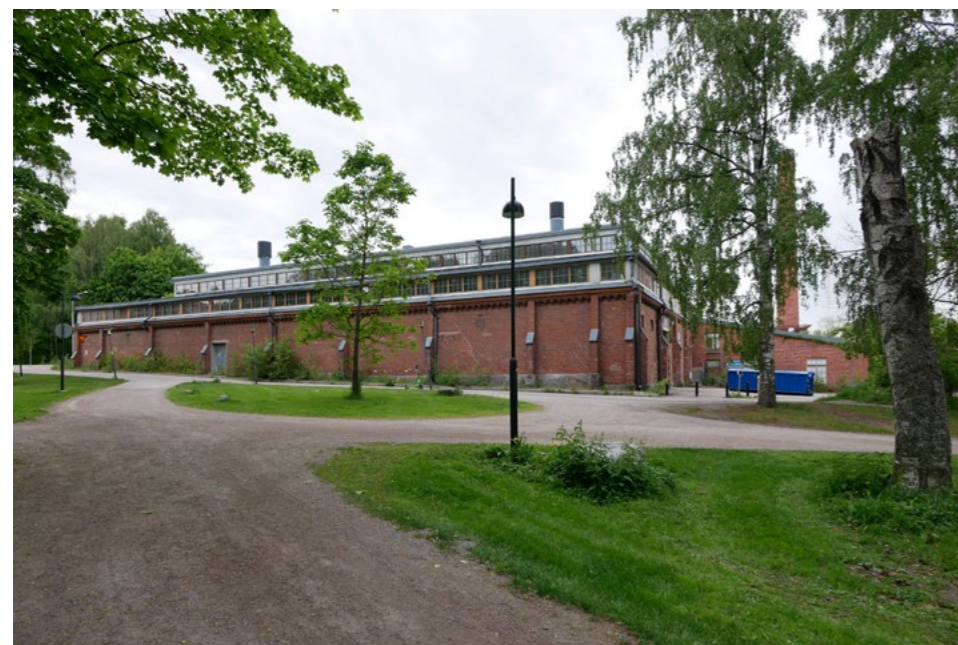
Verkatehtaan (9) eteläpuolinen julkisivu, taustalla näkyy tehtaan punatiilinen savupiippu.
