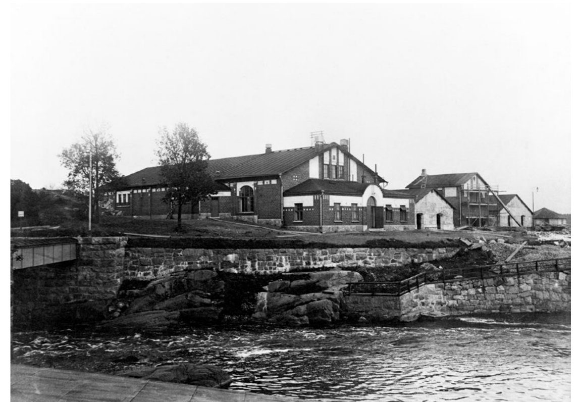
Hjalmar Åbergin suunnittelema uusi suodatinallasrakennus. Kuvausaika n. 1910, HKM.
