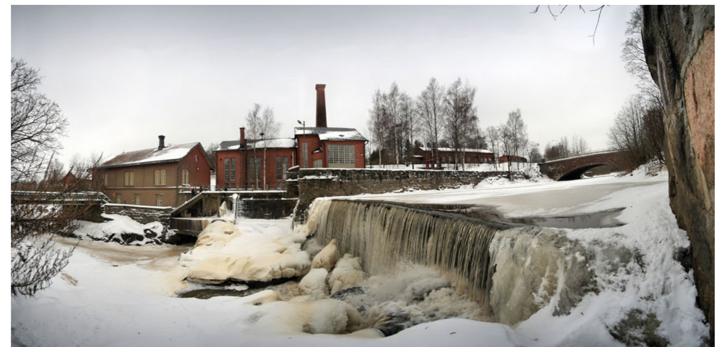
Vesilaitoksen pato 1870-luvulta on suojeltu asemakaavalla 10240. Kuva Matti Paavonen, CC BY-SA 3.0 < https://creativecommons.org/licenses/by-sa/3.0/ >, via Wikimedia Commons.
