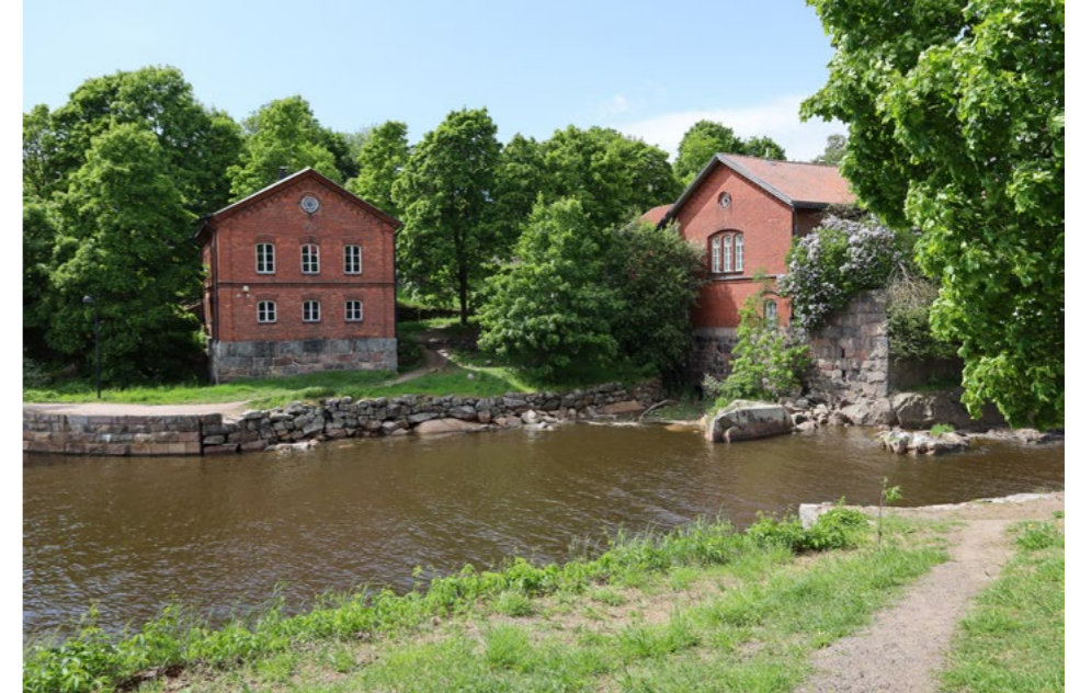
(10) Myllyn oikealla puolella näkyy 1876 rakennettu vesivoimalla toiminut pumppulaitos. Rakennuksen läpi ohjattu vedenvirta on purkautunut rantaan päädyn kohdalla, jossa rakennuksen alkuperäinen suhde rantaan vielä nähtävissä.
