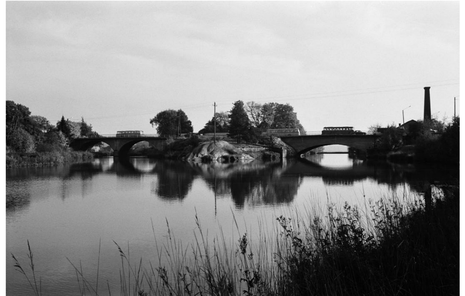
Kuninkaankartanonsaaren pohjoiskärki ja Viikintien sillat, jotka valmistuivat 1926 ja 1933 Tunnelmallisen maisemanäkymän on kuvannut Simo Rista 1970. Oikealla näkyy höyryturbiinilaitoksen savupiippu. HKM.
