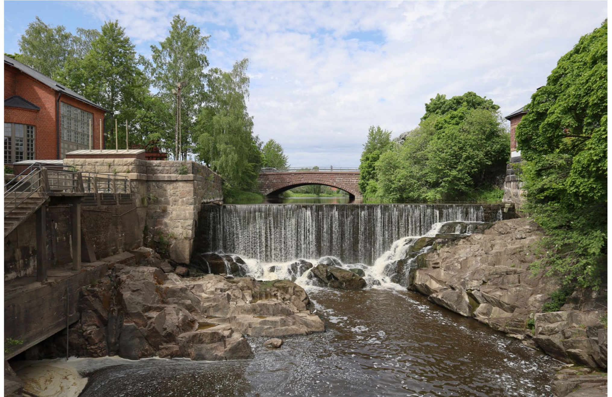
Vesilaitoksen vuosina 1872-1873 rakennettu, kivistä muurattu pato sijoitettiin kallioiden rajaamaan kapeaan koskiuomaan noin 3 metriä pohjoisemmaksi kuin vanhempi myllypato. Kosken länsirannalla sijainnut vanhempi myllyrakennus purettiin. Taustalla näkyy 1920-luvulla valmistunut, kiviharkoilla verhottu silta.
