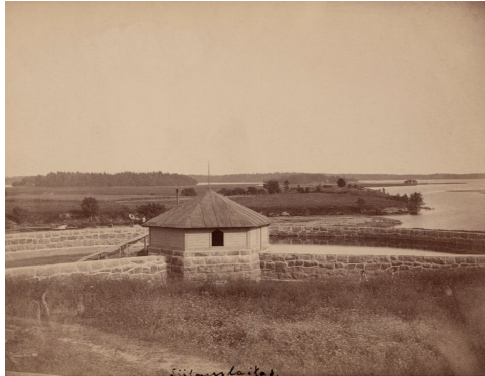
Vesilaitoksen ensimmäiset suodattimet olivat avoimia hiekkasuodattimia. Ympyrän muotoisen rengasmuurin rajaama allaskokonaisuus oli halkaisijaltaan 53,5 m. Keskellä oli katettu kaivo. Suodattimiksi johdatettiin vettä omalla paineella ilman pumppausta. Varhainen valokuva. HKM.
