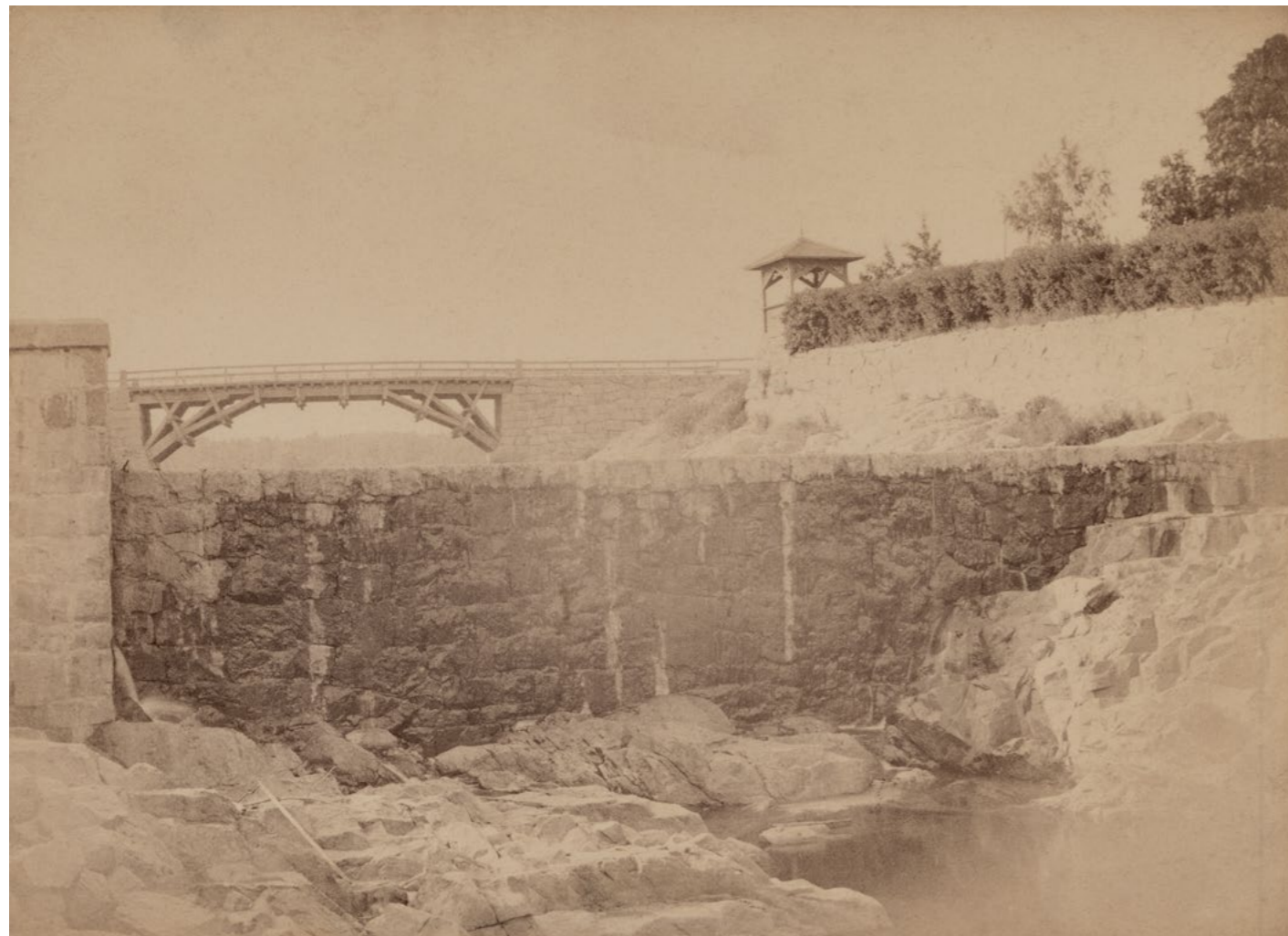
Vesilaitoksen pato, valokuva C. Hausen 1889. Taustalla näkyy puutarhan kulmassa kivimuurin päältä kohoava avoin paviljonki ja puurakenteinen maantiesilta. HKM
