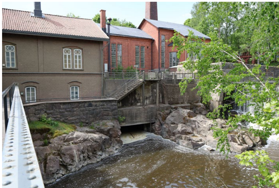
(11) Vuonna 1876 rakennetun vesiturbiinilaitoksen edessä on kivimuurin rajaama, ristikkosillalle johtava kulkureitti. Uudemman höyryturbiinilaitokseen liittyvät betonirakenteet luukkuineen näkyvät kuvassa oikealla.
