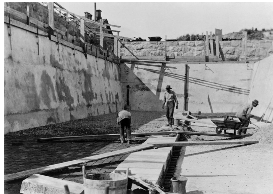
Uuden suodatinallasrakennuksen rakennustyömaa Kuninkaankartanonsaarella. Kuvausaika 1895, HKM.
