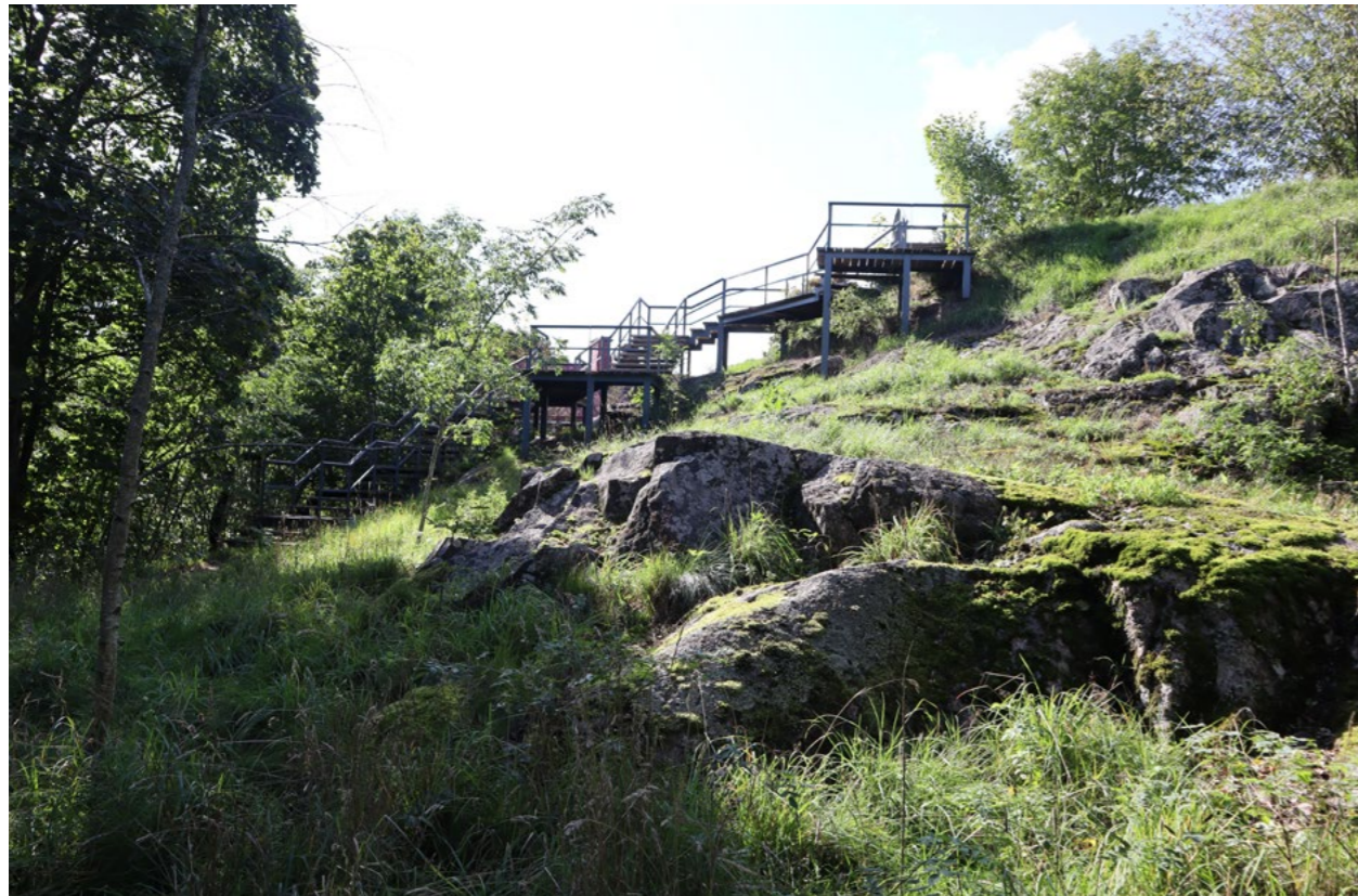
Kellomäelle kaakosta nousevat teräsportaat.
