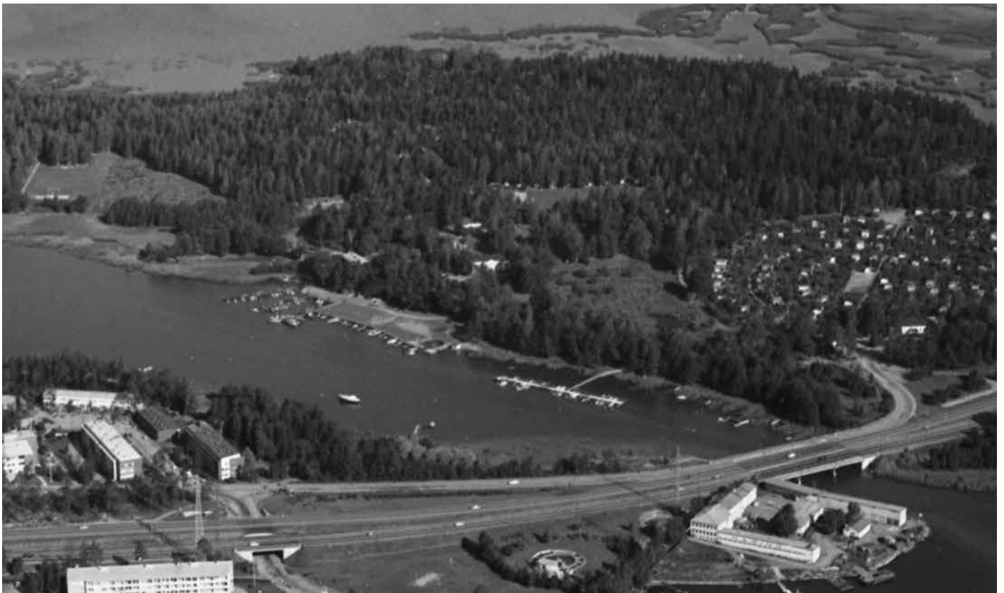
Kuva 52, viereisellä sivulla ylhäällä. Naurissalmen länsiranta vuonna 1965. Rantaa on täytetty satamatoimintoja varten. Sataman ja Naurissalmen sillan välissä on vielä yksittäisiä laitureita. Gunnarstorpinniemen ranta-alue on niitetty ja niemelle kulkeva tie näkyy puiden lomasta. Kuva B. möller. HKMKA.
