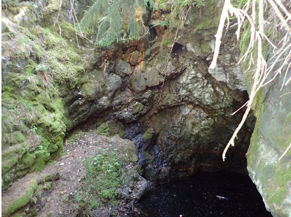
Kuva 21 Kaivoskuiluja puhdistetaan roskista ja suojakaiteiden kuntoa seurataan.
