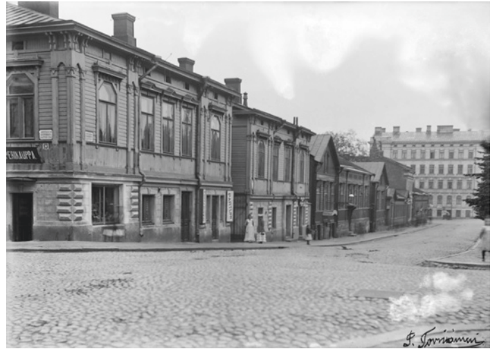
Yllä: kuva Punavuorencatua koilliseen, kohti Fredrikintoria. Ratakadun kulmalla oleva rakennus on paikoillaan nykyisinkin, mutta Punavuorencatua reunustavat vielä matalat puutalot on purettu. Torniainen, P. 1900-luvun alku. HKMKA.
