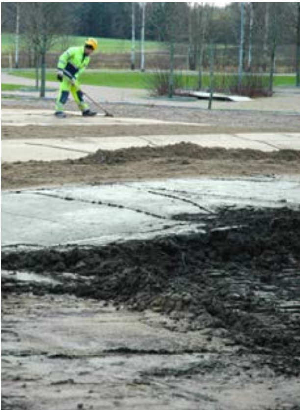
Kuva 47. Uusien niittyjen rakentaminen on yksi niittyverkoston kehittämisen keinoista. Kuvassa syksyllä 2020 Viikin Maaherranpuiston OmaStadi-niityn rakentamista nurmikon tilalle kierrätysmaakasvualustalla.
