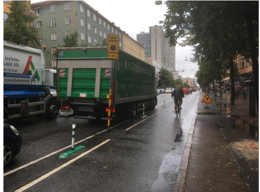
Kuva 4 Götgatanille toteutettu väliaikainen pyöräkaista Tukholmassa
