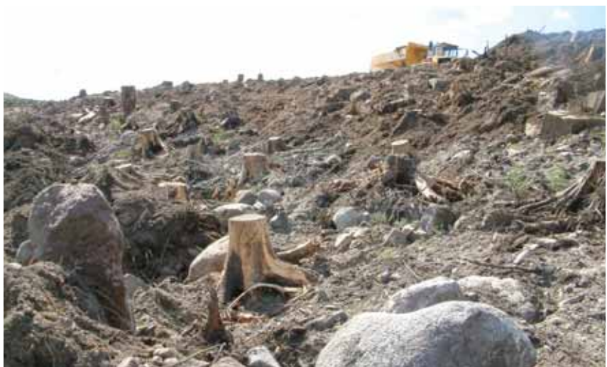
Laen itäreunalta pohjoisen suuntaan. Pinta on viimeistely asettelemalla suuria, ehyinä otettuja kantoja ja kookkaita maakiviä. Tämän jälkeen siirrettiin vielä kenttäkerroksen kasvillisuutta pienialaisiksi laikuiksi, joista kasvillisuus voisi levitä ympäristöönsä. Kuva on otettu itärinteeltä lounaan suuntaan v. 2003.
