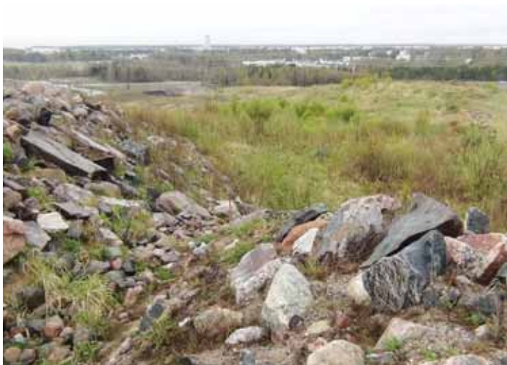
Alkuperäisen huipun ja huipun laajennoksen rajakohtaan tehtiin valuntaja jakava uoma. Alhaalla taustalla näkyy siirretyn lehdon aluetta, jonne vesiä ohjautuu. Kuva on otettu vuonna 2014.
