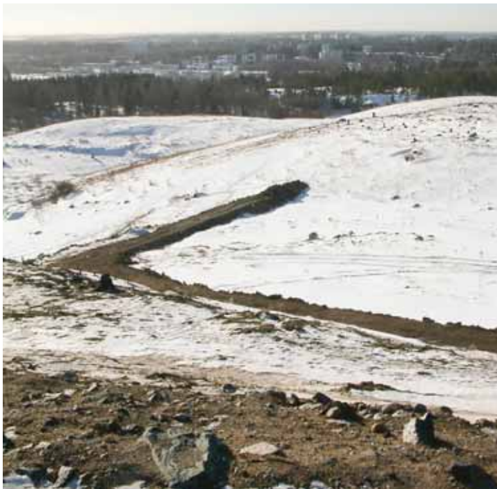
Siirrettävän lehdon paikaksi valitun alueen etelä- ja itäreunaan teh- tiin kantavat työmaatiet, kuvassa alueen eteläosa. Taustalla vanhan maantäytön takana näkyy entistä kaatopaikkaa.
