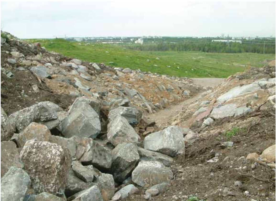
Solan alaosa rakenteilla vuonna 2004.
