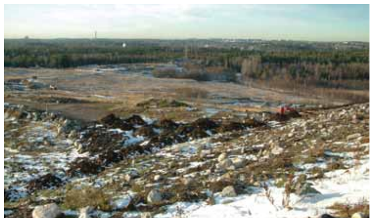
Marraskuussa 2003 tuotiin metsämaita lehtorinteen rakentamiseen. Aiempi pinta oli paikoin hyvin kivistä ja karkearakeista maa-ainesta. Taustalla entisen kaatopaikan aluetta, oikeassa reunassa näkyy Porsvarinlahtea.
