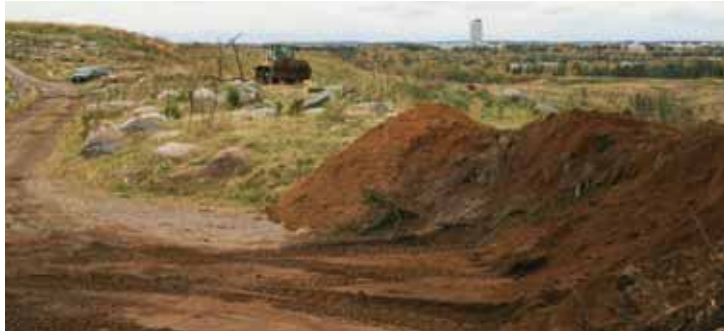
Työ aloitettiin kauhakuormaajan takaa näkyvältä alueelta. Aiemmin istutetut katajat ja suuret kivet nostettiin ylös ja sijoitettiin uudelleen maa-ainesten lisäyksen jälkeen. Etualalla näkyy tyypillisiä, uudeksi kasvualustaksi käytettyjä maa-aineksia. Kuva on otettu laen kääntöpaikalta etelään keväällä 2009.
