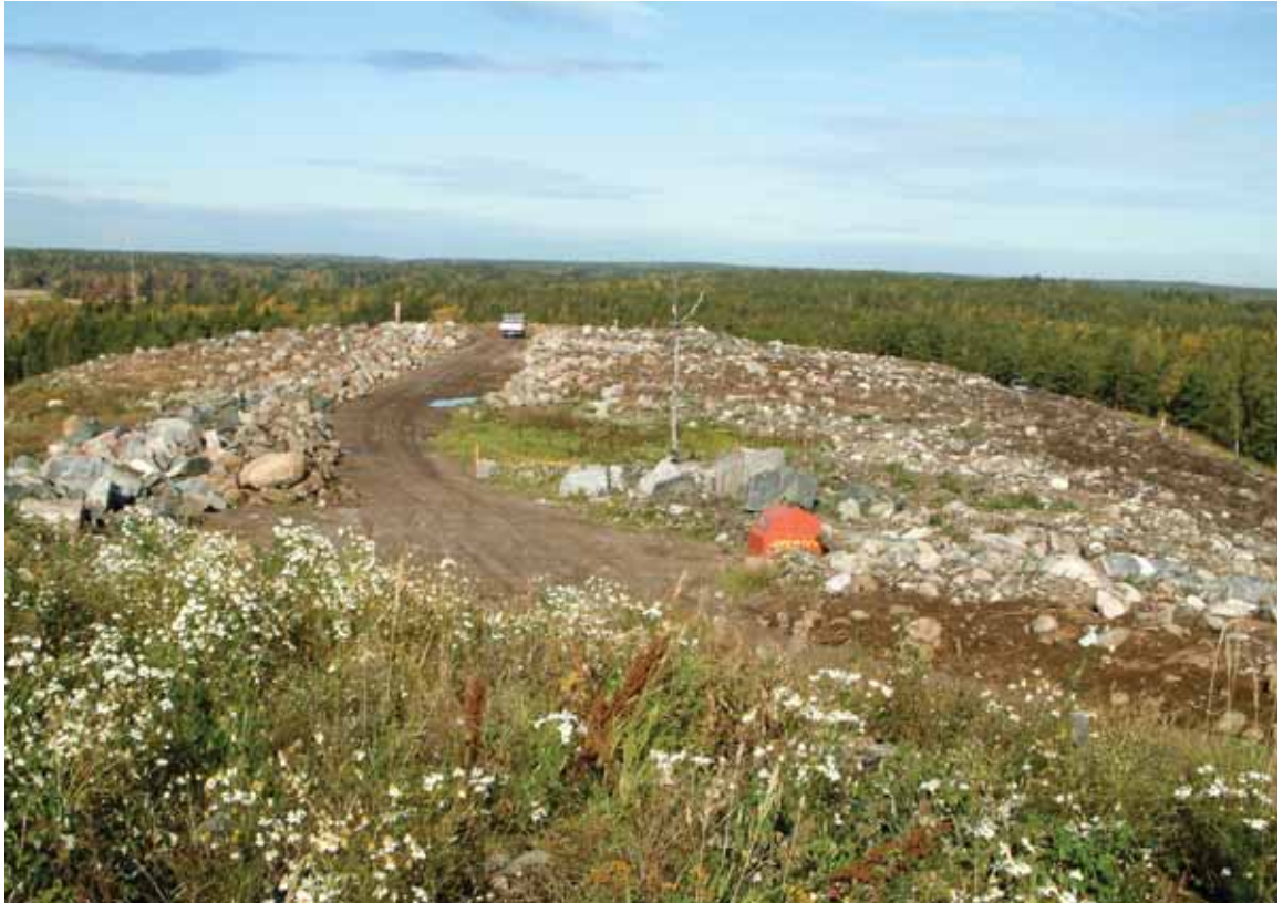
Laen aluetta kasvialustakerrosten rakentamisen jälkeen, näkymä on pohjoisen suuntaan. Kuva on vuoden 2003 lokakuulta.
