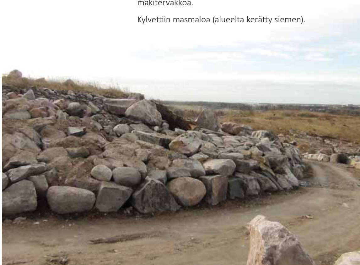
Ylärinteessä laelle johtavan reitin reuna tuettiin kivrakenteella. Kuva on vuodelta 2015.
