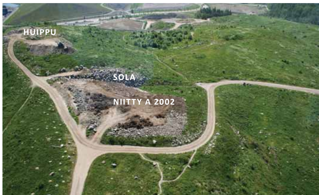
Huipun ja solan, sekä laen eteläpään uudelleen rakentaminen on käynnissä vuonna 2011. Kuvasta voi todeta lisätyt, useita metrejä paksut maa-aineskerrokset. Kuvakulma avautuu etelään.
