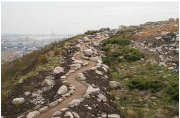
Huipulle noussut tie kavennettiin mutkittelevaksi reitiksi. Hulevedet valuvat mutkissa reunakivien väleistä rinteisiin ja pinta säästyy vesieroosiolta. Oikeassa reunassa säästetty katajakivikko, joka on rakennettu v. 2003, kuva otettu marraskuussa v. 2011. Vertaa kuvaan marraskuulta 2008 (s. 77), paikka on sama molemmissa kuvissa.
