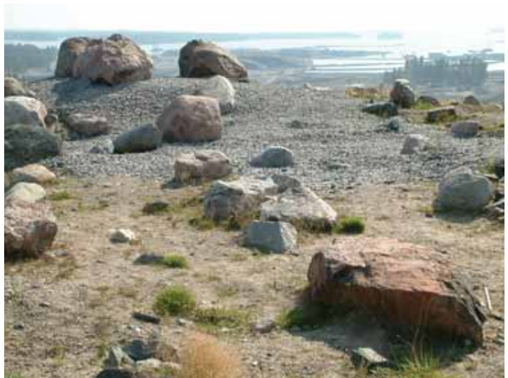
Huipun uudelleen rakennettua pintaa vuonna 2005, oikeassa reunassa näkyy kaistale v. 2002 pintarakennetta.
