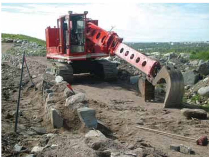
Kiviaitaa rakennetaan v. 2005.
