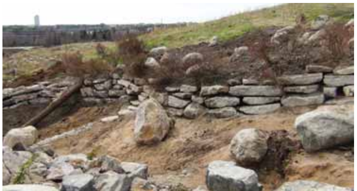
Kierrätysbetonilohkareista rakennettua muuria, joka rajaa oikealla rinteessä olevan koerakenteen. Kuva on otettu toukokuussa 2013 ruusujen siirron jälkeen.
