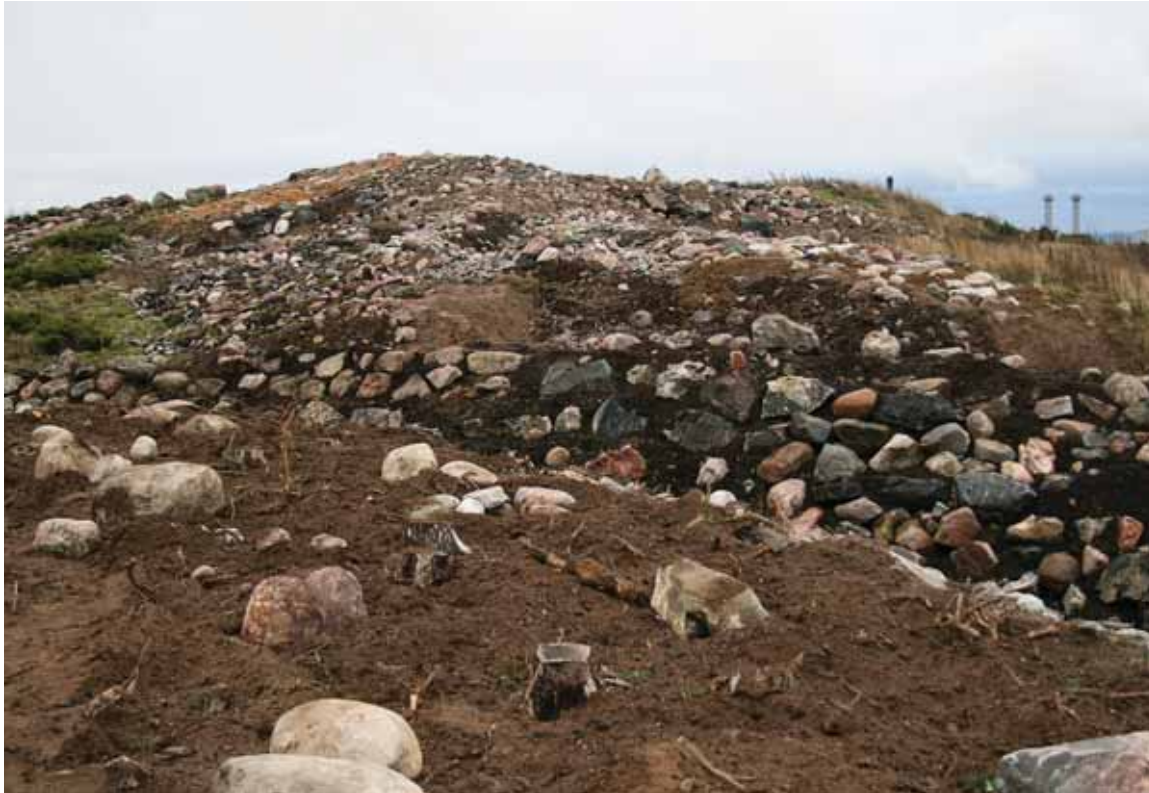
Laajennettu huippu solan pohjoisreunalta katsottuna oli vaikuttavan näköinen rakentamisen päätyttyä.
