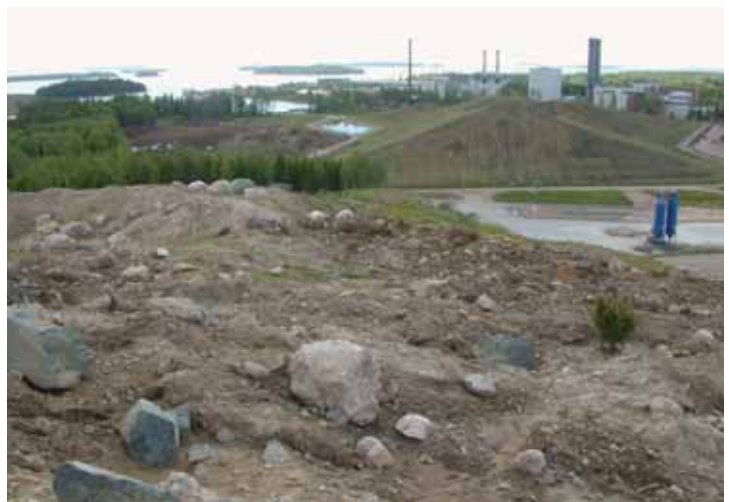
Eteläreunaa, johon siirrettiin katajia kaatopaikalta sekä aivan reunavyöhykkeelle istutettiin kotimaisia luonnonruusulajeja. Vasemmalla näkyy maansiirtokoneen painosta syntynyt vajoama, oikealla siirretty kataja.
