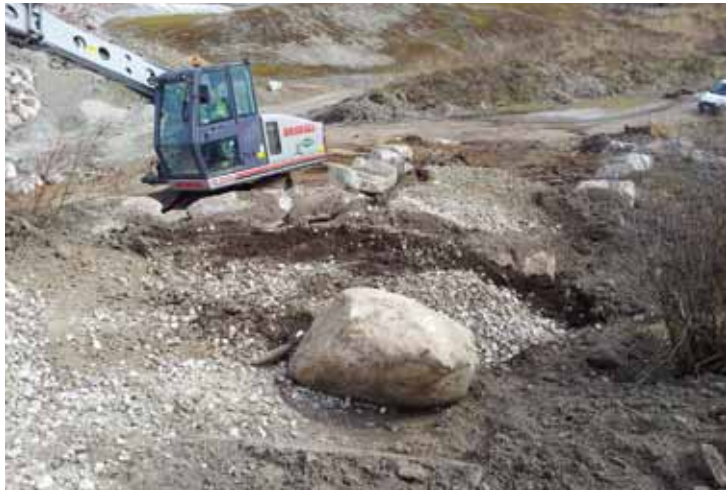
"Kalkkimaannoksen" pintakerrosta rakennetaan betonimurskeesta ja pintamaista keväällä 2013.
