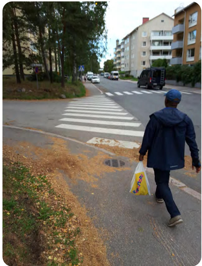
Kuva 45. Puutteellisia suojatieratkaisuja Hiihtomäentiellä.
