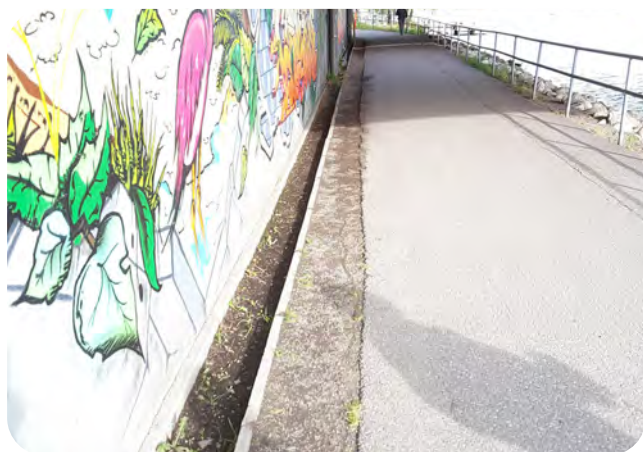
Kuva 69. Päällysteen rajautuminen kouruun ja kourun kunto.
