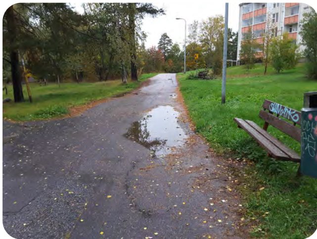
Kuva 77. Raitilla on painumia ja puiden juuret rikkovat päällysteen.
