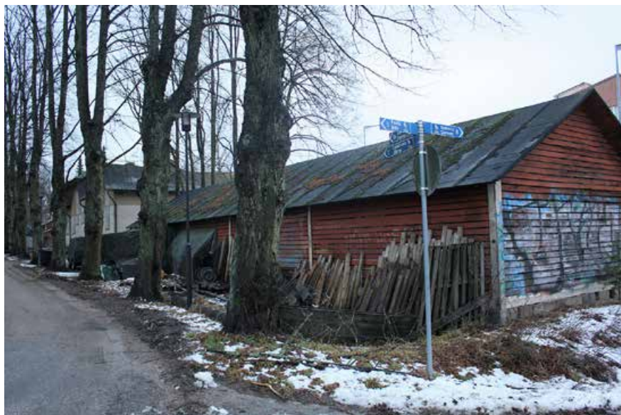
Kuva 73. Asuinkasarin talousrakennuksen taustalla on varastoalue. Ne sijoittuvat häiritsevästi lehmutkujanteen vierelle.
