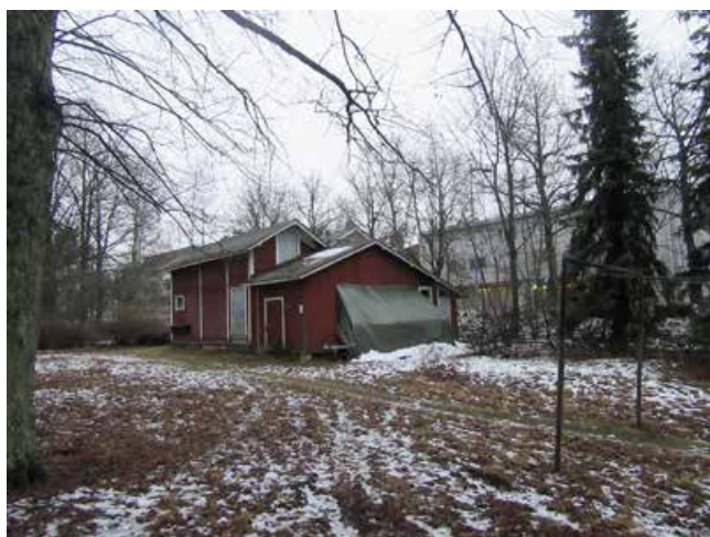
Kuva 53. Alun perin asemarakennuksessa asuneelle virkamiehen pihapiiriin kuulunut ulkorakennus, johon sittemmin remontoitu alueen vuokralaisten saunatilat. Kuvan etualalla entinen hyötytarha, jonne istutettiin 1970-luvulla havupuita.
