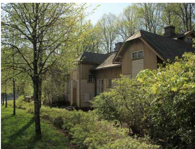
Kuva 54. Vuonna 1908 valmistunut asuinkasarmi, jonka edustalle on istutettu 2000-luvulla uusi lehmusrivi korvaamaan katualueelta poistunutta puuriviä. Kookas koivu on jätetty lehmusrivin vierelle. Pensaidanne istutettiin samanaikaisesti niiden väliin.
