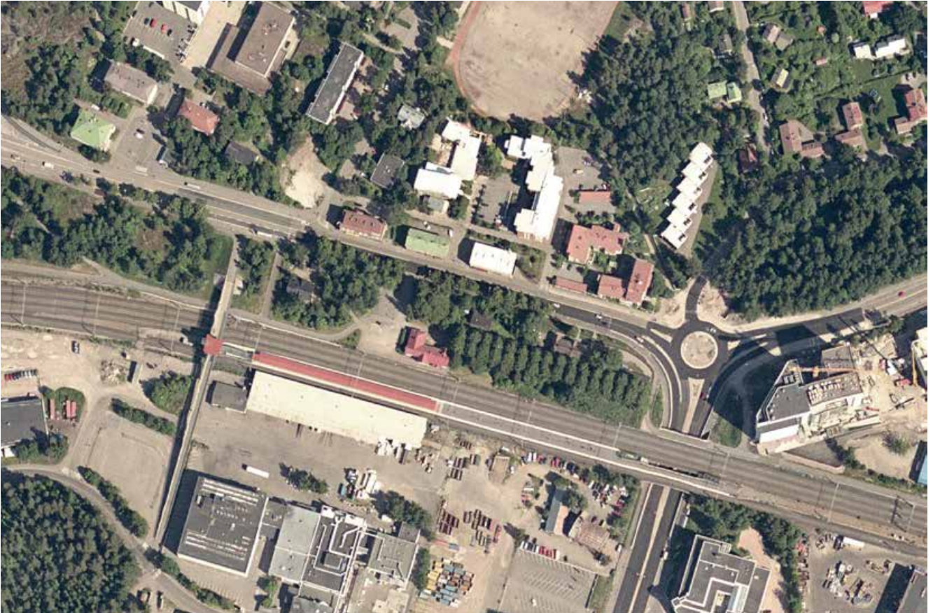
Kuva 46. Ilmakuva 2005. Pitäjämäen ja Kaupintien risteykseen on juuri valmistunut liikenneympyrä.
