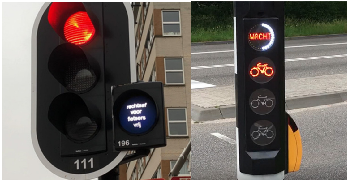
Kuva 23 Lisäopastin sallii pyörien kääntyä oikealle vasten punaista valoa. Pyöräopastimeen liitetty odotuskello. (Wagenbuur 2018)
