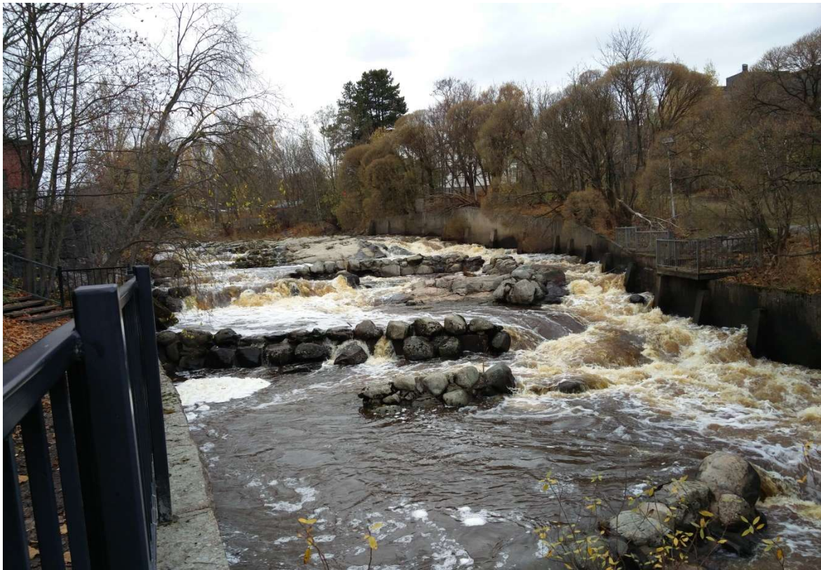
Kuva 5. Tukkirännin paikalle tehtiin 1999 tasanteet helpottamaan vaelluskalojen nousua. Mikäli tällöin tukkirännin rakenteita oli jäljellä, ne todennäköisesti tuhoutuivat rakennushankkeessa. Taustalla kohde 03, IVO:n vedenottoputken betoninen tukimuuri itärannassa. Kuva: Immi Wallin, SubZone Oy, 25.10.2017.
