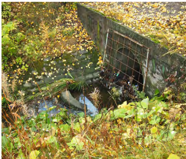
Kuva 32. Kumpulanpuro uoman rakenteita.
