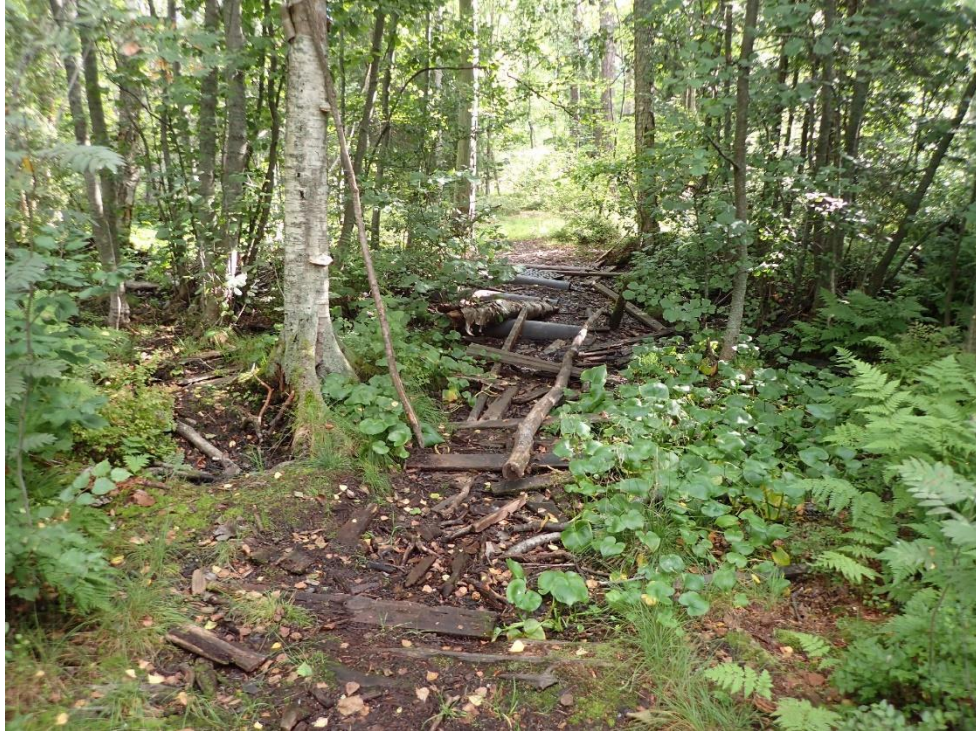
Kuva 19 Vanhat pitkokset ja muut rakenteet poistetaan korvesta.
