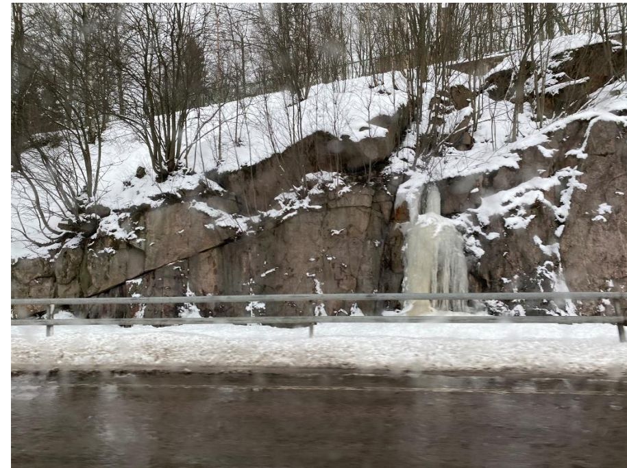
Kuva 30. Havaittu jääpaanne talvella 2023 noin pl. 400 kohdalla (Kuva: Niko Palo, Ramboll)
