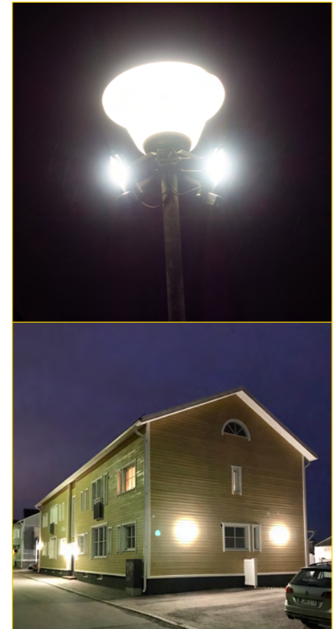
Ylemmässä kuvassa vanhaan pylväsvalaisimeen asennettu häikäisevä tuplavalaitus. Alemmassa kuvassa ylimitoitettu pihavalaitus toteutettuna myös taivaalle valoa suuntaavilla valaisinmalleilla.
