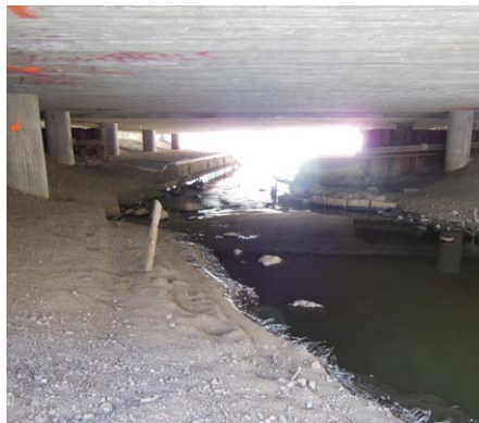
Kuva 41. Vesistöalikulku, johon yhdistetty kuiva tasanne. Vesistöalikulku, jossa maapenkereet uoman reunoilla (Strömbergin puisto). Kuva: Lauri Erävuori.
