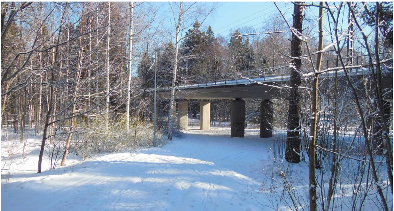
Kuva 35. Runsaan vapaan tilan jättävät siltarakenteet mahdollistavat myös luonnonympäristön jatkumon sillan alitse. Kuvan mukainen ratkaisu on esimerkki ekologisesti hyvin toimivasta ratkaisusta, joka palvelee monen kokoista eläimistöä. Kehärata, Pohjois-Haaga. Kuva: Lauri Erävuori.
