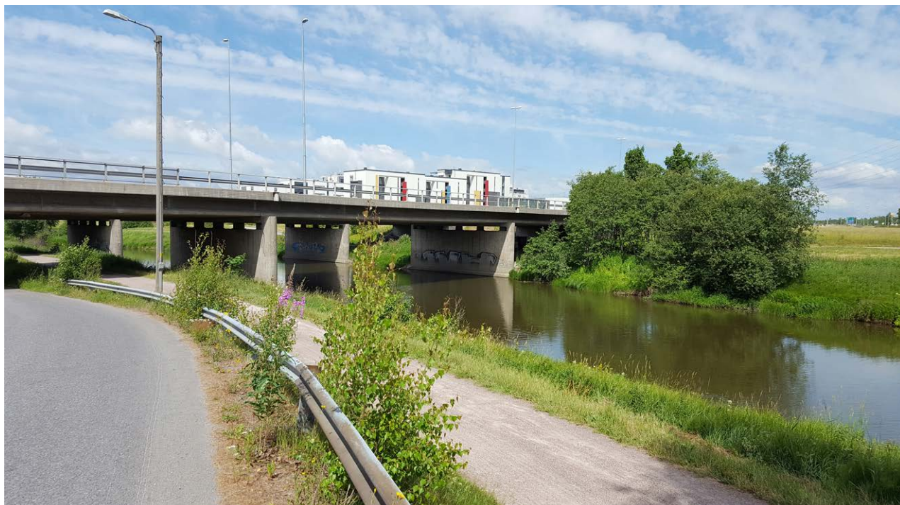
Kuva 33. Jokien ja vesistöjen ylityksissä siltarakenteen on toteutettu siten, että rannoilla on sillan alittava maakaistale, jota myöten eliölajit voivat liikkua jokivartta myöten. Tuusulan moottoritie, Vantaanjoen ylitys). Kuva: Tiina Saukkonen.
