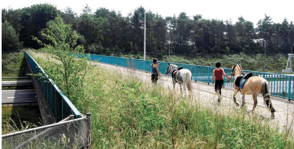
Kuva 39. Esimerkki kapeasta ylikulusta, jossa on yhdistetty kulkuväylä ja kasvillisuusvyöhyke. Lähde: U.S. Department of Transportation 2011. Kuva: Marcel Huijser.
