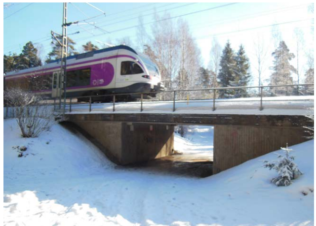
Kuva 34. Monikäyttöalikulku eläimistön ja ihmisten käyttöön (vasen kuva). Ihmisten käyttöön tehty alikulku, jota myös eläimistö voi käyttää (oikea kuva). Alikulkuna tällainen ei ole yhtä toimiva kuin kasvillisuusvyöhykkeen sisältävä alikulku. Kuvat: Lauri Erävuori.
