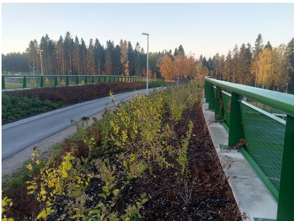
Kuva 40. Viikin puistosilta Kivikossa, jossa on yhdistetty kulkuväylä ja kasvillisuusvyöhyke. Eläimistön liikkuvuuden kannalta luontaisen kaltainen kasvilajisto olisi toimivampi ratkaisu kuin ryhminä istutetut matalat pensaat (vrt. kuva yllä). Kuva: Lauri Erävuori.
