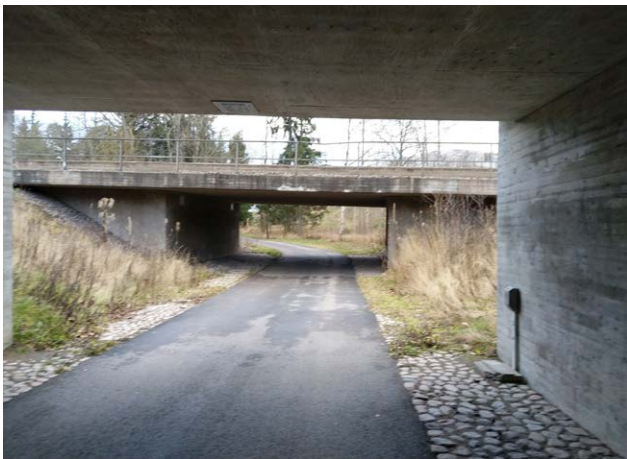
Kuva 34. Monikäyttöalikulku eläimistön ja ihmisten käyttöön (vasen kuva). Ihmisten käyttöön tehty alikulku, jota myös eläimistö voi käyttää (oikea kuva). Alikulkuna tällainen ei ole yhtä toimiva kuin kasvillisuusvyöhykkeen sisältävä alikulku. Kuvat: Lauri Erävuori.
