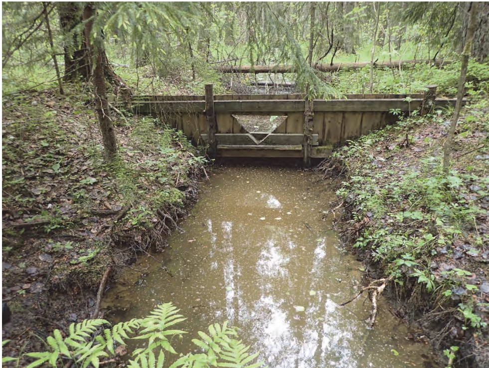
Kuva 26 Levypadoilla on säännöstelty ennallistamisalueen veden liikkumista.
