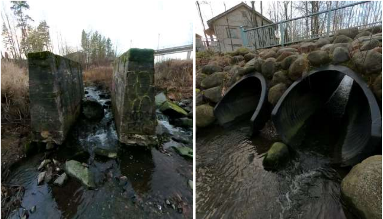
Kuva 25. Vas. Vanhan padon rauniot. Oik. Puro alittaa ulkoiluraitin rummuissa, jotka voivat olla osittainen nousueste kaloille.
