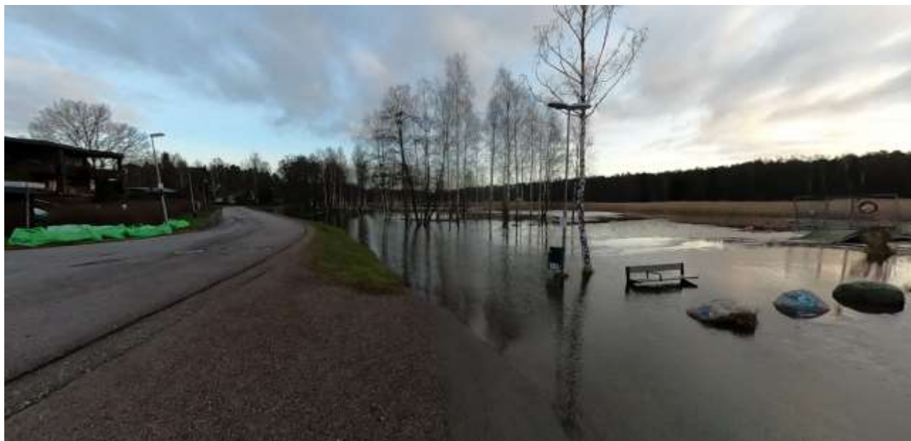
Kuva 51. Vartiokylänlahden länsiranta on hyvin alavaa. Kevyenliikenteenraitti on jäänyt meriveden alle Varjakankujan kohdalla. Kuvaushetkellä merivesi oli Kaisaniemen mittausasemalla n. +0,83 m.
