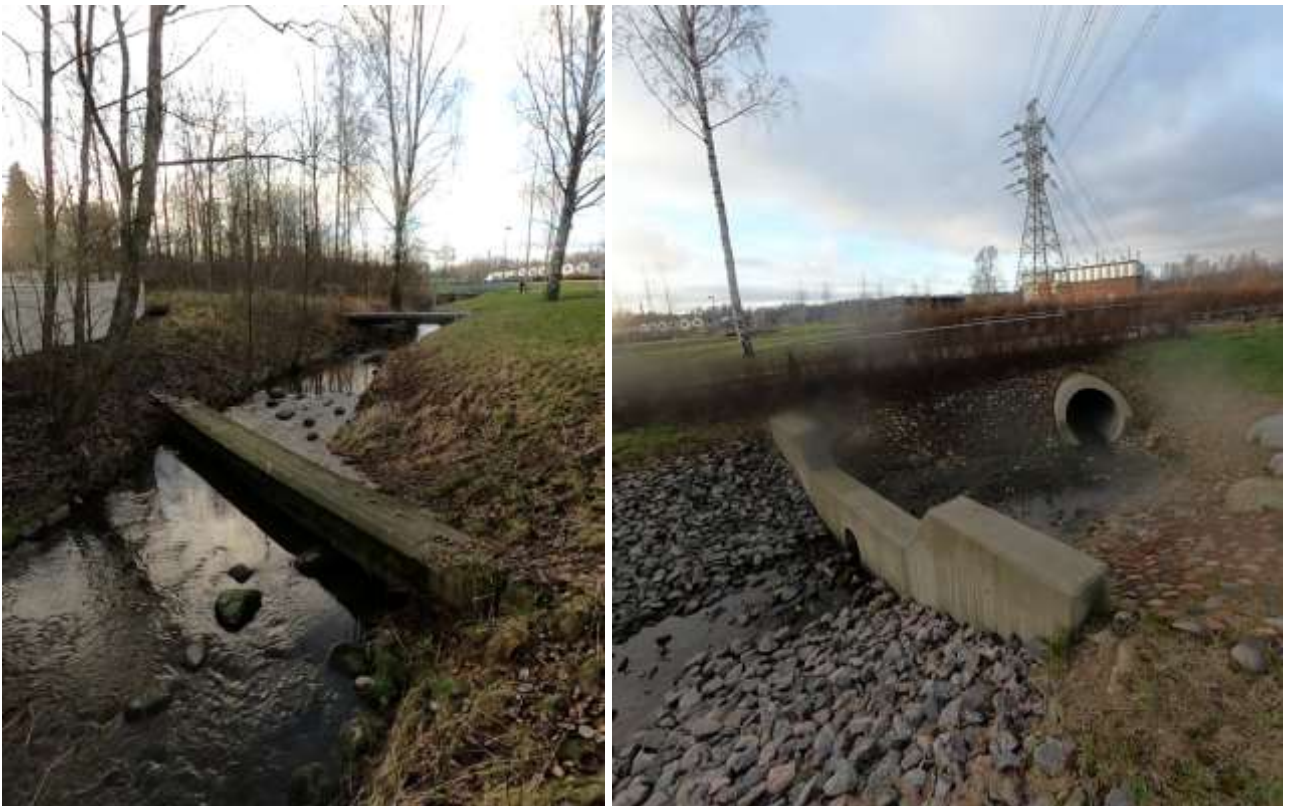
Kuva 26. Vas. Mellunkylänpuron ylittää kunnallisteknisiä johtoja koteloituina aivan vesirajassa. Oik. Linnanpellonpuistossa puroon yhtyy Naulakallion alueen hulevedet viivytysrakenteen kautta. Varsinainen viivytystilavuus on rummun toisella (ylävirran) puolella.
