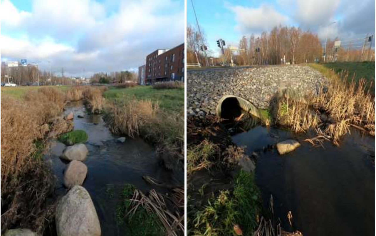
Kuva 17. Vas. Mellunkylän puro virtaa Itäväylän vieressä. Oik. Puro alittaa Itäväylän 2 x 1600 mm rummuissa.
