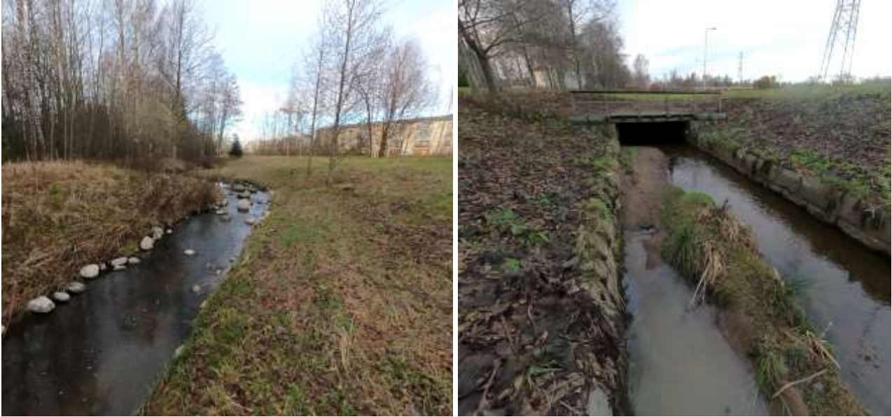
Kuva 28. Vas. Mellunkylämpurossa on rakennettu virtapaikkoja Länsimäentien varressa. Oik. Mellunmäen metroaseman pitkän putkitetun osuuden alapuolelle on kertynyt hyvin paljon hiekkaa.
