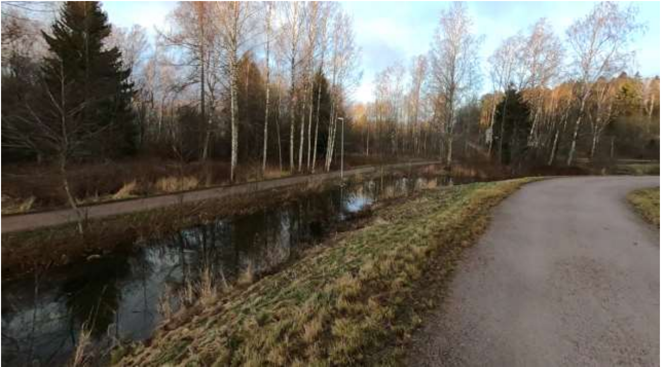
Kuva 41. Broändanpuron alajuoksulla se kulkee hiljattain rakennetun meritulvavallin vieressä.
