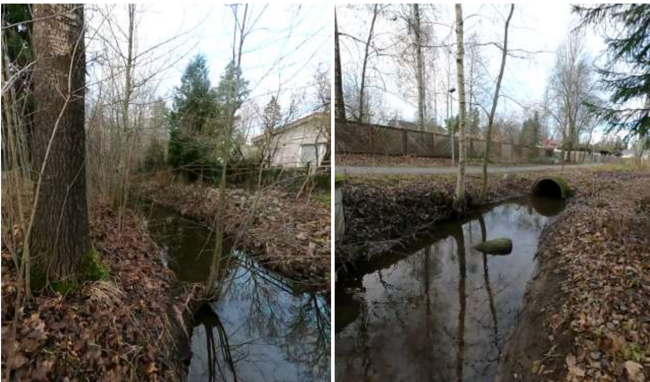
Kuva 33. Vas. Vesalanpuiston yläosassa Mellunkylänpuro virtaa metsikön ja pientalojen välissä. Oik. Vesalanpuiston yläpäässä (pohjoispäässä) puro tulee ulos pitkästä putkituksesta.
