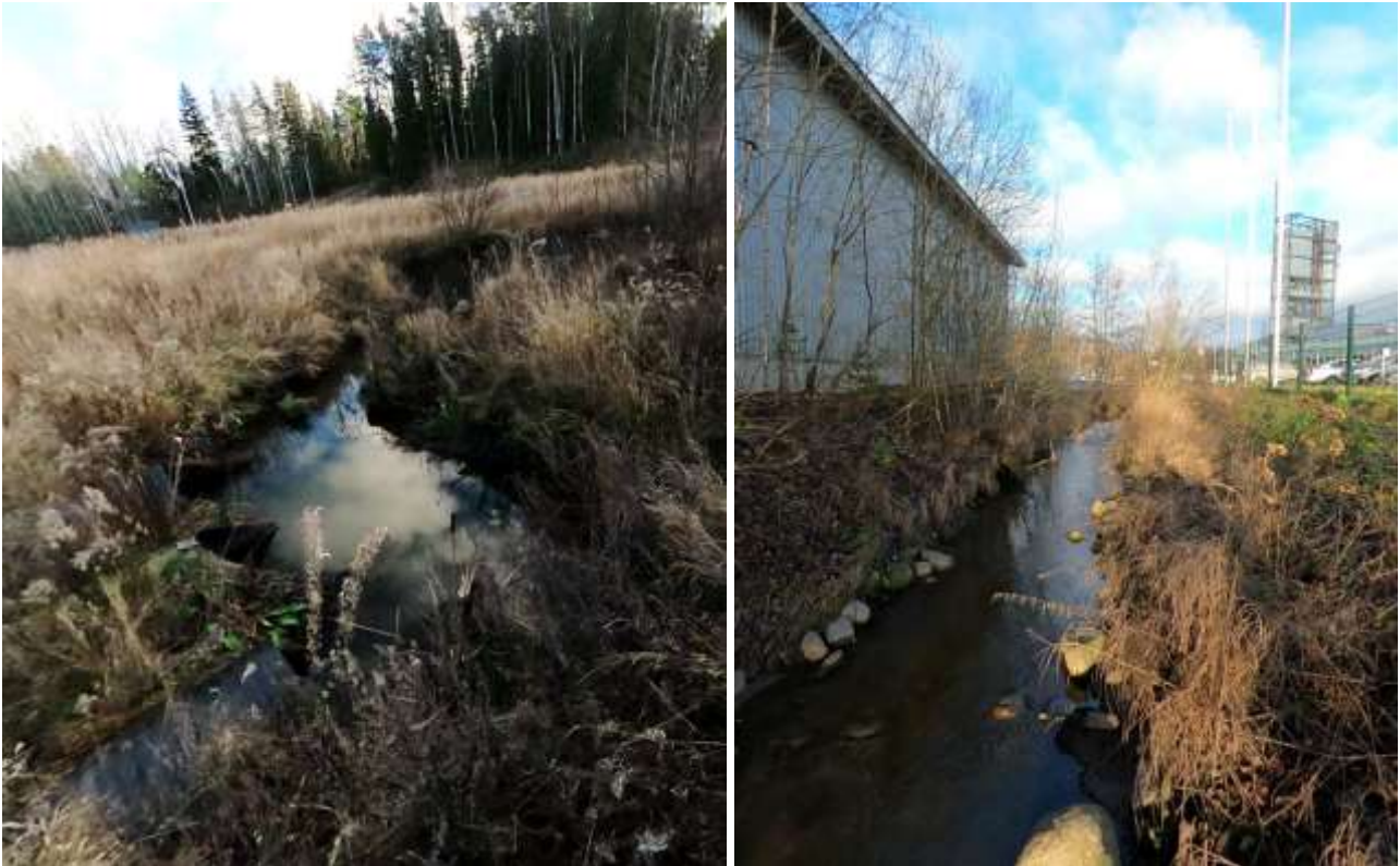
Kuva 16. Vas. Mellunkylänpuron alimman putkitetun osuuden alapäässä penkat sortuvat puroon. Oik. Mellunkylänpuro virtaa pitkien putkitettujen osuuksien välissä avoimena pelastuslaitoksen ja teollisuuskiinteistön välissä.
