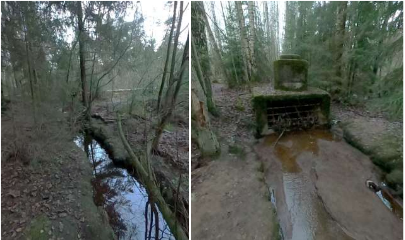
Kuva 39. Vas. Mellunkylänpuron latvoilla se virtaa metsäojana Slåtmossenin alueella. Oik. Suuri hulevesiviemäri purkaa ojaan keskelle metsää.
