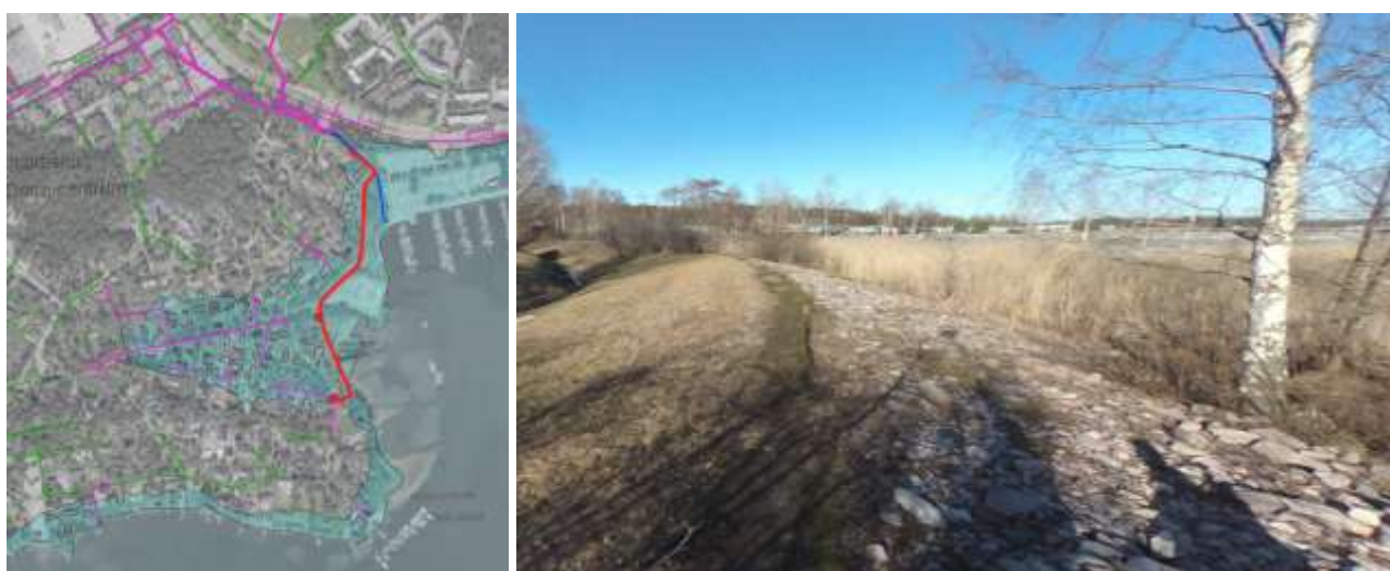
Kuva 52. Marjaniemen tulvavalli suojaa asuinkiinteistöjä merivesitulvilta, mutta +2,8 m tulva ylittäisi vallin ja peittäisi sen tausta-alueen. Valokuva vuodelta 2019.
