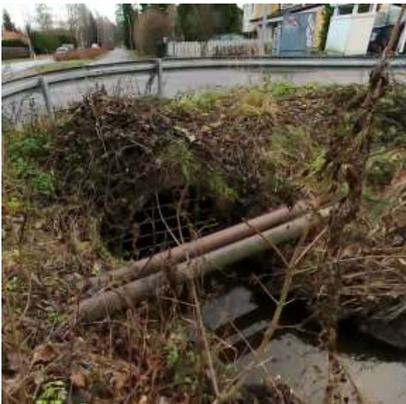
Kuva 36. Vas. Vesalantien pitkän putkituksen yläpäässä on ritilä. Oik. Mellunkylänpuro Vesalantien osuudella.
