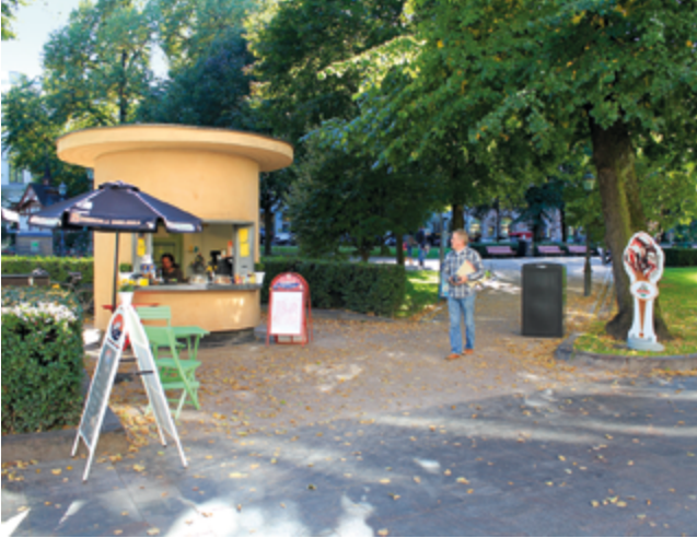
Kuva 171. Gunnar Taucherin v. 1928 suunnittelema kivirakenteinen kiosk. Kioskin edustalla on runsaasti sekalaisia mainoskylttejä ja muita kalusteita ja varusteita. ML 2016.
