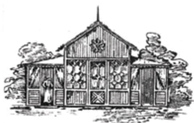
Kuva 28. Sokerileipuri Johan Daniel Jernbergin rakennuttama pieni myyntiköju purettiin Hampus Dalströmin suunnitteleman uuden "Kappelin" ravintolarakennuksen tieltä. HKMKA.
