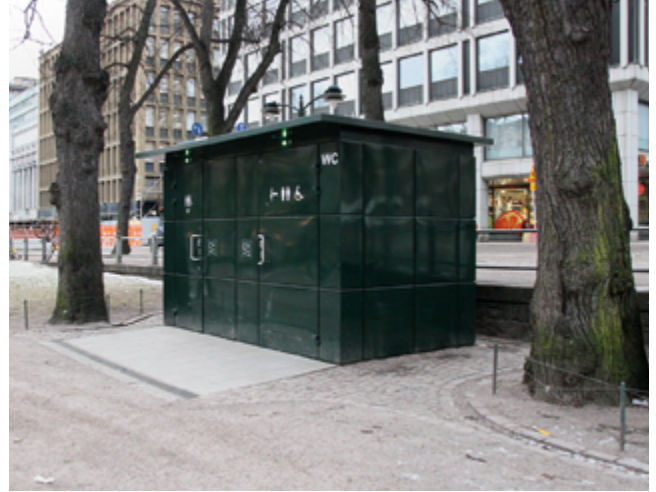
Kuva 172. Teatteriesplanadin etelälaidalla oleva City-WC on vuodelta 2015. LP 2017.
