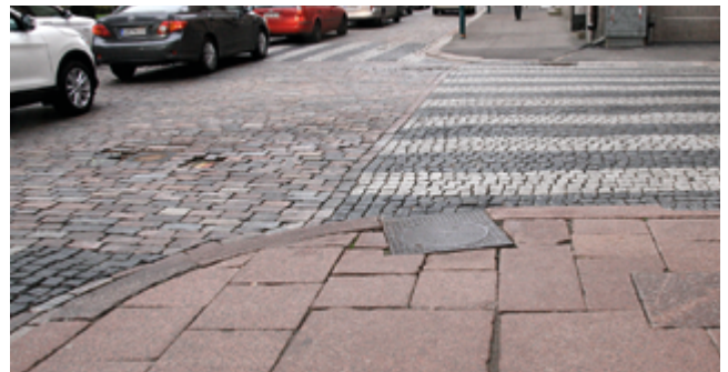
Kuva 118. Eteläesplanadin ajorata on nupukiveä ja suojatiet on ladottu mustista ja valkoisista noppakivistä. Eteläesplanadi 14:n rakennuksen edusta on pinnoitettu suurin punaisin graniittilaatoin. Kävelytien rajaa ajoradasta graniittireunakivi. LP 2016.
