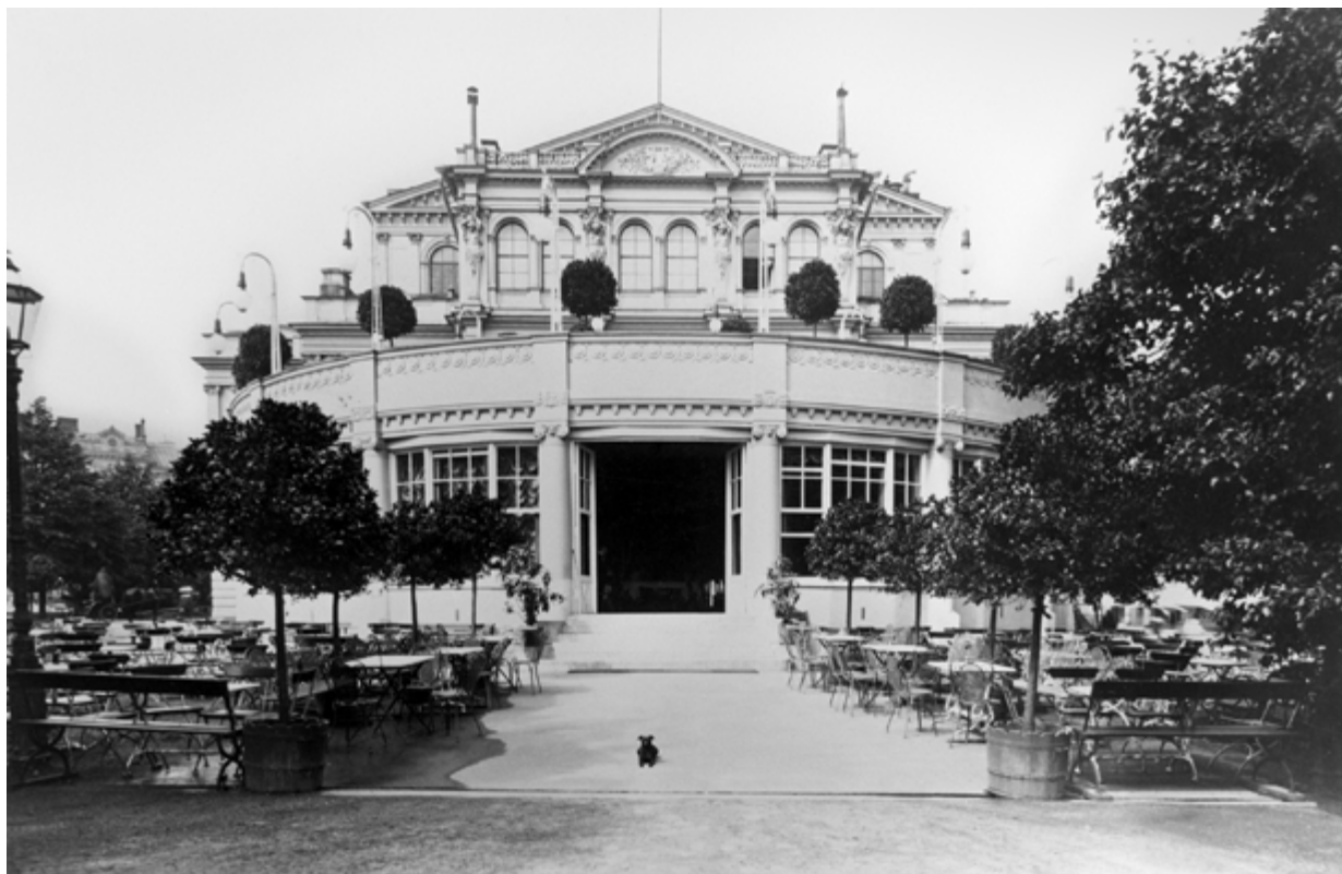
Kuva 74, yllä. Ruotsalaisen teatterin itäpäädyssä olevaa ravintola Oopperakellaria laajennettiin 1904-05 arkkitehtien Grahn, Hedman & Wasastjernan suunnitelmien mukaan. Puijen rotundan tilalle rakennettiin kivirakenteinen, huomattavasti suurempi rotunda, jonka katolle rakennettiin ulkoterassi. Valokuva on otettu n. vuonna 1915. HKMKA.
