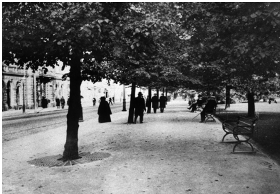
Kuva 133. Ennen Esplanadikatujen levennystä Runebergin esplanadin katujen puoleiset jalankululle varatut alueet olivat leveät. Niiden varrella oli penkkejä. Kadunpuoleisilla lehmuksilla oli koristeelliset juurisuoijat. Promenadimainen jalkakäytävä oli sorapintainen. Sen puistonpuoleisessa reunassa oli hulevesikoulu ja matala aita. K. E. Ståhlberg, noin v. 1900. HKMKA.
