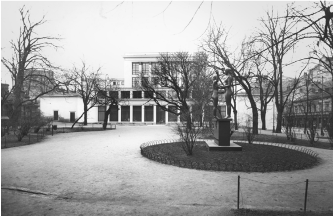
Kuva 142. Teatteriesplanadi on 1930-luvulta lähtien muuttunut moneen otteeseen. Ruotsalaista teatteria laajennettiin ja uudistettiin 1930-luvulla, ja puiston keskikäytävän varteen pystytettiin vuonna 1932 Zacharias Topeliuksen muistomerkki. Teatterin edustalla keskikäytävän reunassa olleet kaksi hevoskastanjaa eivät ole säilyneet tähän päivään. Roos, vuoden 1936 jälkeen. HKMKA.
