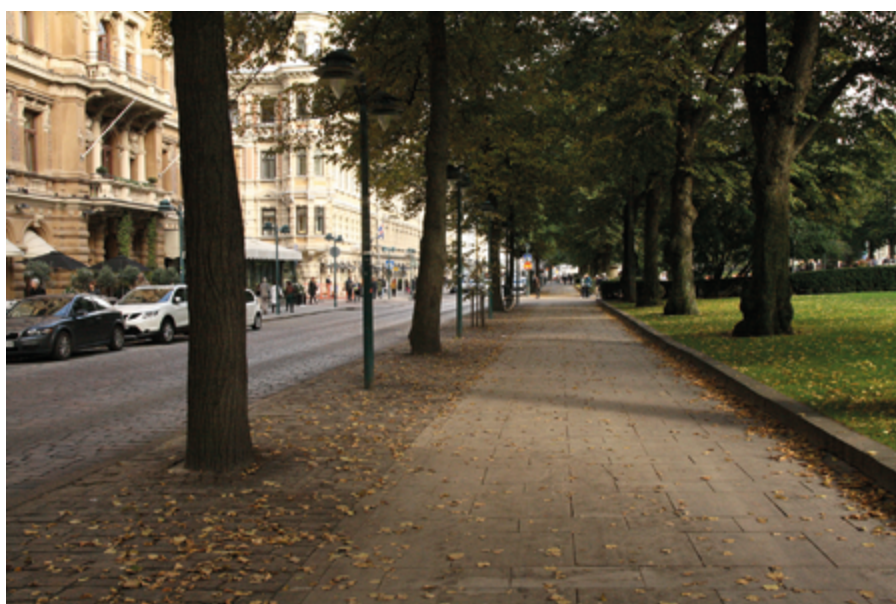
Kuva 135. Pohjoisesplanadi kunnostettiin 2000-luvulla, ja jalankulkukäytävät pinnoitettiin luonnonkivilaatoilla. Puistoalueen reunassa on nykyään reunakivi. Pohjoisesplanadin varrella on modernit valaisimet. Ajoin alustalla on kolme kaistaa, joista pohjoisin on pysäköintikäytävä. LP 2016.
