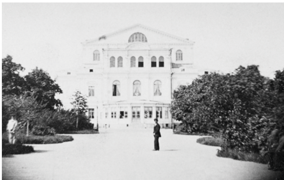
Kuva 160. 1860-luvun loppupuolella todennäköisesti otetussa valokuvassa on N. Benois'n suunnitelmien mukaan valmistunut teatterirakennus. Sen kaarevassa päädyssä oleva ravintola levitti tarjoilualueensa puistoon kesäisin. Puiston puusto on vielä suhteellisen pienikokoista, ja alueella on runsaasti pensaita. Keskikäytävän vasemmalla puolella näkyy pieni hevoskastanjan taimi. Tämä on todennäköisesti C. J. Helmin suunnitelman mukainen asu. MVKA.
