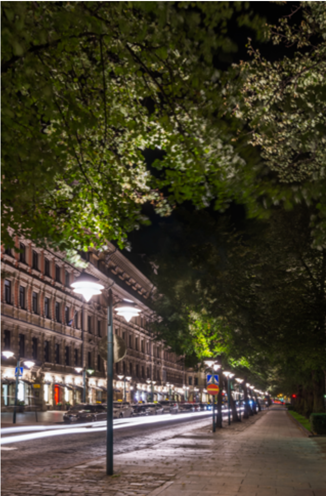
Kuva 126. Kadun valaisimet valaisevat sekä katuja että rajaavat katu-tilan valaisemalla samalla julkisivut ja puistoa reunustavat puurit. Valokuva Juhana Konttinen. Helsingin kaupunki.
