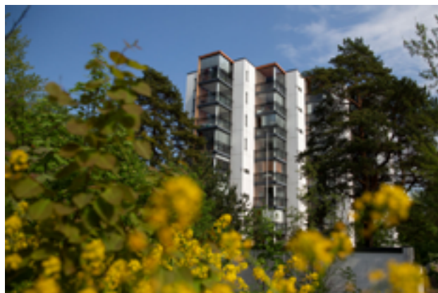
Kompletteringsbyggande i höghusområdet i Gårdsbacka
