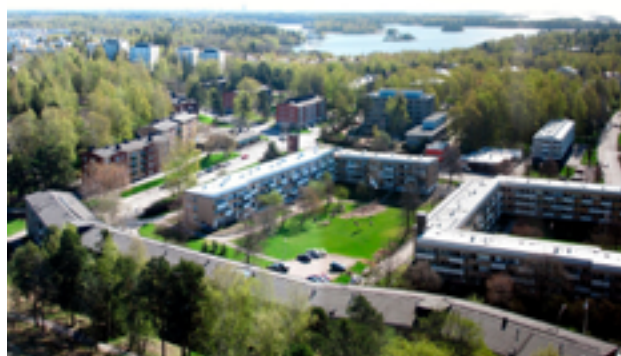
Kompletteringsbyggande i Kasberget
