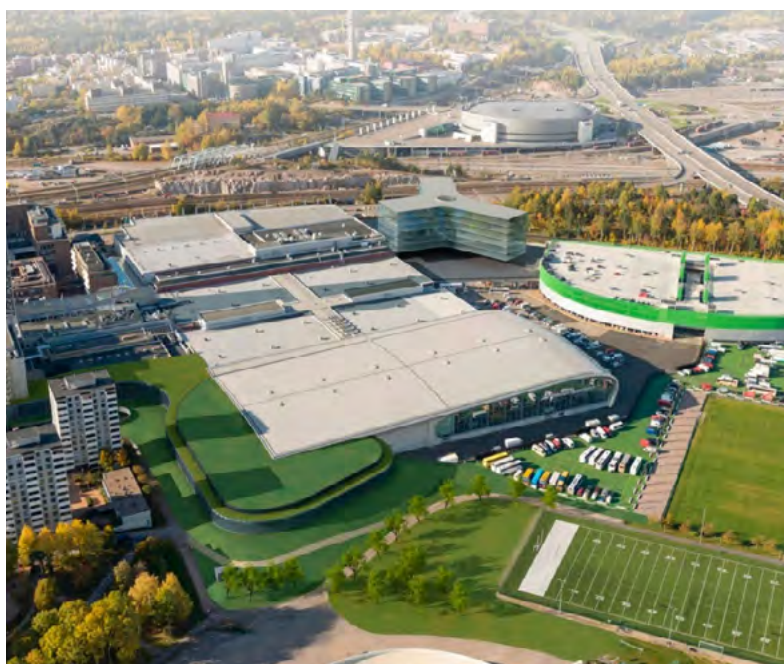
127. Messukeskuksen tonttia laajennetaan. © Arkkitehdit Davidsson Tarkela Oy
