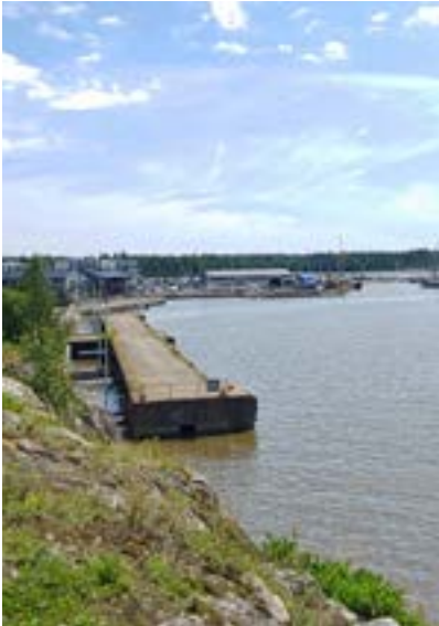
Betonilaituri, näkymä etelään
